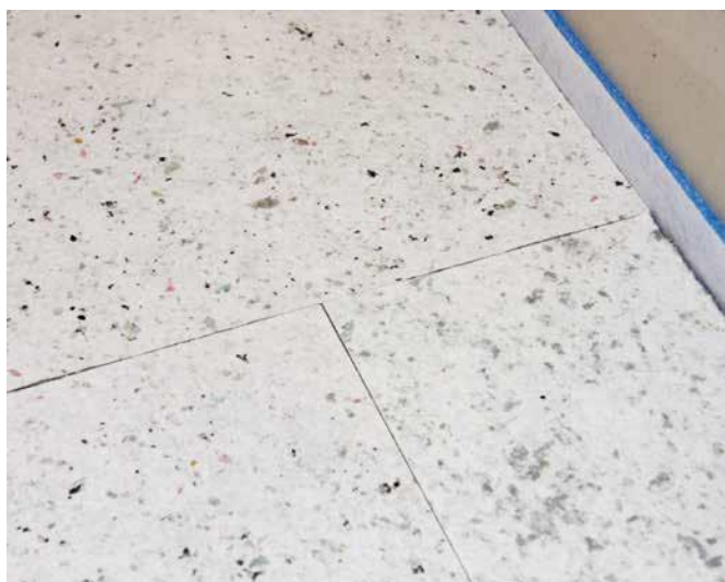
13 Układanie płyt następuje bezspoinowo. Krawędzie płyt przylegają do siebie.
