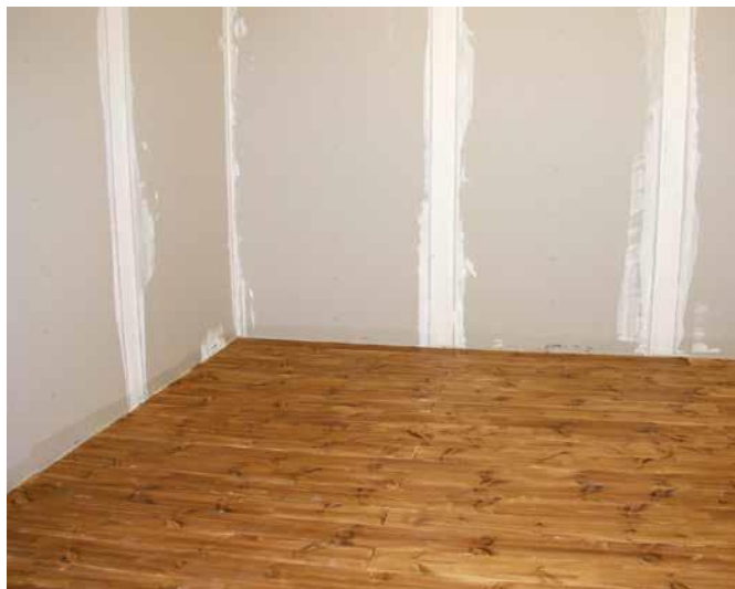
1 Podłoga z drewnianych desek, na której podczas renowacji zostanie ułożona okładzina ceramiczna.
