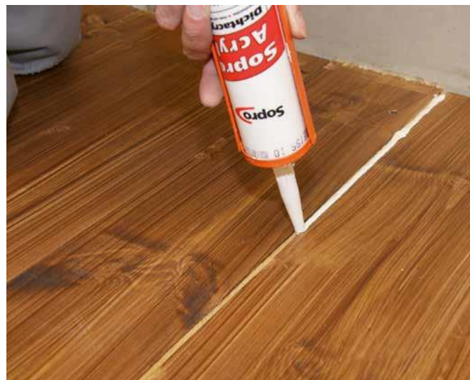
4 Aby samopoziomująca masa szpachlowa, zastosowana przy pracach wyrównawczych, nie wyciekła przez szczeliny podłogi, należy wypełnić je akrylem.
