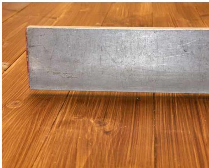
3 Podłozę należy sprawdzić pod kątem nierówności. W przypadku ich wystąpienia podłogę wyrównać.
