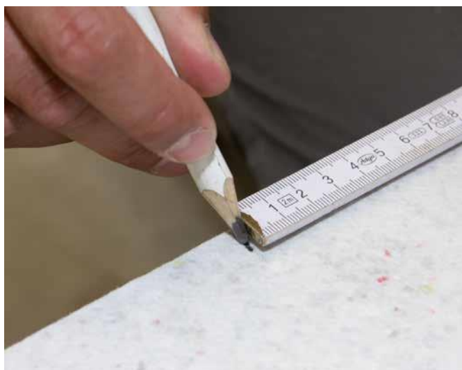
3 Zaznaczyć właściwy wymiar na powierzchni płyty izolacyjnej celem wykonania precyzyjnego przycięcia.
