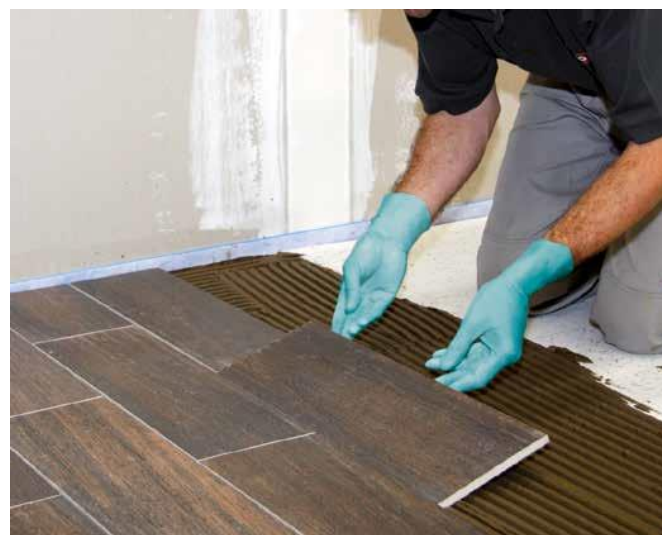
16 Układanie płytek ceramicznych na przygotowanej warstwie zaprawy klejowej.
