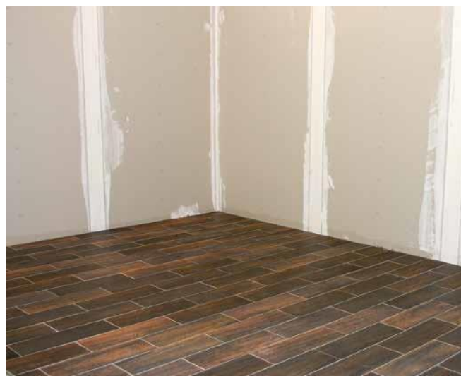
18 Gotowa okładzina ceramiczna na drewnianym podłożu.
