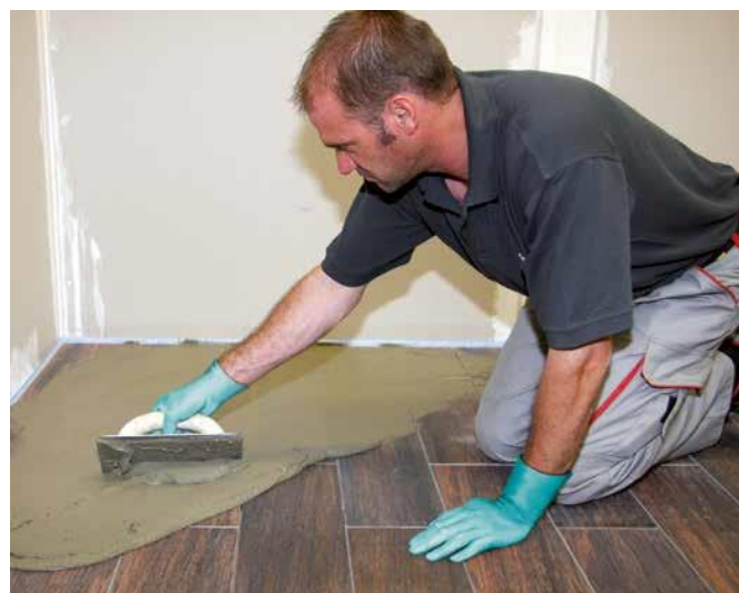
17 Fugowanie płytek fugą elastyczną np. Sopro DF 10 ® .
