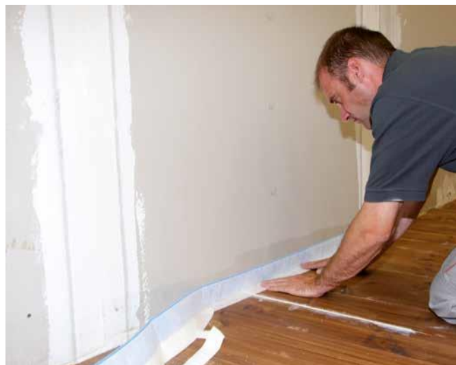
5 W miejscach styku ścian i podłogi zamontować taśmę dyatacji brzegowej.
