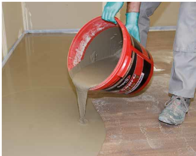
7 Szpachlowanie nierówności za pomocą wylewki samopoziomującej Sopro VS 582.
