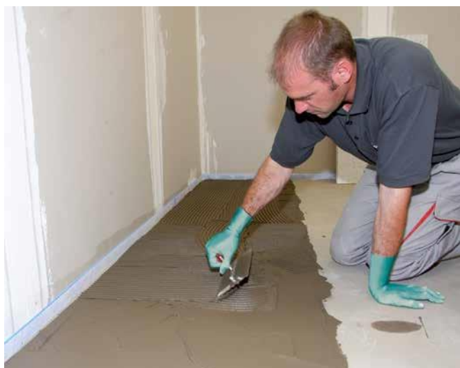
9 Jeżeli podłoże drewniane jest równe, bezpośrednio na preparat gruntujący Sopro HPS 673 nałożyć zaprawę klejową np. Sopro No.1 400 extra w celu przygotowania powierzchni pod płyty izolacyjne Sopro FDP 558.
