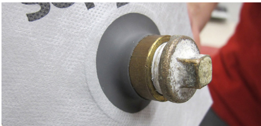
Kołnierz gumowy uszczelki ściennej Sopro DWF 089 ściśle przylega do rury, tworząc szczelne i elastyczne połączenie między rurą a ścianą.
