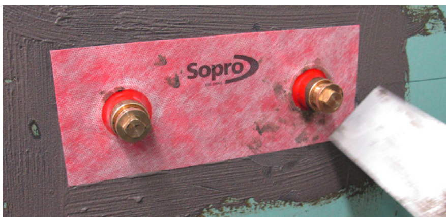
Uszczelka z dwoma kołnierzami gumowymi Sopro AEB 132
