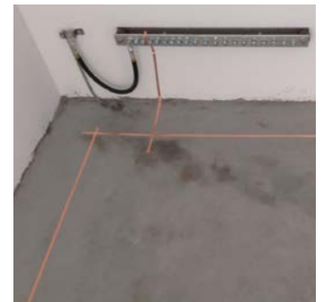
Aangesloten koperband op de potentieel egalisatie rail.
