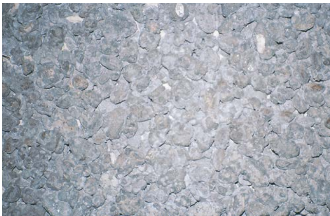
Poreuze cementdekvloer, met open poriën.
