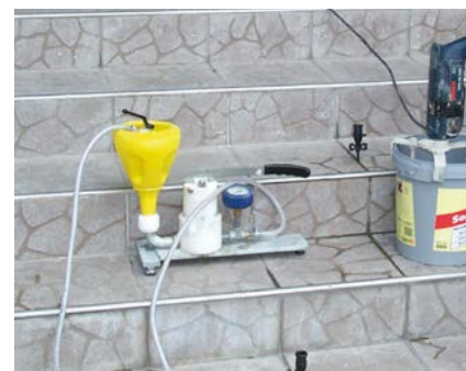
Injecteren van hol liggend afwerkingsmateriaal op een trap.
