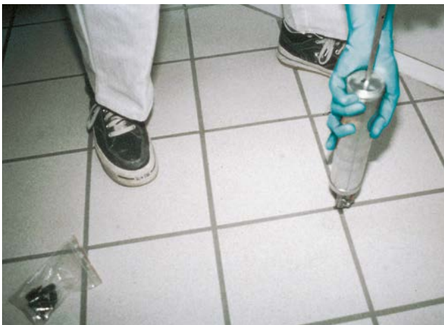
Injecteren met een handspruit voor kleine vlakken.
