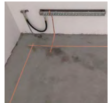
Aangesloten koperband op de potentieel egalisatie rail.
