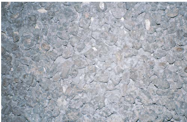
Poreuze cementdekvloer, met open poriën.
