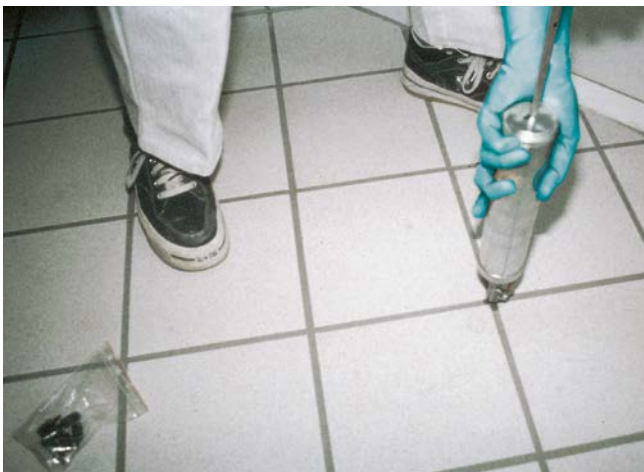
Injecteren met een handpers voor kleine vlakken.
