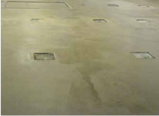
1 Sopro FS 15 plus önterülővel kiegyenlített aljzat, lealapozva a következő rétegekhez.
