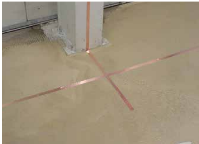
4 Szalag fektetése a következő rétegre a későbbi feszültségkiegyenlítés érdekében
