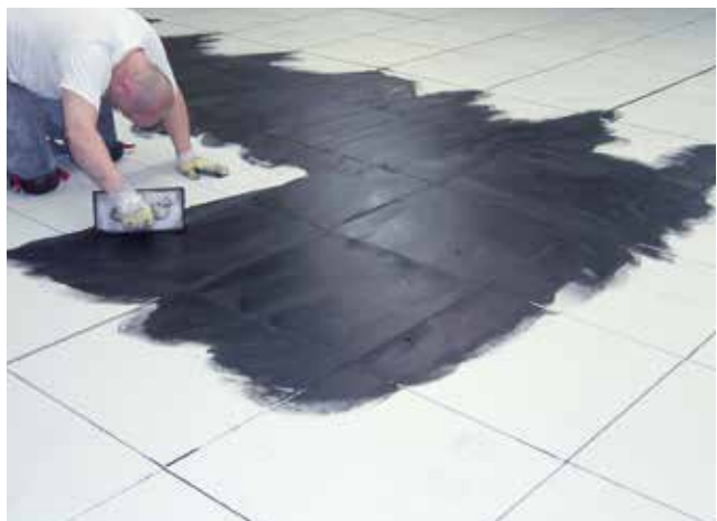
6 Fugázás Sopro Flexfuge plus-szal Sopro Electra Leitdispersion (ELD 458) elektromosan vezetőképes disperzió hozzáadásával.
