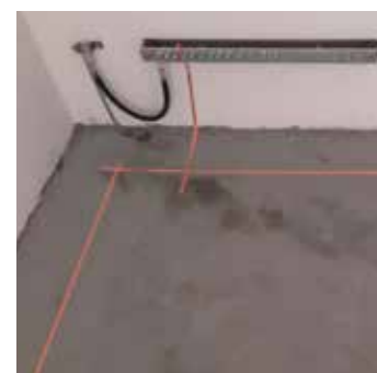
A feszültségkiegyenlítő sínekbe bekötött szalag.
