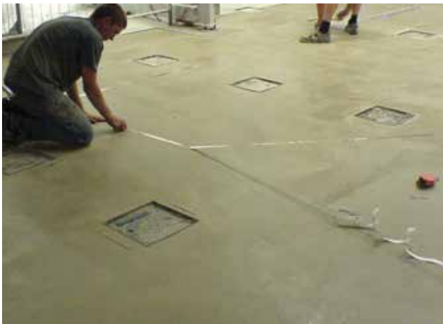
3 A szalag felragasztása a megfelelő rácsszerkezetben.
