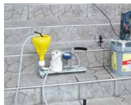
Üreges burkolat injektálása lépcsőn.
