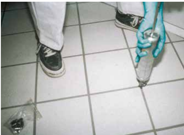
Kézi fecskendővel történő anyagbevitel kis felületen.
