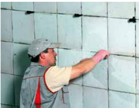
FliesenPacker injektáló csavar csempéhez 6 mm
