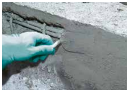
4 Javítóhabarcs bedolgozása
