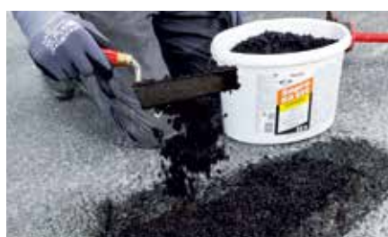
2 Sopro KaltAsphalt felhordása
