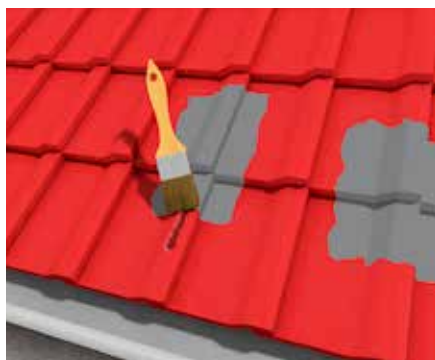
Tetőcserepek szigetelése és javítása
