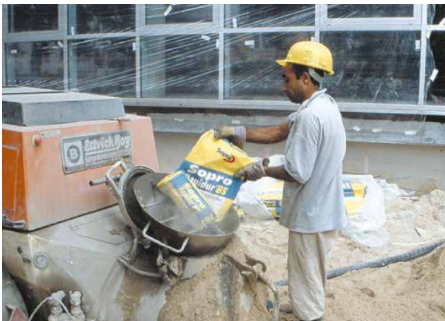
Mise en œuvre simple du Liant Sopro Rapidur® B 5 grâce au dosage facile sur le chantier.
