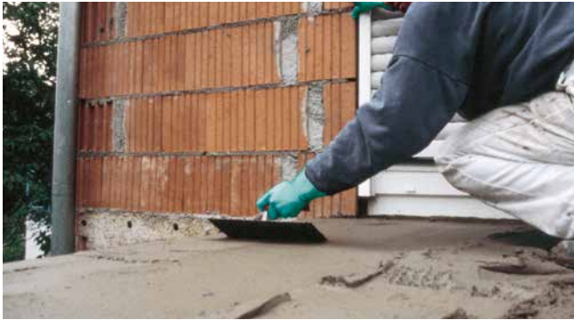
Réalisation d'une enduction inclinée avec le Mortier de rénovation Sopro RAM3® 454 ou le Ragréage d'égalisation avec trass Sopro AMT 468 sur une dalle de béton en console
