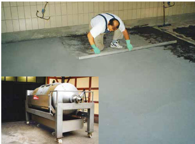
Application du mortier époxy haute résistance pour l'absorption d'importantes charges ponctuelles mobiles.
