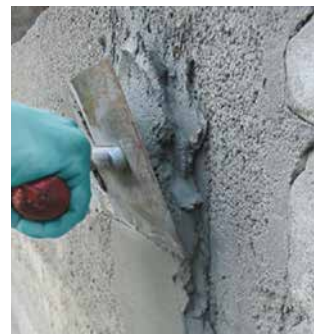
Egalisation de la maçonnerie avec le Mortier de rénovation Sopro RAM 3® avant la pose de carreaux et dalles sur mortier-colle
