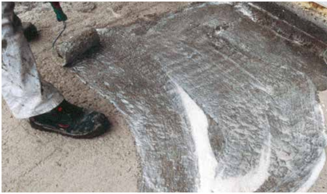
Préparation du support avec l'Emulsion d'accrochage Sopro HE 449 pour une mise en œuvre frais sur frais
