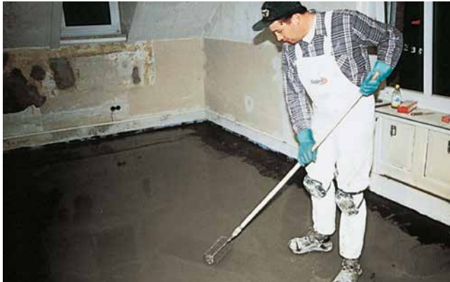
Répartition et débullage du Ragréage fibré autonivellant Sopro FAS 551 avec un rouleau débulleur sur un support en bois.
