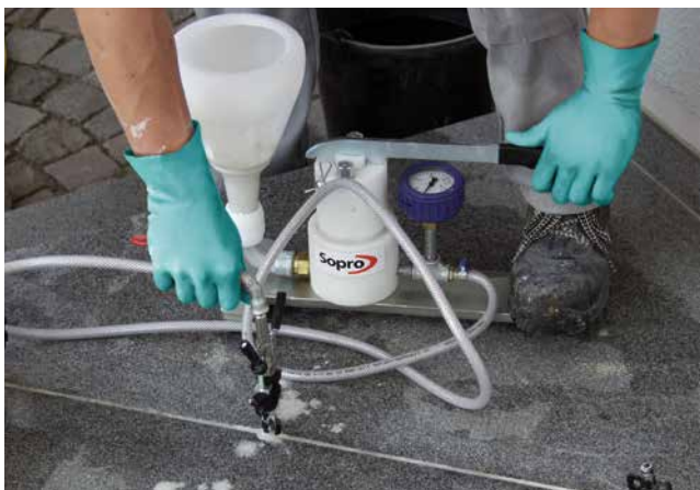
Colmatage par injection basse pression (15 bar).
