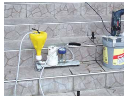
Réparation d'une „zone creuse“ sous le revêtement d'un escalier.
