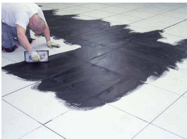
6 Jointoiment de la surface avec le Joint flexible Sopro FL adjuvanté de Dispersion conductrice Sopro ELD 458.
