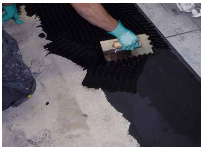
5 Pose de la céramique avec le mortier-colle adjuvanté conducteur.
