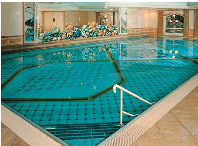
Jointes très résistants, stables au courant, pour les zones immergées (en construction de piscine).
