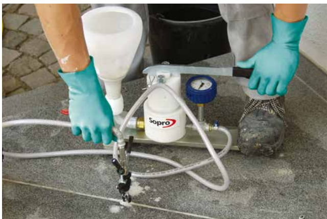
Verpressung mit Injektionspresse (15 bar).
