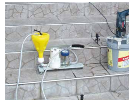
Verpressung eines hohlliegenden Belags auf einer Treppe.
