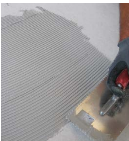
Aufkämmen des hellen Dünnbettmörtels (Sopro Marmor-& Mosaik-Flexkleber/Sopro DesignFugen-Epoxi DFX weiß)
