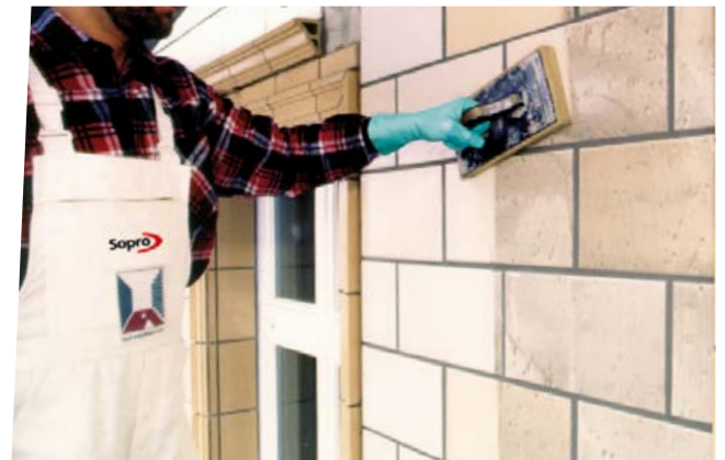
Abwaschen der eingeschlämmten Flächen.
