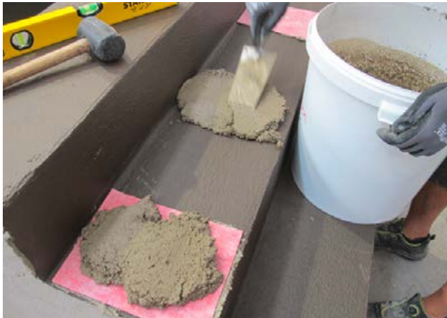
Aufkleben der Gleitlager (Sopro AEB® plus) an den Enden der Stufe.
