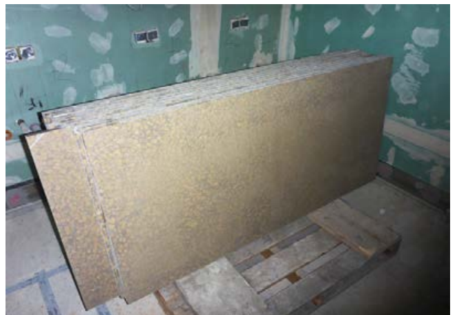
Platten auf der Baustelle mit Harz rückseitig abgesperrt.
