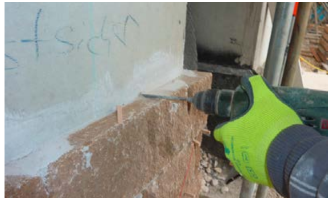
Bohren der Löcher für die mechanische Verankerung der Vorsatzschale mit Drahtanker.
