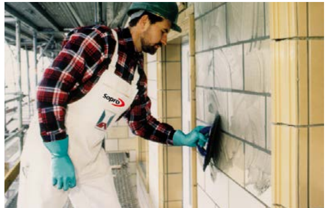
Einschlämmen des hydraulisch abbindenden, flexiblen Fugenmörtels.
