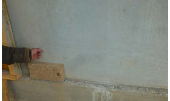
Aufstandsfläche auf der Kellerbetonbodenplatte.
