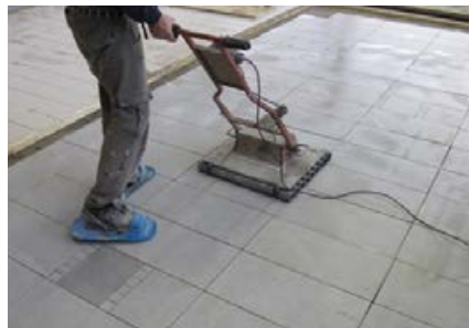
Einrütteln des frisch verlegten keramischen Belags mit dem Oberflächenrüttler.
