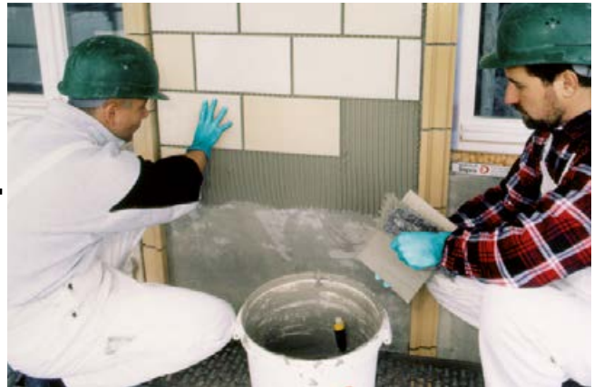
Kombiniertes Verfahren Rückseite Fliese.
