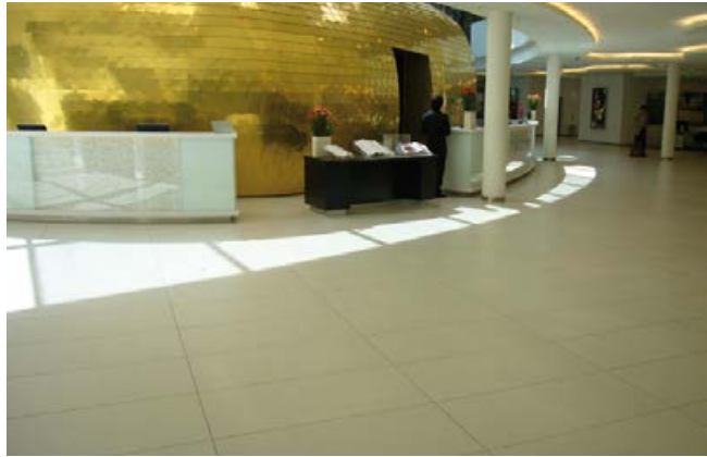
Großformatige Fliesen in einer Hotellobby.
