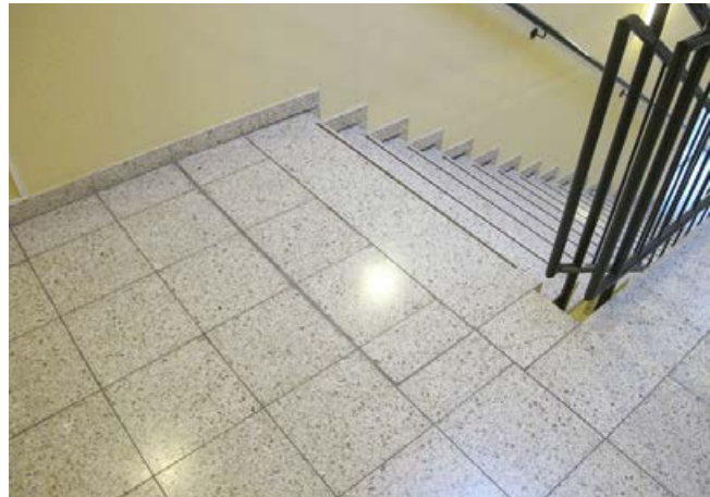
Betonwerkstein in einem Treppenhaus.
