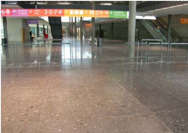
Betonwerksteinboden im Eingangsbereich eines öffentlichen Gebäudes.
