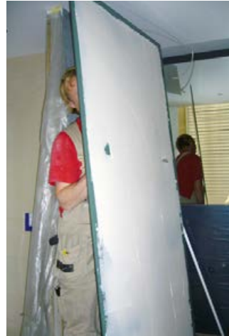
Großformatige Glasplatten lassen sich mit Sopro PU-Kleber sicher verlegen.
