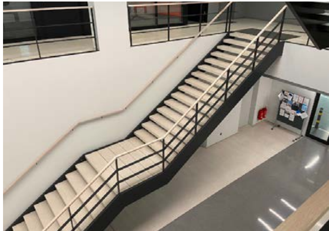
Treppe mit Betonwerkstein belegt.
