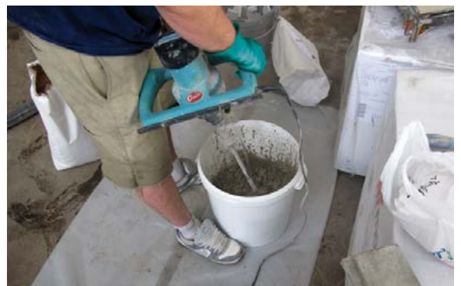
Die Rüttelschlämme ist mit Wasser maschinell anzumischen.
