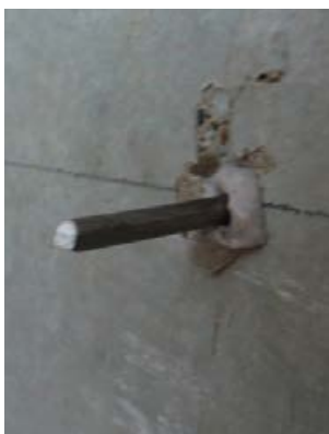
Eingesetzter Drahtanker für die mechanische Befestigung.
