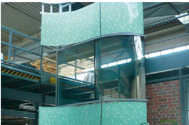
Glasmosaikverlegung auf einer Trägerplatte für einen Fassadenaufbau.
