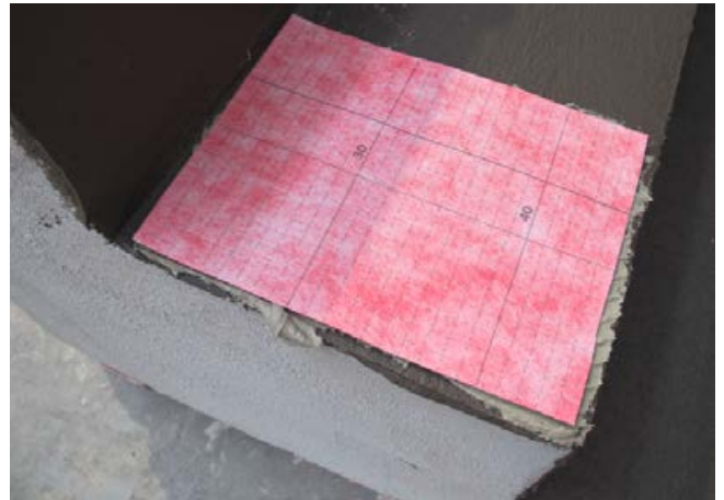
Herstellung der Mörtelstreifen, z. B. mit Sopro VarioStone.
