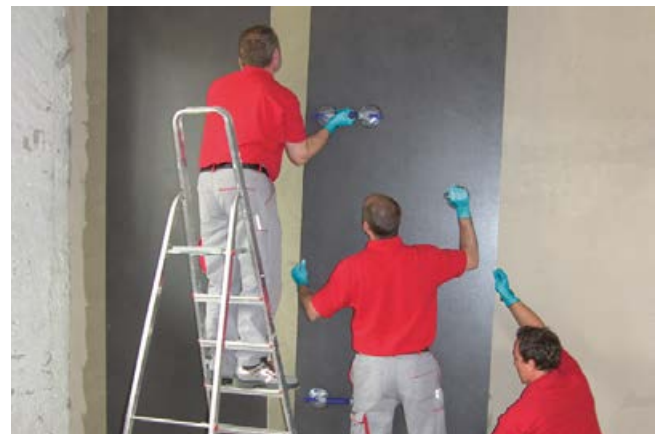
Ansetzen einer Großformatplatte an der Wand mit Sopro MG-Flex ® XXL schnell, oder wahlweise auch mit Sopro FKM S2.
