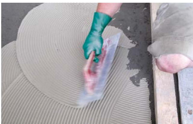
Verteilen der Rüttelschlämme auf dem frischen Bettungsmörtel.
