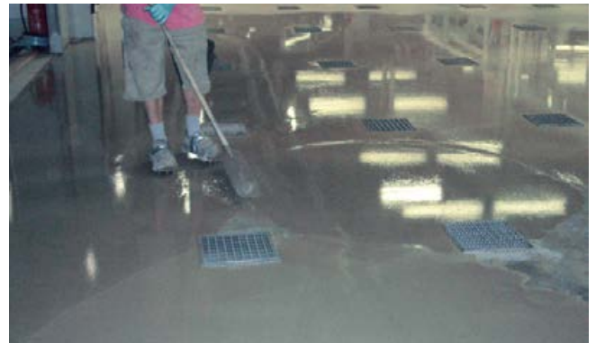
Einbau von Sopro FS 15 ® plus zur Herstellung einer planebenen Oberfläche.
