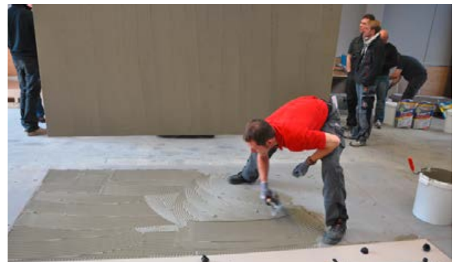
Kleberauftrag auf der Rückseite der Platte und auf dem Untergrund.
