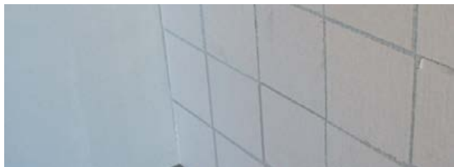
Vorderseitig mit Papier fixiertes Glasmosaik, hier für die Verlegung im Unterwasserbereich.
