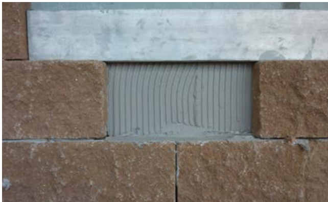
Ansetzen der Betonverblender auf dem Betonuntergrund mit Sopro FKM® Silver im Buttering-Floating-Verfahren.
