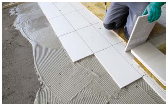
Verlegen der Großformatplatten in die frische Rüttelschlämme. Anschließend erfolgt das Einrütteln.
