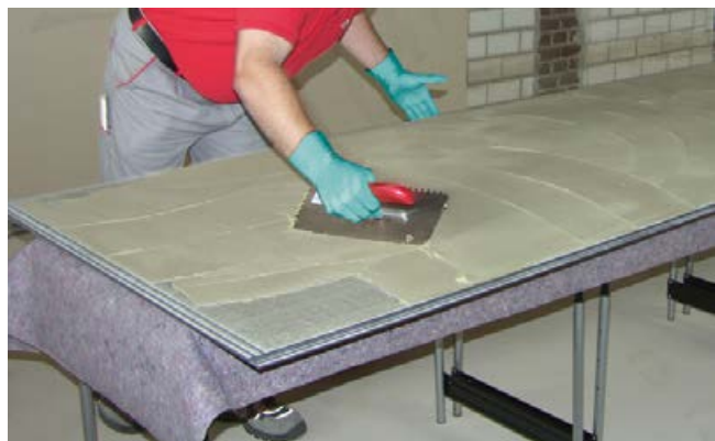
Eine entsprechende Baustelleneinrichtung ist notwendig, um die Großformatplatten für die Verlegung vorbereiten zu können.
