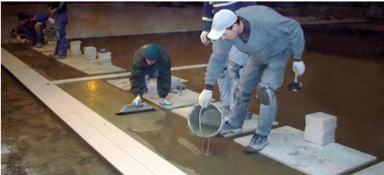
Aufbringen der Sopro RüttelSchlämme auf dem vorbereiteten Mörtelbett.
