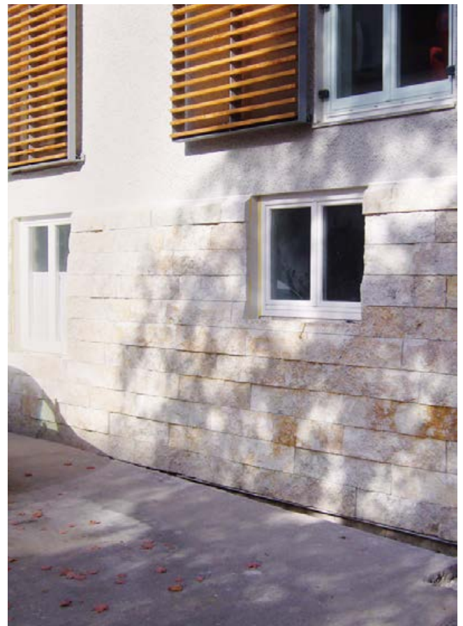
Anmauerung auf einer Aufstandsfläche.
