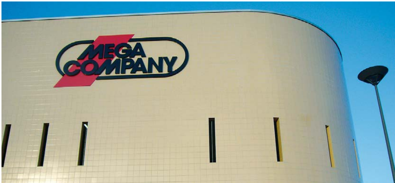
Fassade mit keramischen Fliesen.
