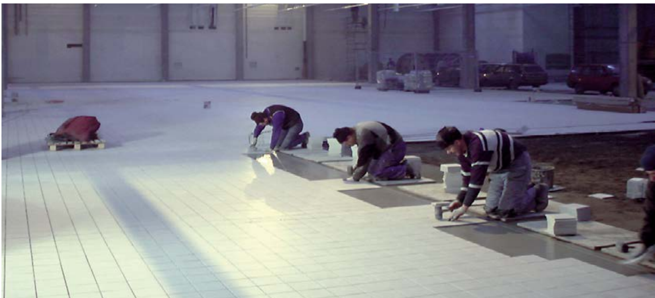
Verlegen der Keramik in die frische Sopro RüttelSchlämme.
