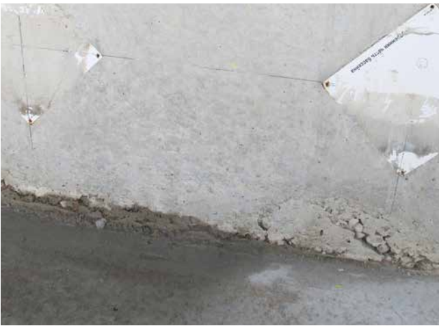
Kiesnester im Anschluss Wand-Boden.
