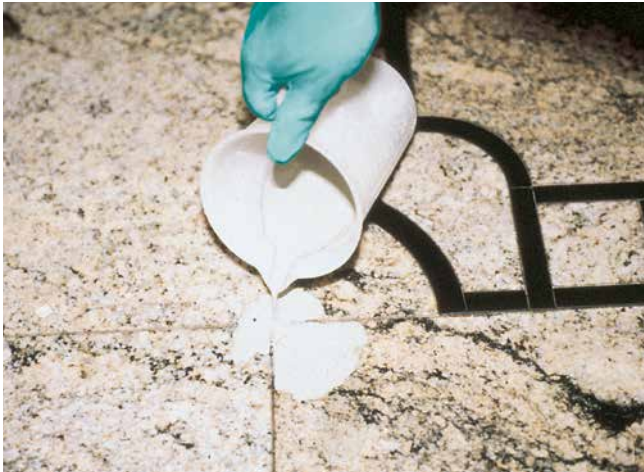
Verfüllen über eine offene Fuge.
