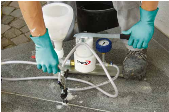
Verpressung mit Injektionspresse (15 bar).
