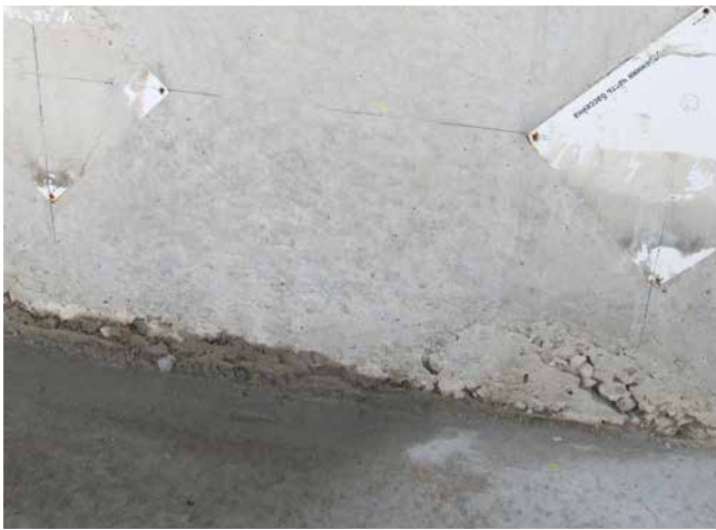
Kiesnester im Anschluss Wand-Boden.
