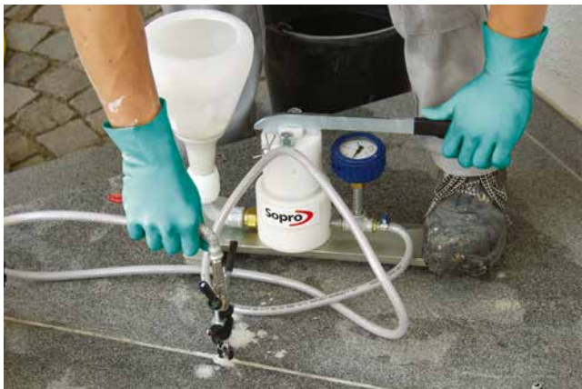
Verpressung mit Injektionspresse (15 bar).
