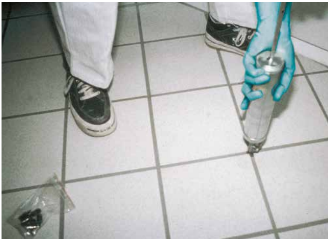
Verpressen mit Handpresse für kleine Flächen.
