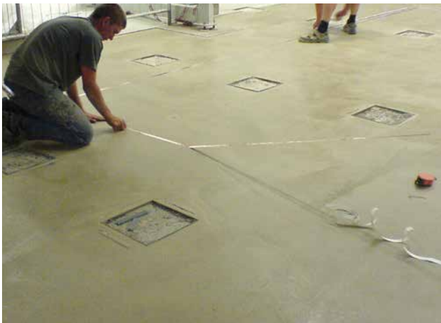
3 Aufkleben der Kupferbänder mit entsprechendem Rastermaß.
