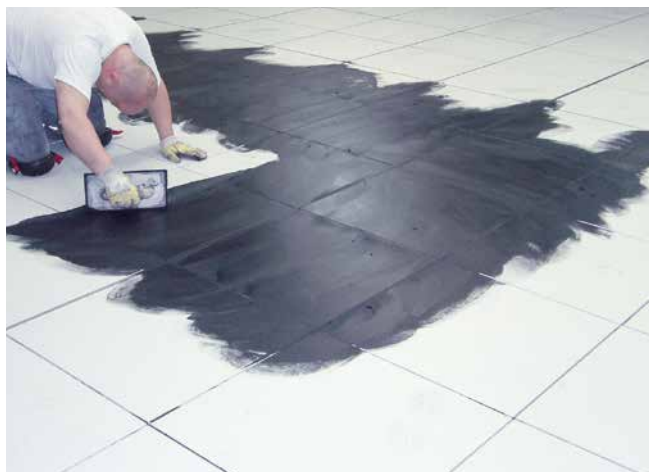
6 Verfugen der Flächen mit Sopro FlexFuge plus mit Zugabe von Sopro Electra Leitdispersion.
