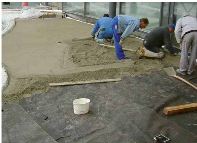
3 Herstellung der lastverteilenden Schicht mit Sopro DrainageMörtel eXtra.
