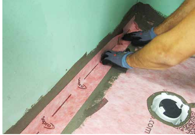
4 Einkleben der Formteile (Ecken und Bänder).
