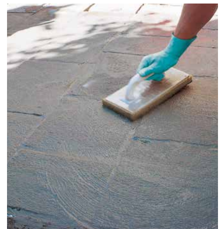
Kleinflächenreinigung mit Schwamm Brett.
