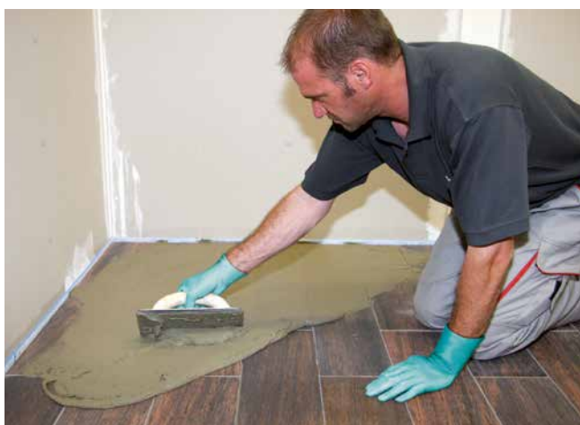
17 Verfugen der Fläche mit Sopro FlexFuge plus oder Sopro DF 10® DesignFuge Flex.
