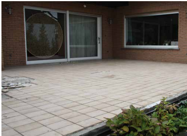
1 Alter, tragfähiger Fliesenbelag auf einer Terrasse.
