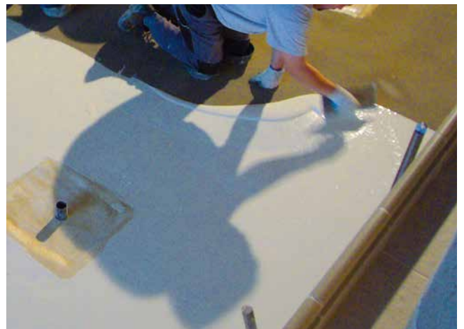
6 Abdichten eines Beckens mit Sopro PU-FlächenDicht.
