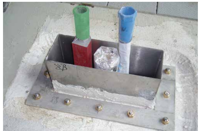
Durchdringungsbauteil mit Pressdichtflansch eingedichtet mit einer Verbundabdichtung.
