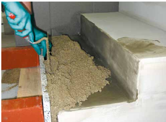
4 Verlegen der Setzstufe im Sopro DrainageMörtel eXtra.
