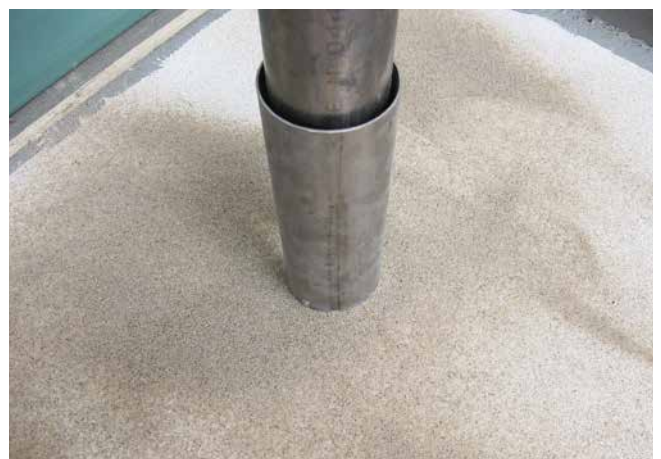
6 Eingedichtete Hüllrohre, das Sopro PU-FlächenDicht ist mit Quarzsand abgeworfen.
