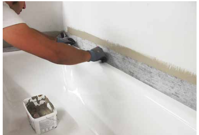
2 Eindichten des Franz Kaldewei GmbH & Co. KG-System-Bandes mit Sopro FlächenDicht flexibel.
