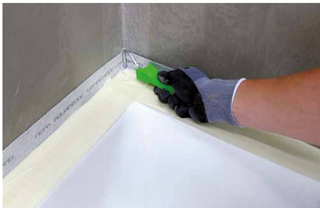
3 Die senkrechte Perforierung muss in den Ecken geweitet werden um einen Anschluss herstellen zu können.
