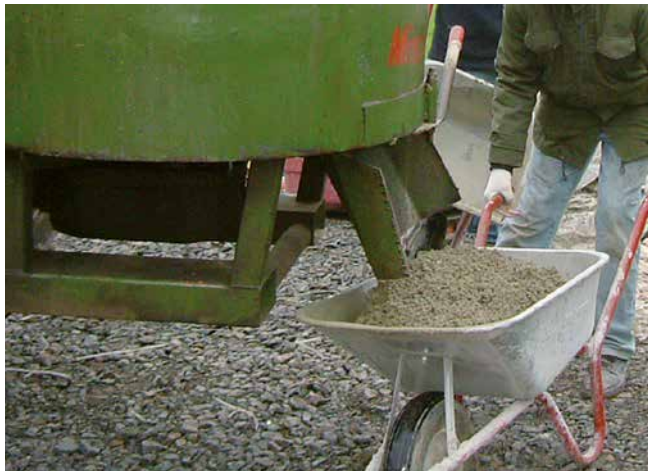
1 Anmischen des Mörtels mit Zwangsmischer oder Estrichpumpe.
