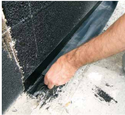
5 Aufkleben der SoproThene®-Teilstücke mittig auf dem SoproThene® Klebeband (Verschweißungsband).
