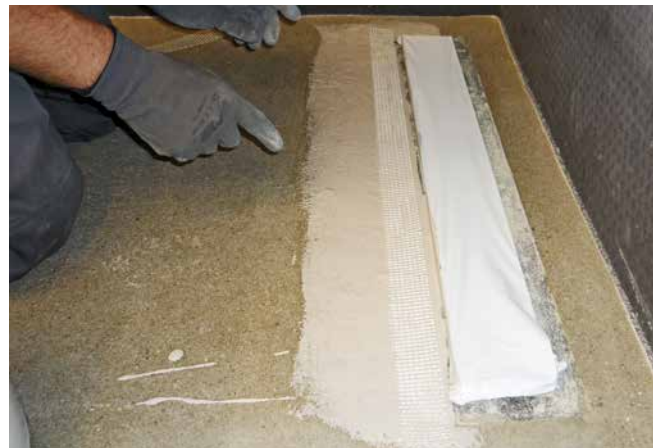
4 Eindichten des Rinnenkörpers mit Sopro DichtSchlämme Flex 1-K. Der Übergang wird durch Einlegen eines Armierungsgewebestreifens in die Verbundabdichtung verstärkt.
