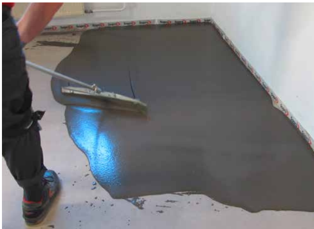
Verteilen von ambiente® floor in der Fläche mittels Rackel.
