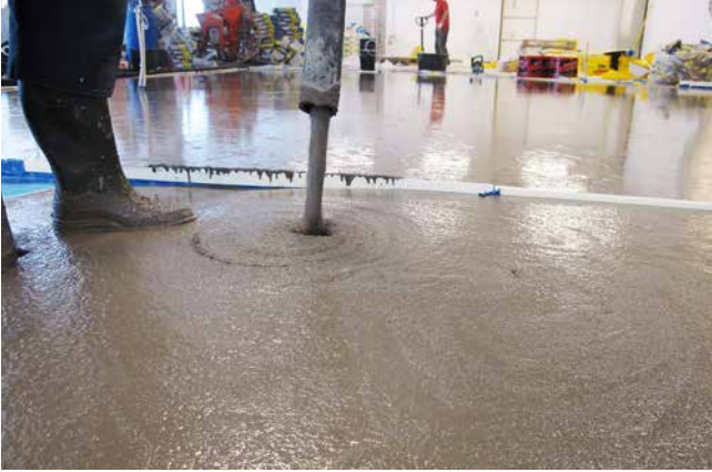
Einbau von Sopro Rapidur® FE – zementärer Fließestrich.
