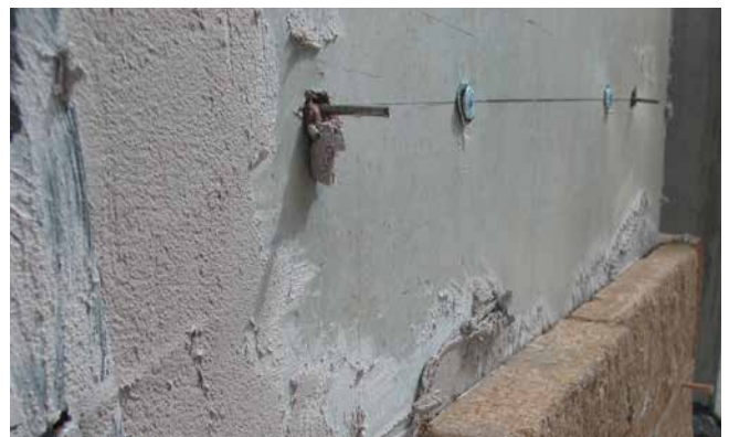
Die Anker sind genau einzumessen und je m 2 entsprechend zu verteilen.
