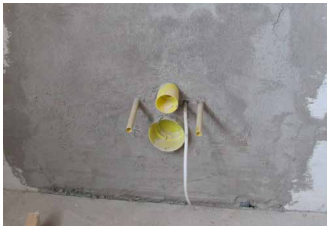
Wandfläche mit Zementmörtel (Sopro RAM3®) verputzt/gespachtelt.
