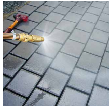
Betonsteinpflaster gut vornässen.
