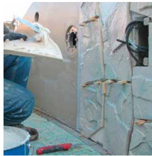
Verklebung der Keramik mit Sopro PU-Kleber im direkten Kontakt auf der Metalloberfläche.
