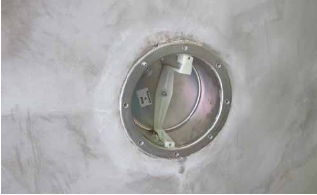
1 Einbetonierter Scheinwerfer.
