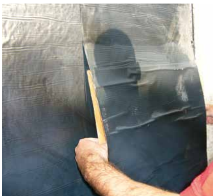
16 Ansetzen der nächsten Bahn.
