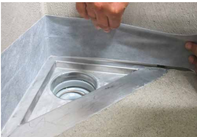
5 Sorgfältiges Eindichten des Entwässerungselementes mittels selbstklebender Dichtbänder (Sopro FlexDichtBand).
