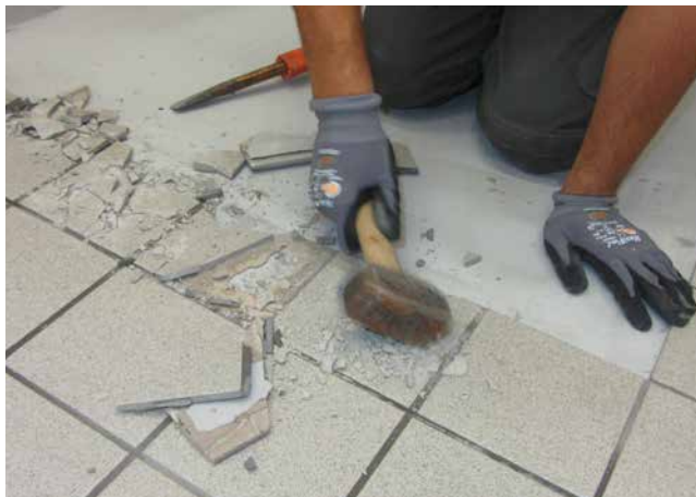
2 Zertrümmern der Fliesen mit anschließendem vorsichtigem Rückbau ohne die Abdichtung zu verletzen.
