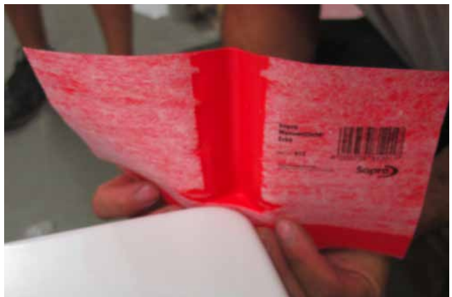
2 Ankleben der Sopro WannendichtEcke, welche sich im unteren Bereich an den Radius der Wanne anpasst und im Bereich der Wandanbindung einen 90°-Winkel besitzt.
