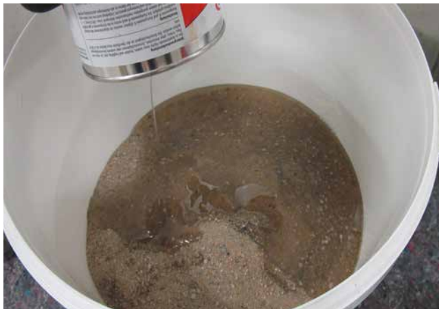
2 Anmischen von Sopro BauHarz und Sopro EpoxiEstrichKorn zu einem harzgebundenen Estrichmörtel.
