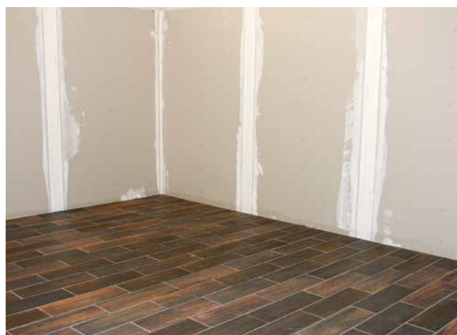
18 Entkoppelter keramischer Belag auf einem Holzuntergrund.
