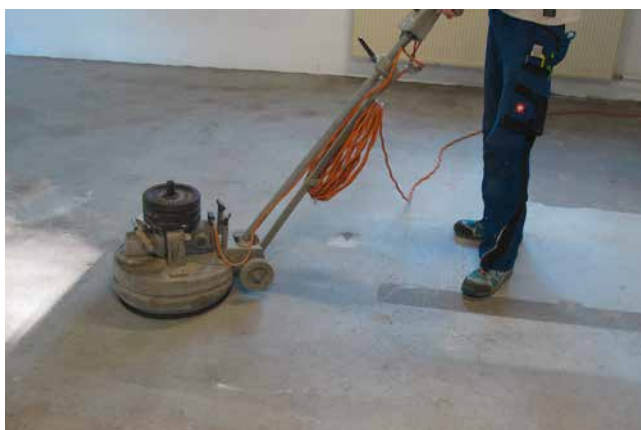
Schleifen von calciumsulfatgebundenen Estrichen als wichtige Vorbereitung für einen dauerhaften Verbund des Fliesenbelags.
