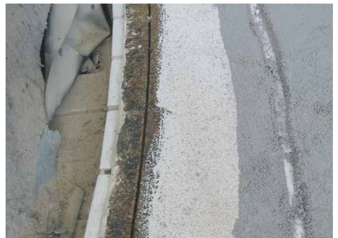
Einschnitt einer Verwahrnut im Beckenkopf zur Aufnahme der Flächenverbundabdichtung.
