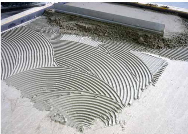
Mit Flexklebern lassen sich für den folgenden Estrichmörtel sehr gute „frisch-in-frisch“-Haftbrücken herstellen.
