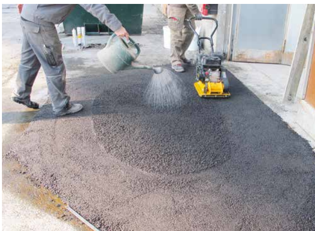
Der Kaltasphalt wird anschließend mit einer Rüttelplatte verdichtet.
