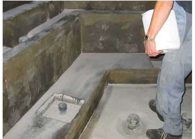
2 Abstreuen der frischen Sopro Epoxi-Grundierung mit Sopro Quarzsand fein.
