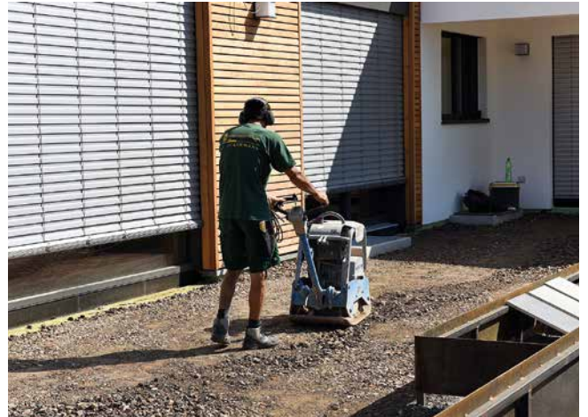
Verdichten der ungebundenen Trag- und Frostschutzschicht.
