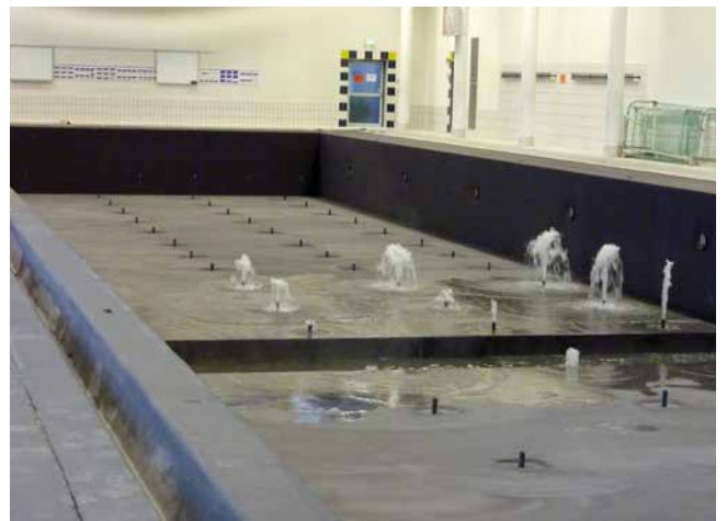
2 Mit Sopro TurboDichtSchlämme 2-K abgedichtetes Becken vor der Dichtigkeitsprüfung.
