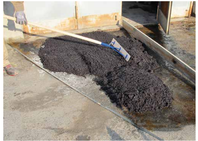
Der Kaltasphalt wird aufgetragen ...
