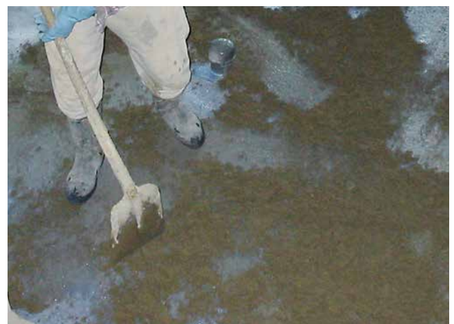
Einbau eines Verbundestrichs: Einarbeiten eines Estrichmörtels in die frische Haftbrücke.
