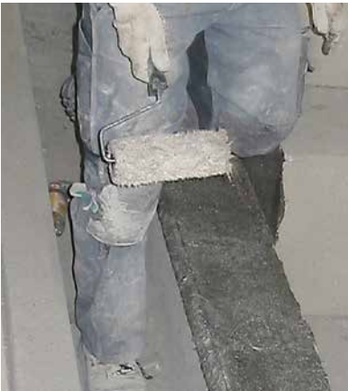
Auftragen der Sopro Epoxi-Grundierung als Haftbrücke zum kraftschlüssigen Auffüttern einer Mauerkrone.
