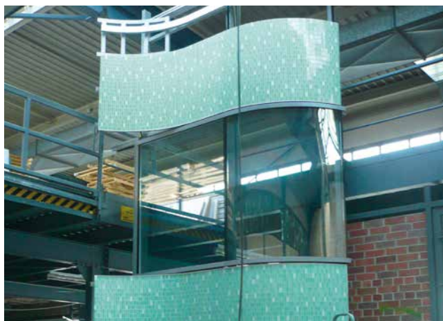
Glasmosaikverlegung auf einer Trägerplatte für einen Fassadenaufbau.
