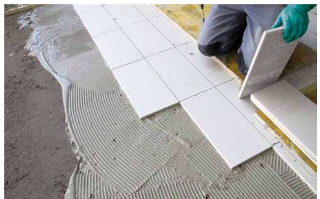
Verlegen der Großformatplatten in die frische Rüttelschlämme.
