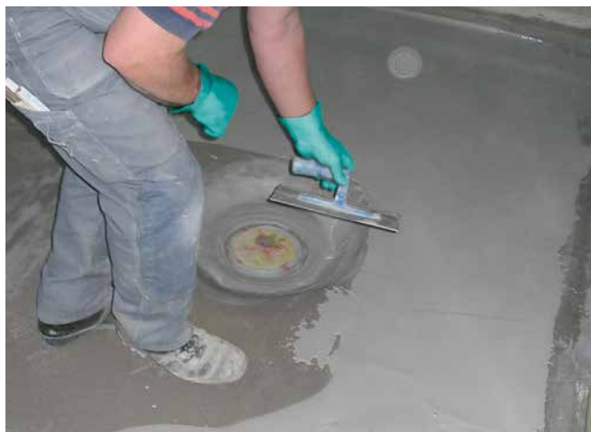
Applikation der flexiblen, mineralischen Dichtungsschlämme.
