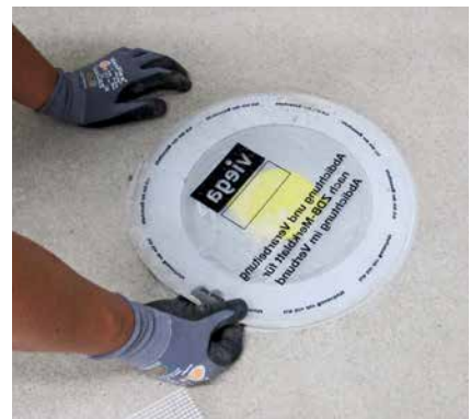
System Viega: Der Bodenablauf besitzt einen Klebeflansch, auf welchem die Verbundabdichtung appliziert wird.
