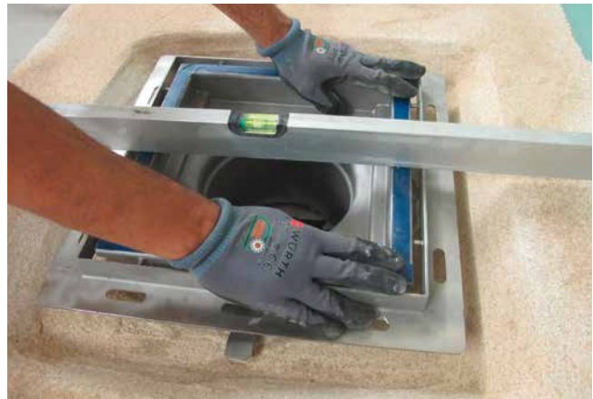
Das Aufstockelement (Firma ETU) des Bodenablaufs ist genau auf die notwendige Höhe zu setzen und auszurichten.
