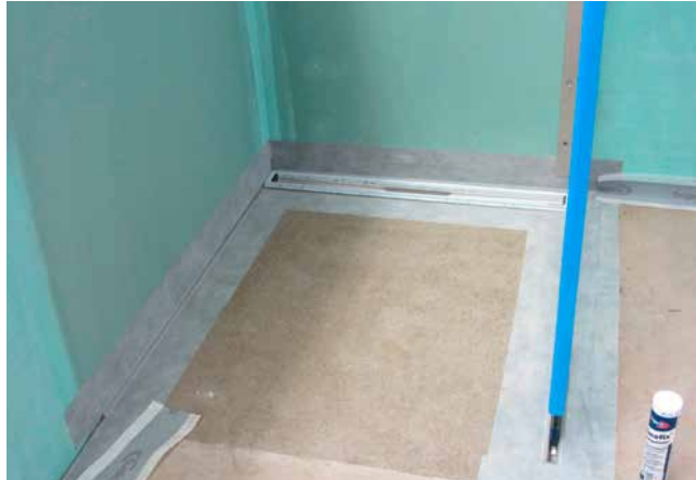
4 Die Glasscheibe sitzt sicher in der Bodenschiene des Duschrinensystems.
