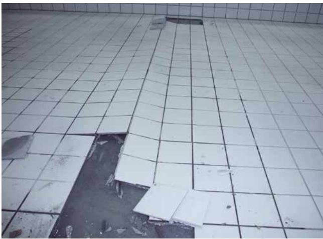
Dachförmiges Aufstellen eines Fliesenbelages auf einem Beckenboden.
