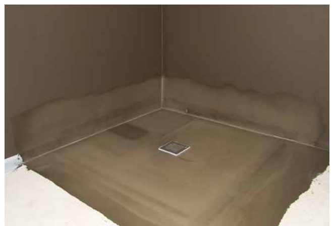
6 Abgedichtete Fläche, bereit für die folgende Fliesenverlegung.
