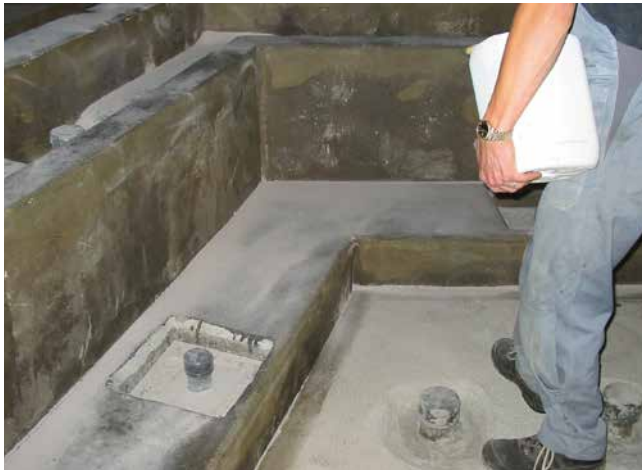
1 Aufbringen der Sopro Epoxi-Grundierung, anschließendes Abstreuen mit Sopro Quarzsand fein.
