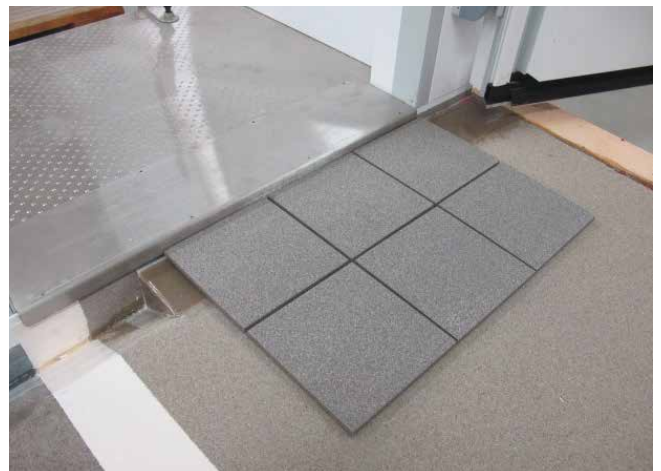
Türanschluss einer Kühlzelle.
