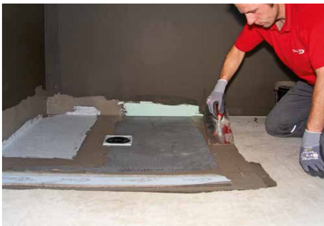
5 Abdichten der Fläche mit Sopro TurboDichtSchlämme 2-K und Dichtbändern sowie konfektionierten Dichtbahnstücken.
