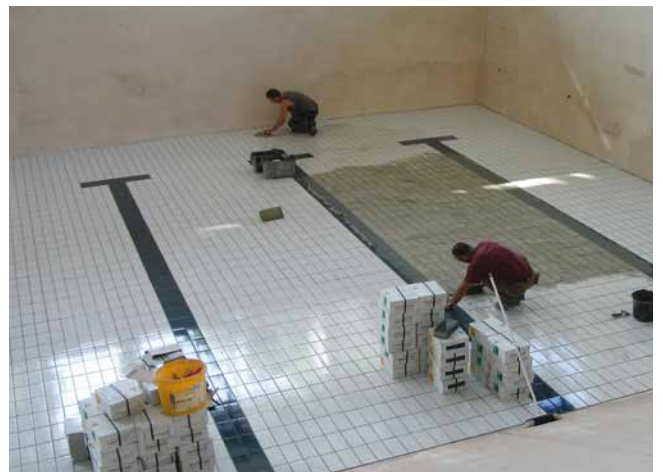
4 Verfugen der Flächen mit hochfester Sopro TitecFuge®.
