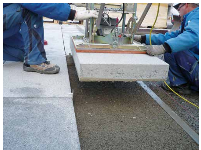
Für die Gestaltung von Plätzen werden heute neben Natursteinplatten auch großformatige Betonplatten verwendet.
