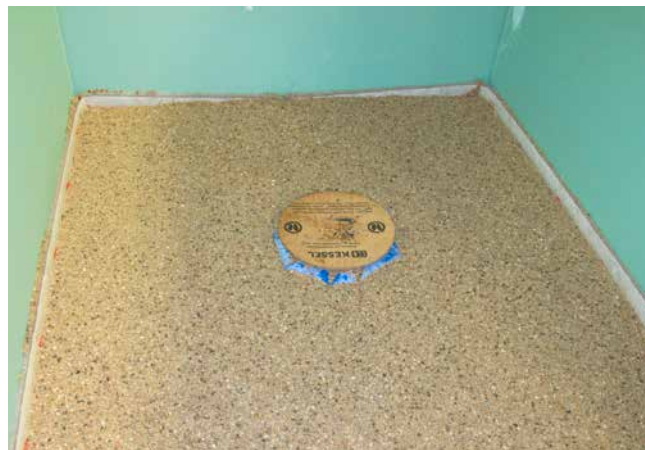
5 Bodenablauf eingebunden in den harzgebundenen Estrich (Sopro BauHarz + EpoxiEstrichKorn), bereit für den Abdichtprozess.
