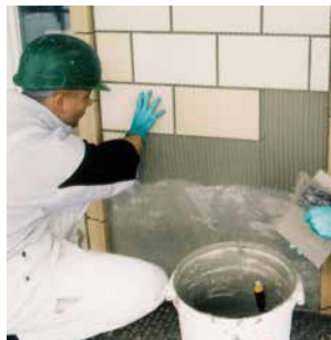
Kombiniertes Verfahren Rückseite Fliese.
