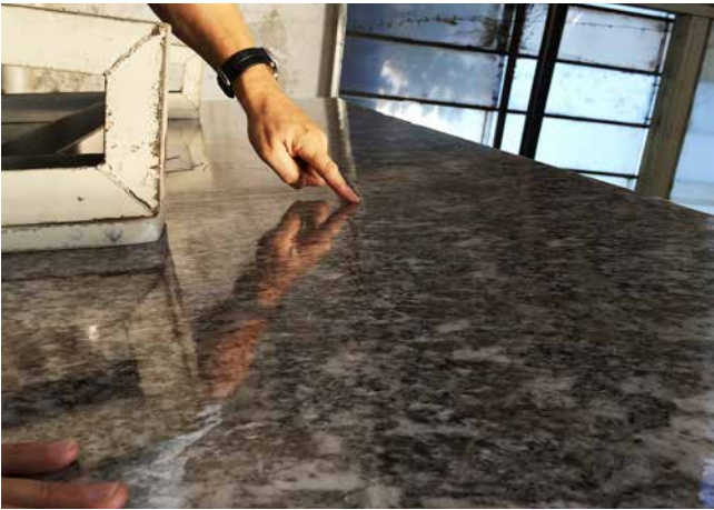
Mit Harz behandelte Oberflächen, um Risse etc. zu behandeln.
