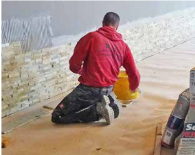
Verlegung der Natursteinriemchen im kombinierten Verfahren an der Wand.
