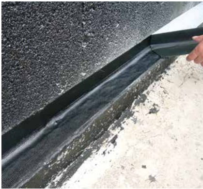
4 Abziehen der Schutzfolie vom SoproThene® Klebeband (Verschweißungsband).
