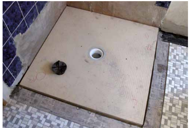
4 Eingesetztes Duschelement, bereit für die Abdichtungsarbeiten.
