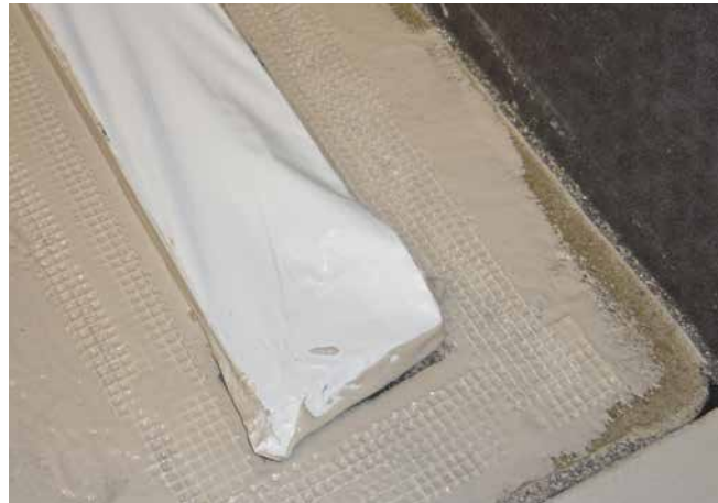
4 Einbetten von Sopro Armierung in die Sopro DichtSchlämme Flex 1-K im Bereich von Flanschen als Übergangsverstärkung.
