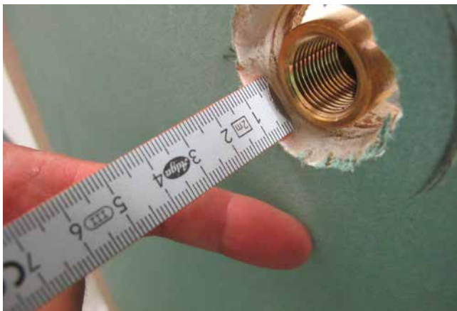
Um das abzudichtete Rohr müssen etwa 5–7 mm Platz geschaffen werden.
