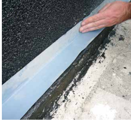
2 Aufkleben von SoproThene® Klebeband (Verschweißungsband) auf Innen- und Außenecken.
