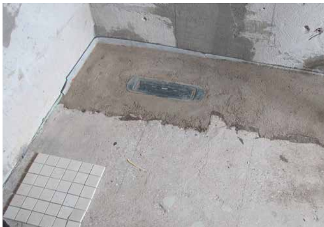
Duschfläche hergestellt aus Zementmörtel (Sopro Rapidur® M5).
