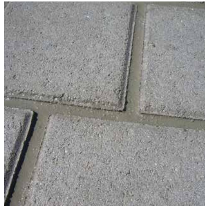
Optimal freigelegte Fase der Betonpflastersteine.
