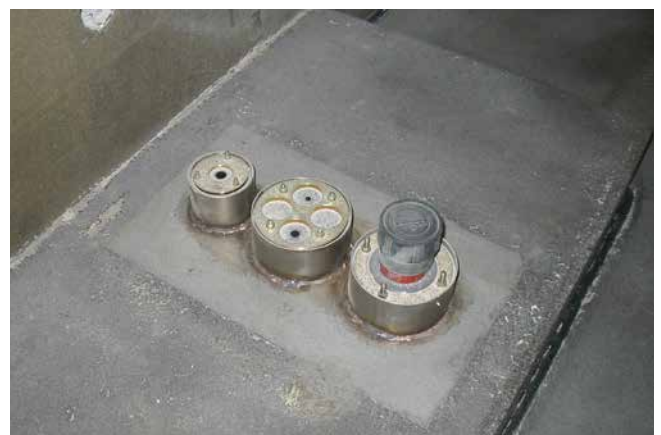
Durchdringungsplatte mit Gummidichtungsringseiben.
