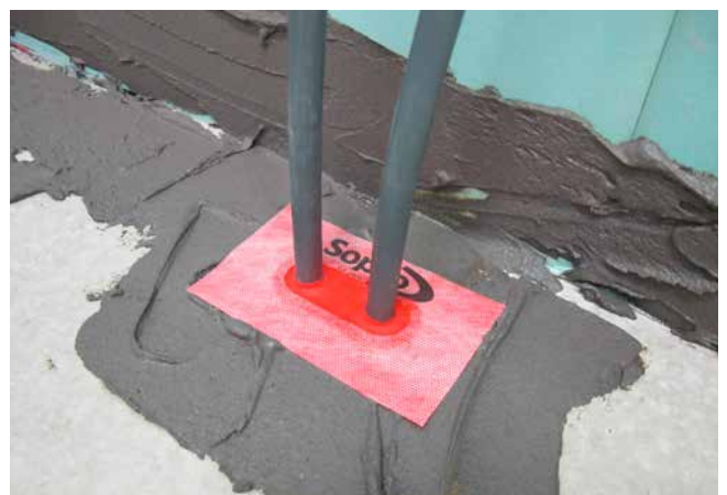
Leitungsführungen von Heizkörpern, z.B. aus dem Boden kommend, lassen sich ebenfalls sicher mittels der Sopro AEB 131 Manschette in die Bodenabdichtung einbinden.
