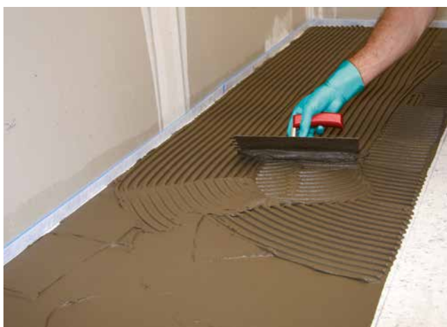
15 Auftragen des Fliesenklebers z. B. Sopro VarioFlex® XL auf der Sopro FliesenDämmplatte zur Verlegung des keramischen Belags.
