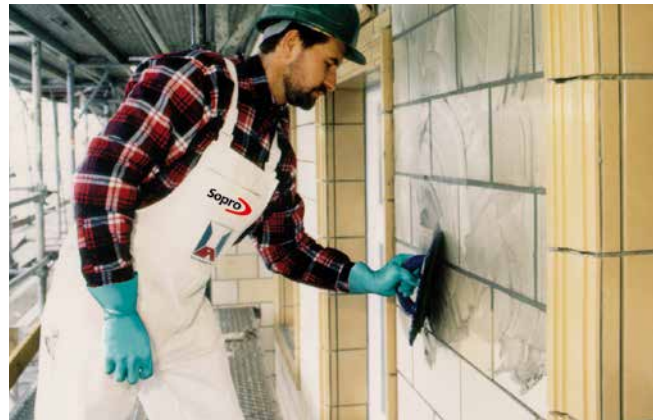
Einschlämmen des hydraulisch abbindenden, flexiblen Fugenmörtels.
