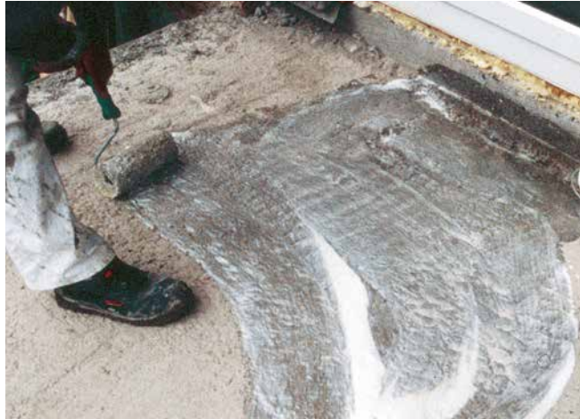
Aufbringen der Sopro Haftemulsion für die anschließende „frisch-in-frisch“-Verarbeitung mit dem Sopro Fließspachtel hochfest HF-S.
