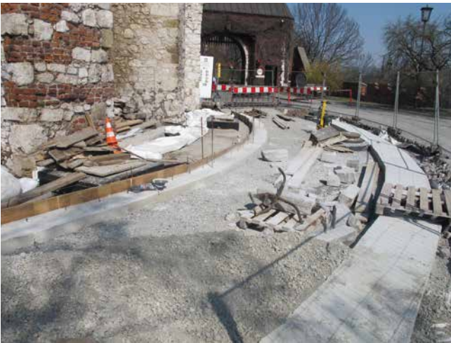
Betoniertes Rinnenfundament an einer Straße.
