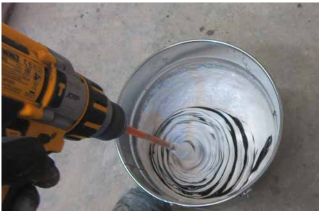
9 Die Sopro PU-FlächenDicht Kontrastfarbe wird in das Sopro PU-FlächenDicht eingemischt – eine graue Farbgebung entsteht.
