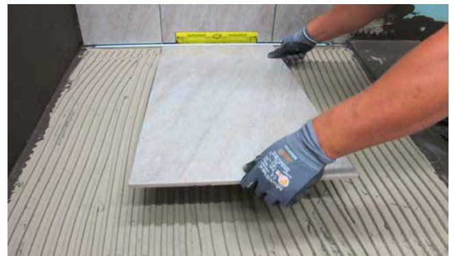
Verlegung der Fliese auf der Verbundabdichtung mit einem systemkonformen Dünnbettmörtel.
