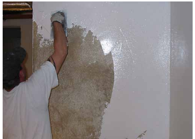
4 Applikation von Sopro PU-FlächenDicht an der Wand in zwei Arbeitsgängen – Gesamtmindestschichtdicke 1 mm.
