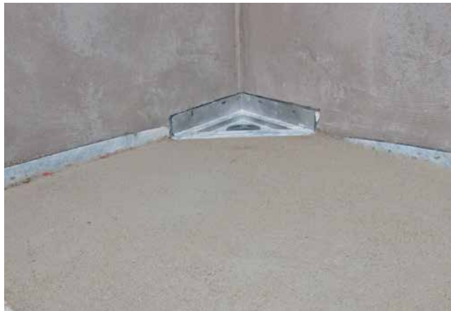
4 Duschfläche hergestellt mit Sopro Rapidur® M1/Sopro Rapidur® M5.
