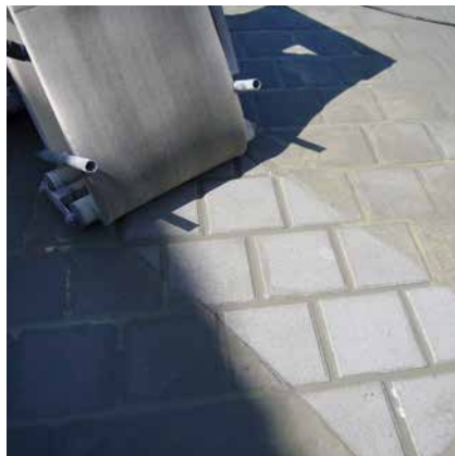
Einfaches Reinigen der Fläche mittels Schwamm-bandmaschine.
