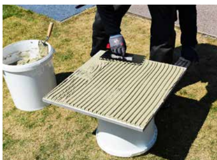
Kleber (z. B. Sopro's No.1 Flexkleber) wird auf der Plattenrückseite aufgetragen.
