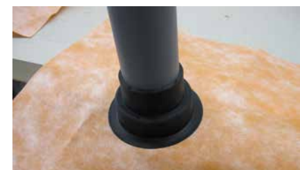
Manschette mit Gummimuffe zur Durchführung von DN 50-DN70 Abflussrohren (System Dallmer).
