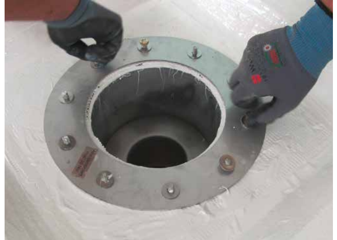
Abgedichtete Mulde. Der Pressflanschring wird aufgeschraubt. Die angefasten Estrichflächen sind gut zu erkennen.
