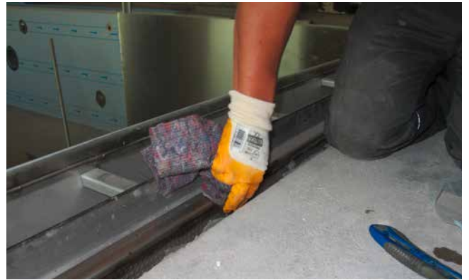
2 Reinigung des Stahlflansches, Öl- und Fettfilme sind zu entfernen.
