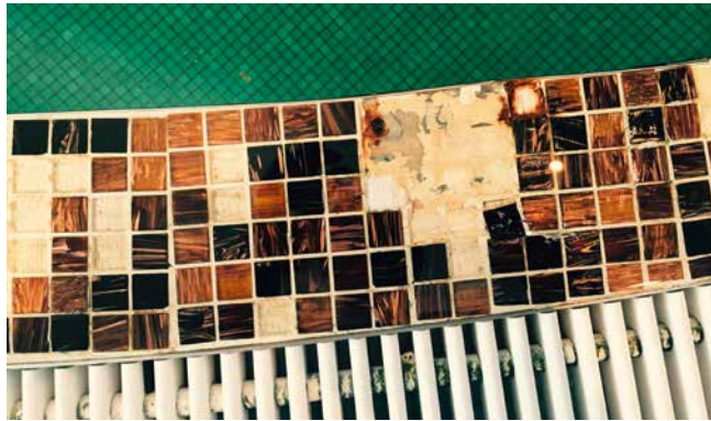
Abgelöste Glasmosaiksteine am Beckenkopf.
