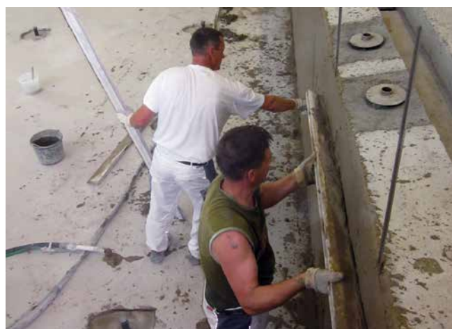
Die Wände sind mittels Sopro SchwimmBadPutz auf das notwendige Verlegemaß vorzubereiten. Der Beton wird im Vorfeld mit Sopro's No. 1 S1 Flexkleber abgezahnt.
