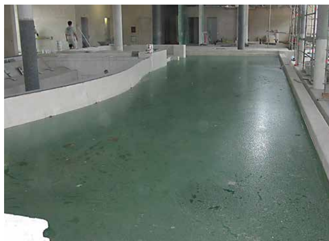
Dichtigkeitsprüfung (14 Tage) mit gechlortem Wasser.
