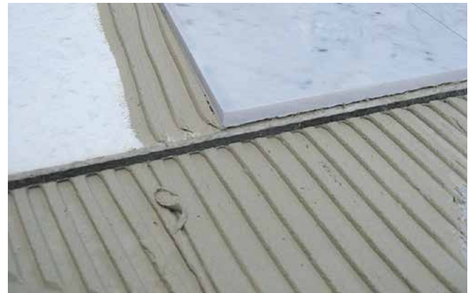
Verlegung von Sopro TrittschallDämm-Platte auf einem Treppenpodest mit anschließender Natursteinverlegung.
