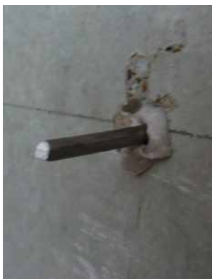
Eingesetzter Drahtanker für die mechanische Befestigung.
