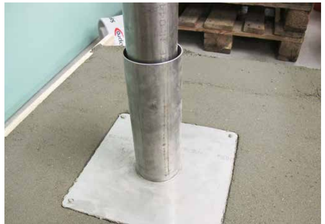
4 Beide Hüllrohre sind nun ineinander geschoben und frei beweglich.
