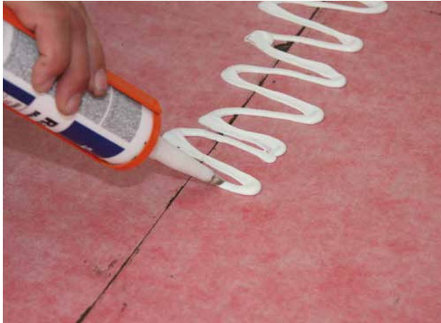
7 Auftragen des Sopro Racofix® Montageklebers zum Abdichten des Stoßbereiches.
