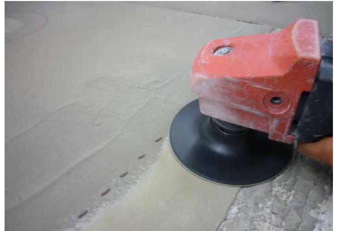
2 Die Abdichtung ist mit Sandpapier auf null auslaufend anzuschleifen.
