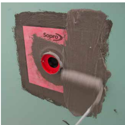
4 Eindichten der Sopro Manschette und dem Aufsatzring.
