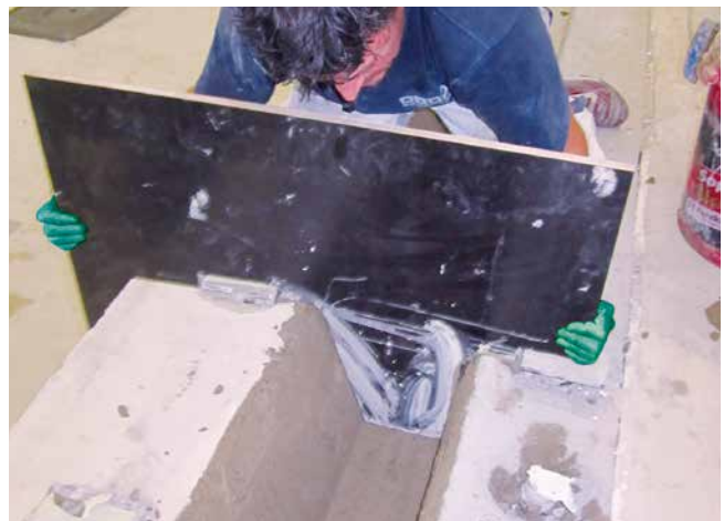
Am Beckenkopf lässt sich Sopro SchwimmBadPutz mit einer Schablone leicht modellieren.
