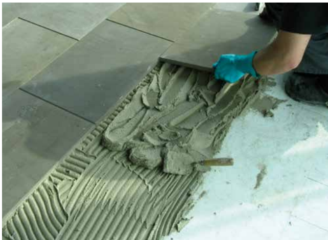
3 Verlegung des Natursteinbelages mit Sopro MittelBettmörtel flex.
