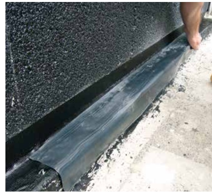
6 Nach dem Verkleben der SoproThene® fest andrücken.
