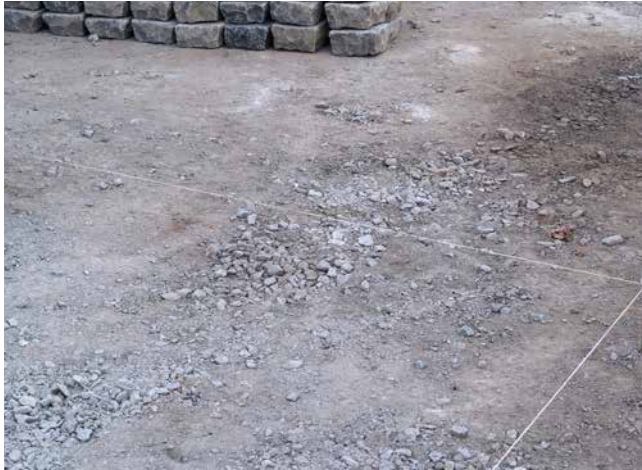
Kies-/Schotterschicht, verdichtet bei leichter bis mittlerer Beanspruchung.
