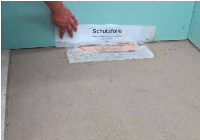
3 Eingebautes Bodenablaufelement. Dieses besitzt eine werkseitig angeschweißte Dichtmanschette zur Erleichterung der Abdichtungsarbeiten im Bereich der Wand.
