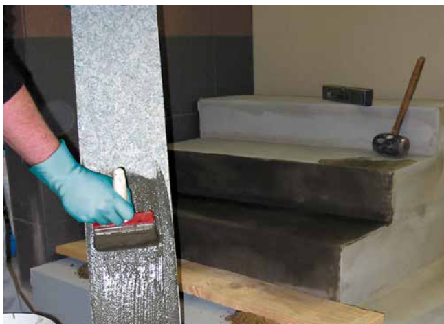
3 Vorbereiten des Belagmaterials durch rückseitiges Einstreichen mit Sopro HaftSchlämme.
