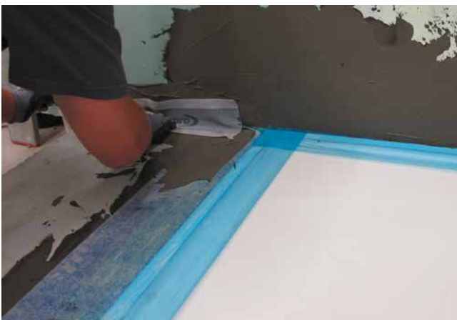
5 Das Eindichten erfolgt rundum mit Sopro TurboDichtSchlämme 2-K.
