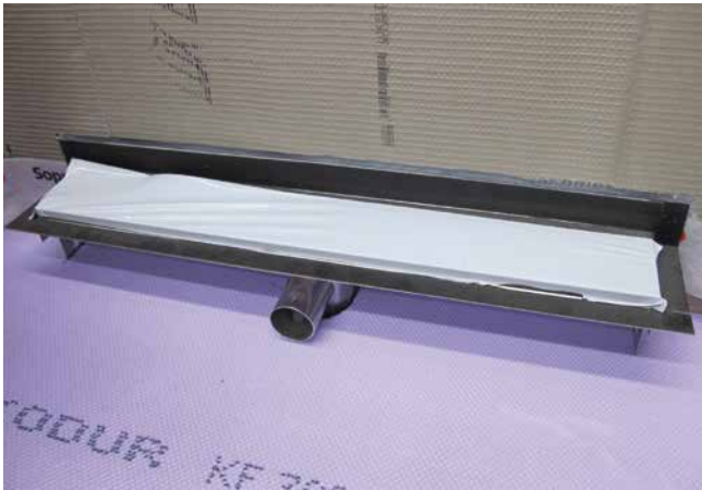
1 Rinnenelement mit Winkel, die Trockenbauwand muss gegebenenfalls ausgespart werden.
