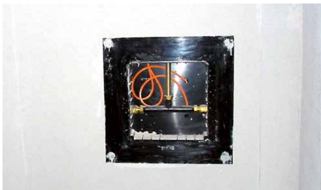
Sonderkonstruktion einer Unterputzarmatur mit Anflanschrahmen ...
