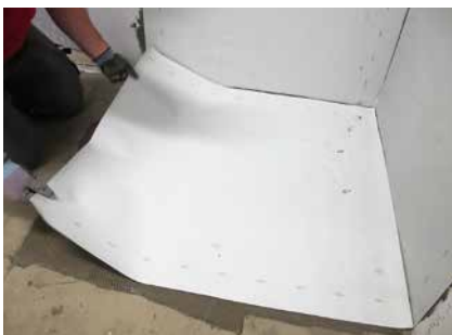
Verkleben der Bahn mit VarioFlex HF.
