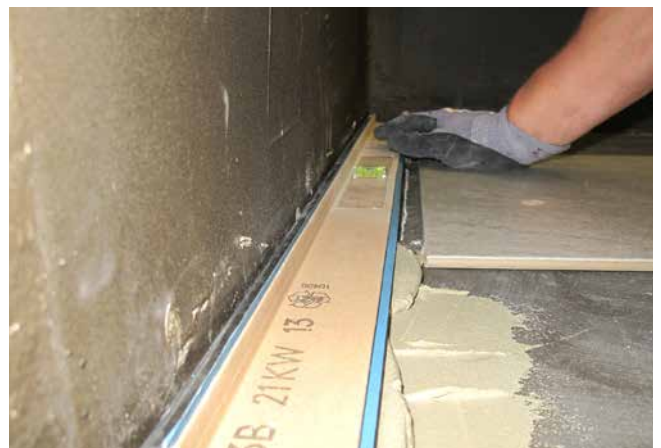
6 Einbau einer Wassersammelschiene, elastisch zur Wand gelagert, am Boden mit Fliesenkleber (Sopro's No. 1 S1 Flexkleber) verklebt.
