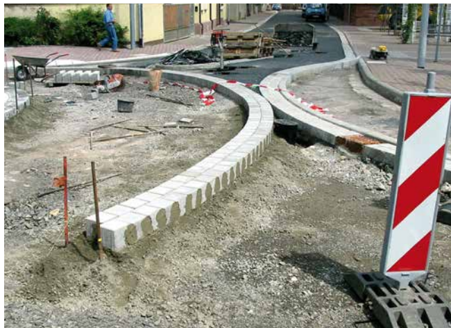
Betonpflastersteine als Rinnenbauwerk versetzt auf einem Betonfundament.
