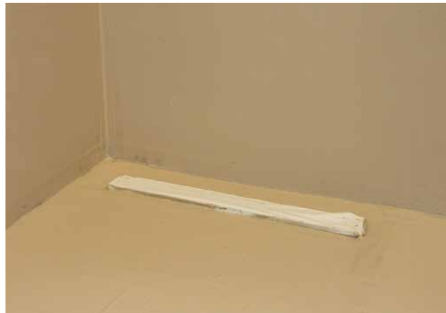
6 Abgedichtete Duschecke nach zwei Arbeitsgängen mit einer Mindestabdichtungsschichtdicke von 2 mm. Nach der Aushärtung kann unmittelbar mit einem zugelassenen Dünnbettmörtel (Sopro's No. 1 S1 Flexkleber) mit der Fliesenverlegung begonnen werden.
