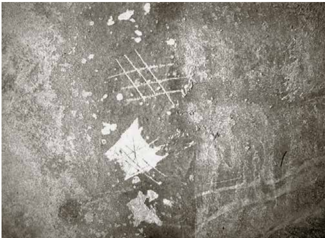
Überprüfung der Oberfläche auf Tragfähigkeit mittels Gitterritzprüfung.
