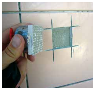
Haftzugsprüfung an der verlegten Keramik.
