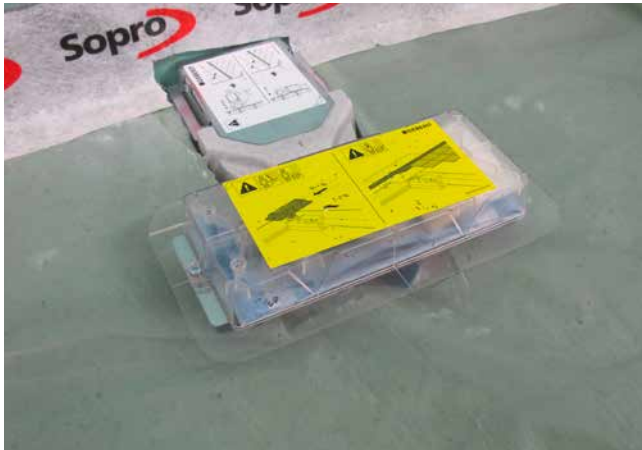
1 Bodenablauf in der Duschfläche positioniert.
