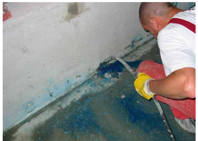
Rissverpressung an einem WU-Betonbecken.
