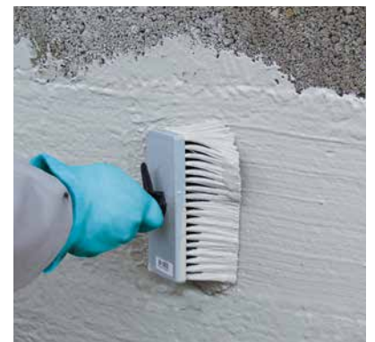
4 Um eine Beschädigung der Bitumenabdichtung aufgrund von rückseitig durchfeuchtetem Mauerwerk zu verhindern, wird im Sockel- und Sohlbereich eine Zwischenabdichtung mit Sopro ZR Turbo XXL oder Sopro TurboDichtSchlämme 2-K aufgebracht.
