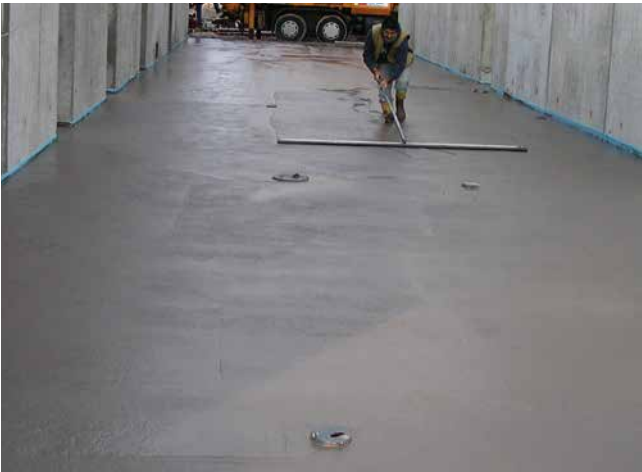
Frische Betonbodenplatte in einem Flughafenterminal.
