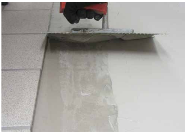
4 Überlappendes Andichten der Duschfläche an die Bestandsfläche.
