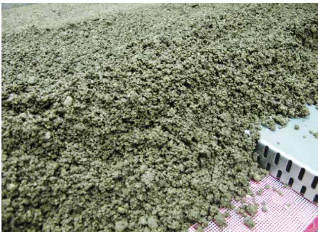
11 Der drainagefähige Verlegemörtel umschließt den Stichkanal.
