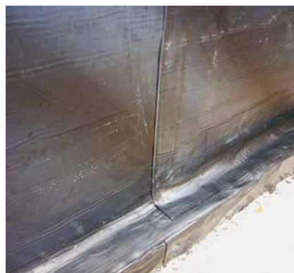
17 Abgedichtete Fläche mit Fußpunkt.
