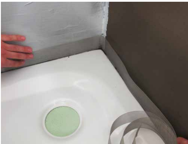
Das Einlegen der Schutzeinlage findet beim Fliesenlegen statt.
