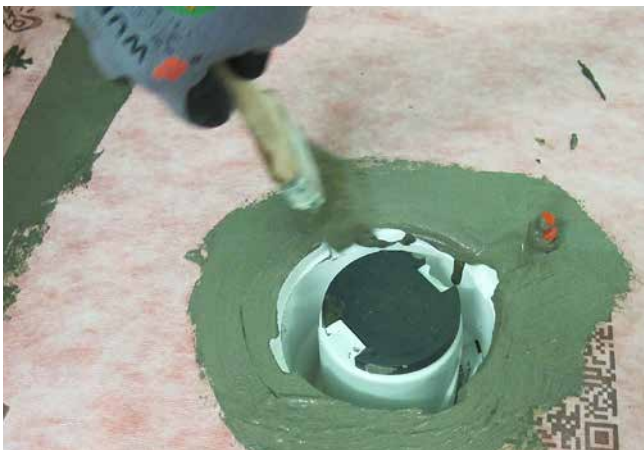
5 Die Durchdringung (Zwischenentwässerung) ist sorgfältig einzudichten.
