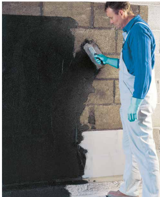
Auftrag der Dickbeschichtung (PMBC) auf der Kelleraußenwand.
