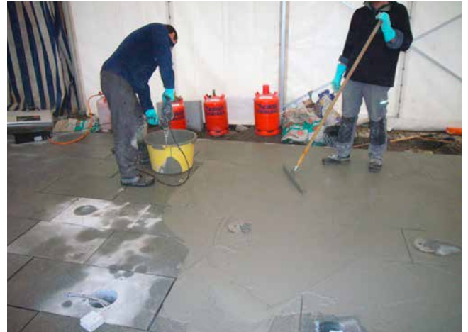
Sollen Außenflächen in der kalten Jahreszeit ausgeführt werden, sind diese durch Einhausung und ggf. Heizen beim Einbau zu schützen.
