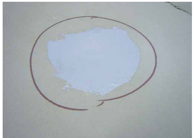
Messstelle überlappend repariert.
