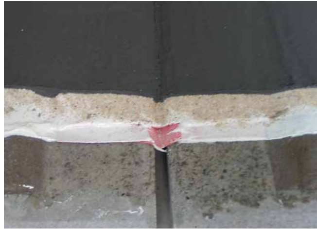
Bauwerksfuge mit zwei Dichtbandeinlagen, eingebettet und überarbeitet mit Sopro PU-FlächenDicht. Anschließend überzogen mit der eigentlichen Verbundabdichtung.
