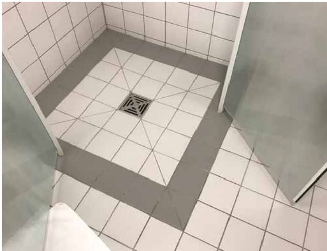
Duschfläche mit Formfliesenumrandung mit 1 cm Höhenunterschied.
