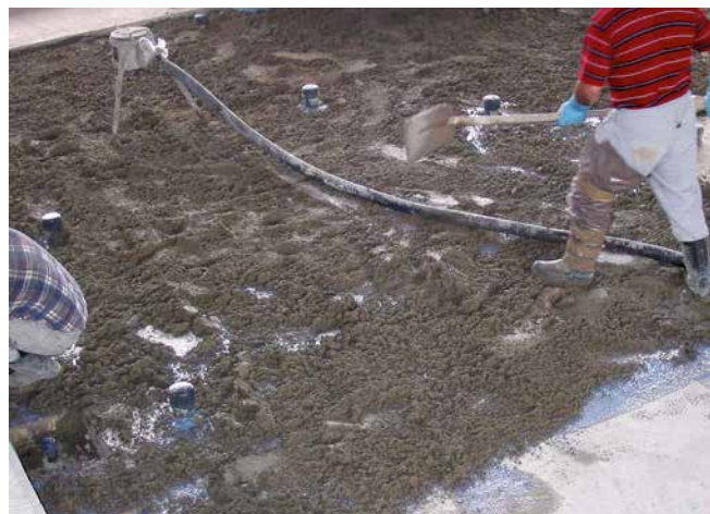
Zementestriche werden in erdfechter Konsistenz verarbeitet.
