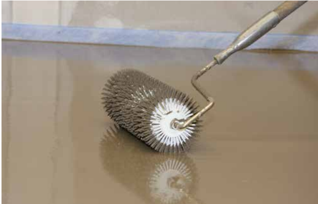
Verteilung und Entlüftung von Sopro VarioFließspachtel mit einer Stachelwalze auf Holzdielenuntergrund.
