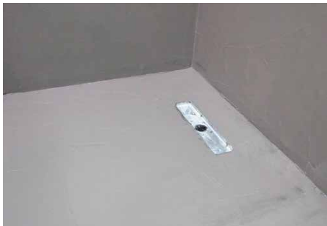
4 Mit Sopro DichtSchlämme Flex 1-K abgedichtete Duschcke, bereit für die folgende Fliesenverlegung.
