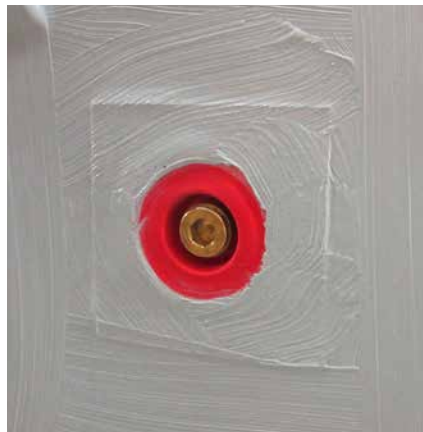
Eine abgedichtete Rohrdurchdringung, die dem Installateur genug Platz für seine Arbeit läßt.
