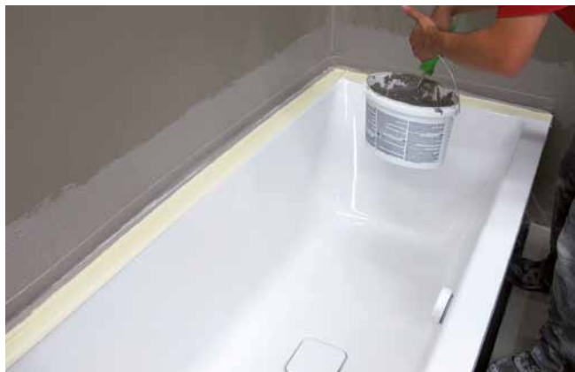
4 Eindichten des Wannenabdichtbandes (System MEPA – Pauli und Menden GmbH) mit Sopro FlächenDicht flexibel im Wandbereich.
