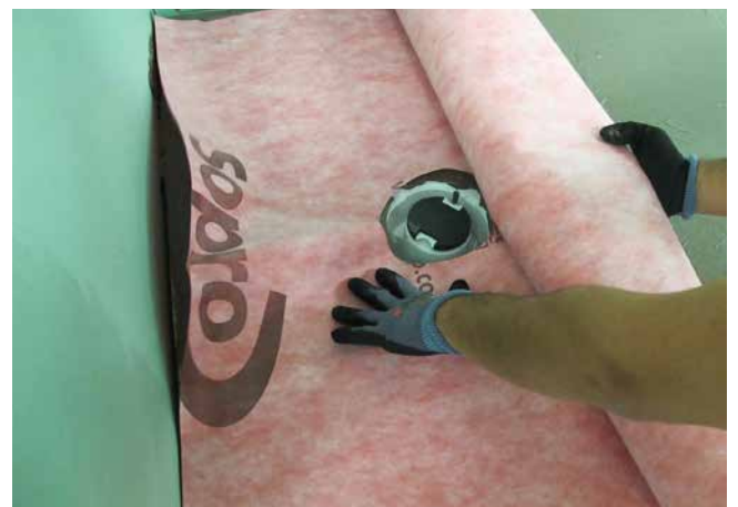
2 Verlegen der AEB®-Bahn in die frische Fixiermasse.
