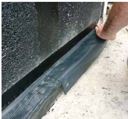
7 Die Teilstücke sind überlappend zu verkleben.
