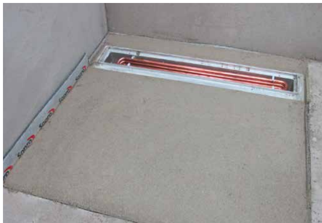
4 ACO Energiesparrinne mit Sopro Rapidur® M1/Sopro Rapidur® M5 schnell und einfach eingebaut.
