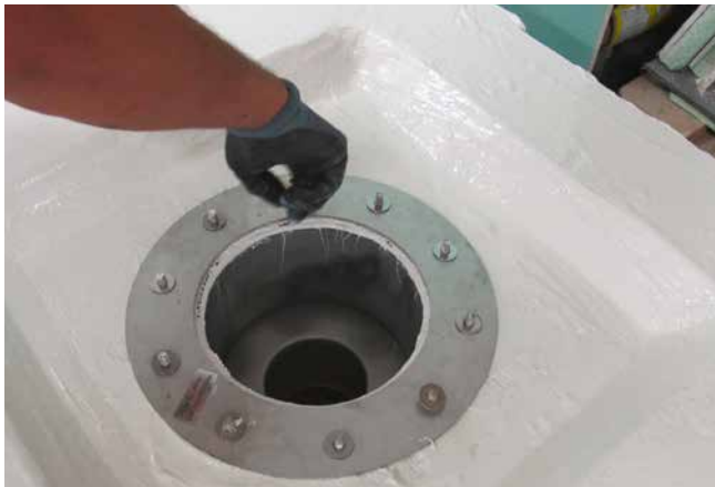
Eingedichteter Entwässerungstopf, bereit für die Aufnahme des Aufstockelements.
