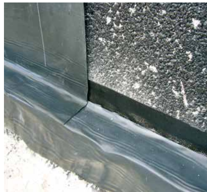
14 Stoßbereich ist durch SoproThene® Klebeband (Verschweißungsband) zusätzlich gesichert.
