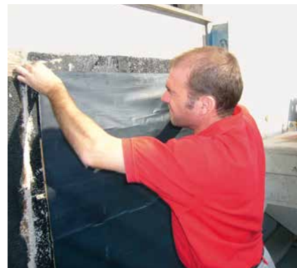
9 Ansetzen der SoproThene® an der Kellerwand.
