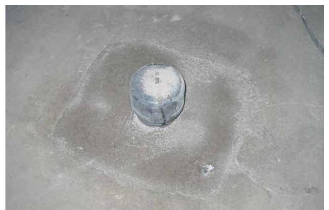
Bodendurchdringung, kapillardicht vergossen mit Sopro Epoxi-Grundierung-Quarzsandgemisch.
