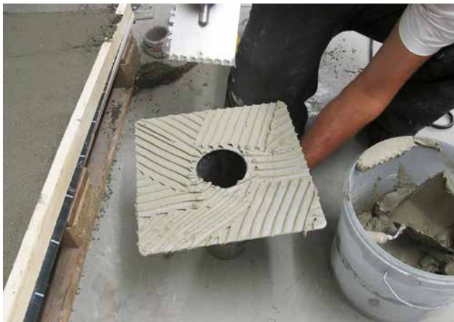
3 Der Flansch des zweiten Hüllrohrs wird mit Sopro's No.1 Flexkleber abgespachtelt, damit das Hüllrohr kraftschlüssig auf dem Estrich sitzt.
