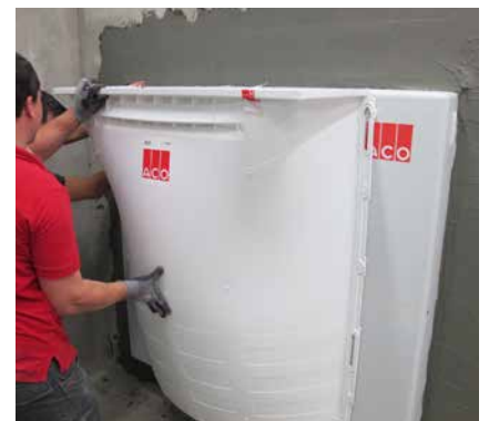
24 Nach den Abdichtungsarbeiten erfolgt die Installation des Lichtschachtes.
