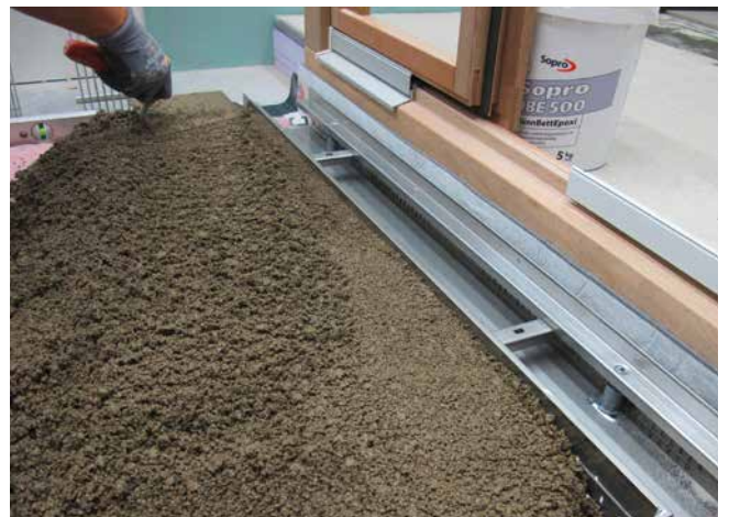
4 Der Sopro DrainageMörtel eXtra wird in einer Mindestschichtdicke von 50 mm auf der Sopro DrainageMatte aufgebracht. Anschließend vorverdichtet und abgezogen.
