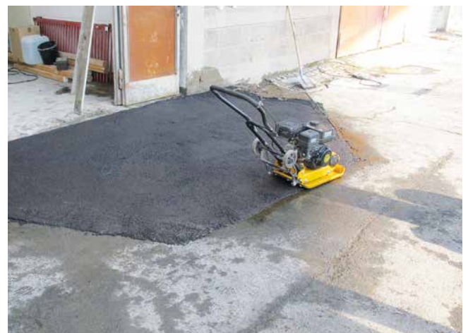
Die fertige Fläche kann unmittelbar nach dem Verdichten begangen werden.
