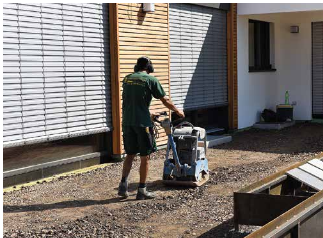
Verdichten der ungebundenen Trag- und Frostschutzschicht.
