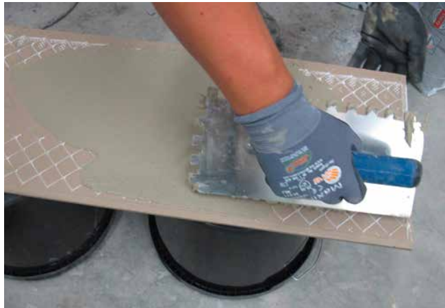
8 Die großformatigen Fliesen sind im Kombinierten Verfahren zu verlegen.
