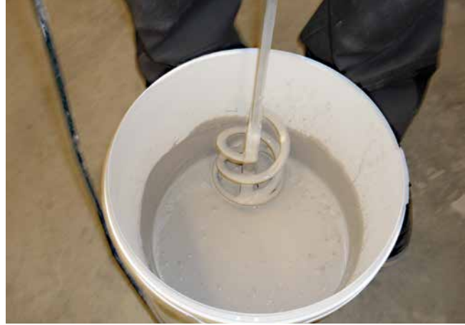
2 Anmischen der Sopro DichtSchlämme Flex 1-K mit Wasser zu einer leicht zu verarbeitenden Schlämme.
