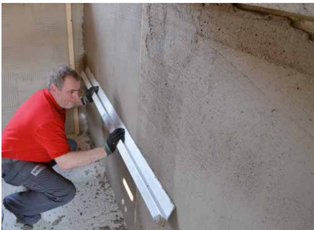
Mit der Alu-Latte lässt sich der Sopro SchwimmBadPutz leicht abziehen.
