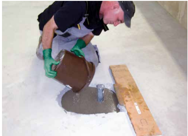
Mit einem Epoxidharz-Quarzsand-Gemisch 1 : 1 : 1 werden alle Durchdringungen kapillardicht vergossen.
