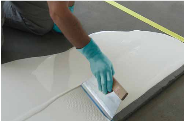
7 Abdichten einer Bodenfläche mit Sopro PU-FlächenDicht Boden.
