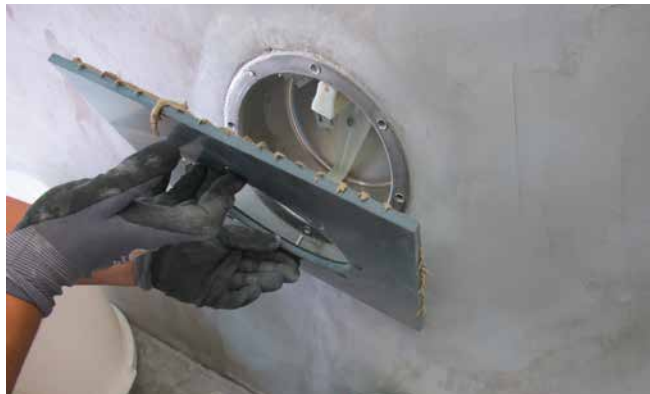
4 Ansetzen und Verschrauben der Flanschplatte.
