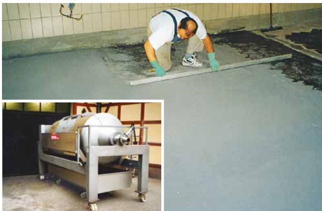
Hochfeste Epoximörtel-Spachtelung zur Aufnahme hoher beweglicher Punktlasten.
