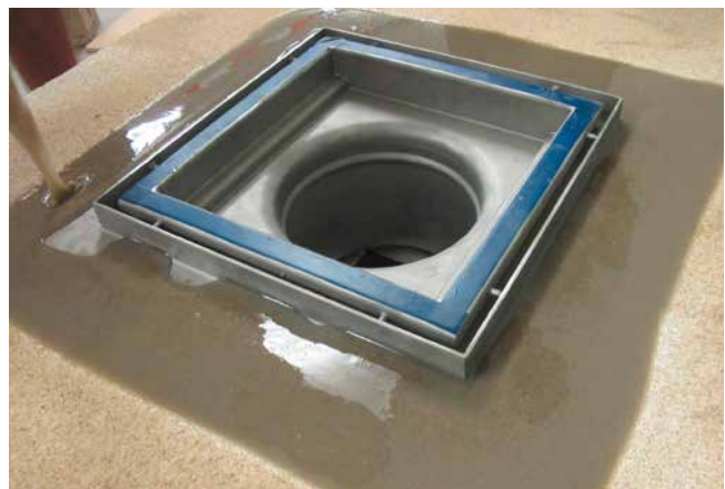
Der Bodenablauf ist nach dem Aushärten des Reaktionsharzes kraftschlüssig mit der Konstruktion verbunden und kann höchste Verkehrslasten aufnehmen.
