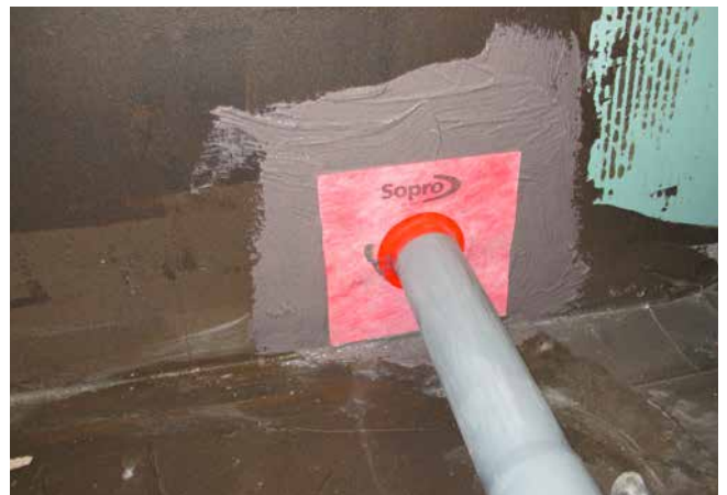
Die Sopro AEB 130 Wandmanschette wird in die flüssig zu verarbeitende Verbundabdichtungsmasse eingearbeitet. Die Gummidichtlippe legt sich fest an die Außenwandung des Rohres an.
