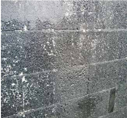
1 Wandfläche vorbereitet mit SoproThene® Voranstrich.
