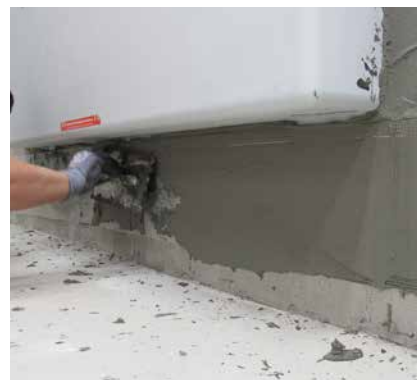
23 Die Eindichtung des Dämmelementes erfolgt umlaufend.
