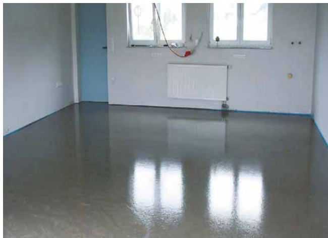
Planebene, nach Erhärtung gegen Abrieb unempfindliche Bodenfläche.
