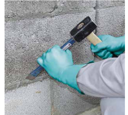
2 Vorstehende Mörtelreste sind abzuschlagen, Grate zu egalisieren. Zementleimschichten können mit einer Flex entfernt werden.
