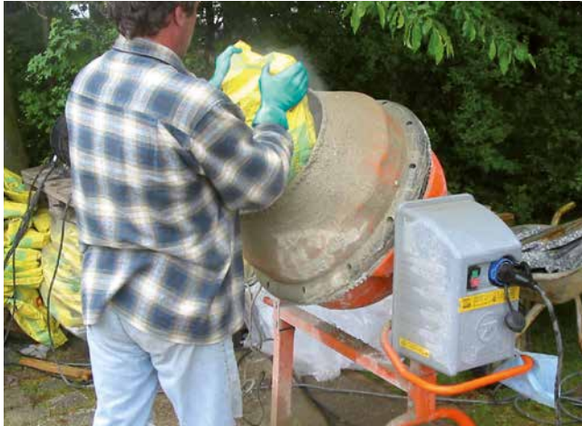
1 Anmischen von Sopro DrainageMörtel eXtra mit Freifallmischer.
