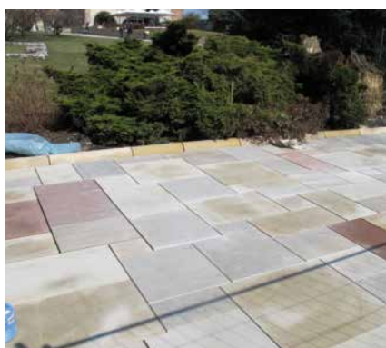
Großformatige Natursteinplatten in gebundener Bauweise verlegt.
