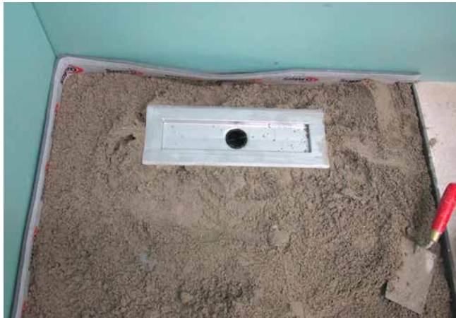
1 Einbau der Rinne mit Sopro Rapidur® M1/Sopro Rapidur® M5.
