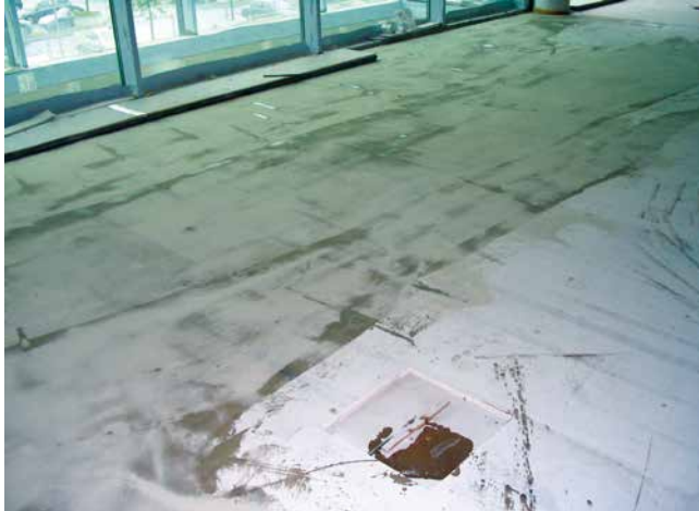
1 Grundieren des saugenden Untergrundes.
