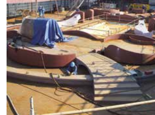
Rohbau auf Deck.
