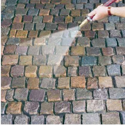
Vornässen des gereinigten, zu verfugenden Belages.
