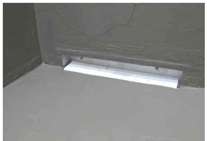
6 Abgedichtete Duschfläche, bereit für die folgende Fliesenverlegung.
