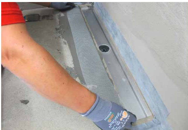
5 Eindichten der Rinne mittels Dichtbändern/Armierungsgewebe und Sopro TurboDichtSchlämme 2-K.
