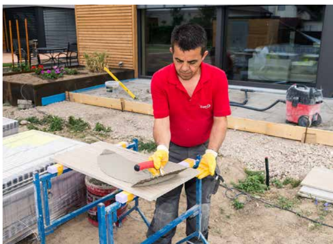
Aufkämmen von Sopro megaFlex S2 Flexkleber auf der Rückseite der Platte für die Verlegung im Buttering-Verfahren.
