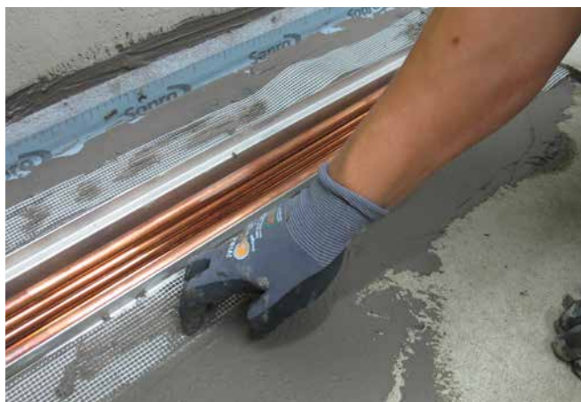
6 Eindichten der Rinne und Abdichten der gesamten Fläche mittels Dichtbändern, Gewebeeinlagen etc. in der Kombination mit z.B. Sopro DichtSchlämme Flex 2-K.
