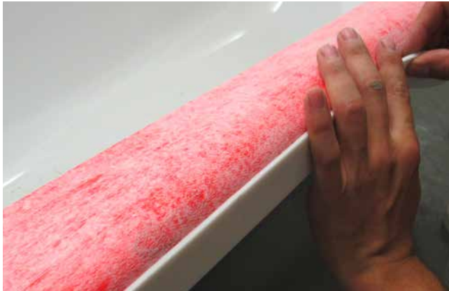
5 Sind die Wannendichtbandformteile fixiert, wird abschließend der Sopro WannendichtSchallschutz aufgeklebt.
