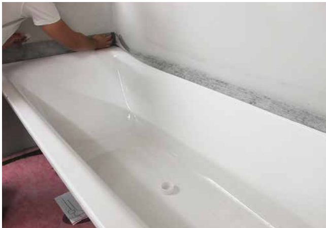
1 Wanne mit angeklebtem Dichtband (System Franz Kaldewei GmbH & Co. KG) bereits an der Wand angestellt.
