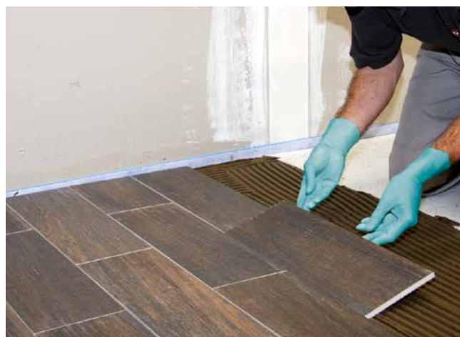
16 Verlegen der Keramik in das vorbereitete Mörtelbett.
