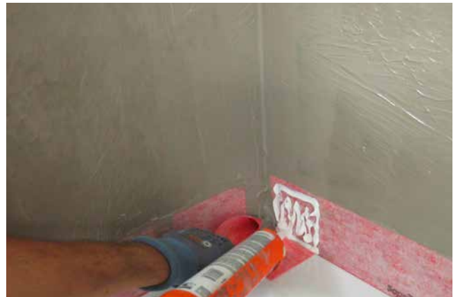
8 Wasserdichtes Verkleben der Formteile im Stoß-/Überlappungsbereich mit z. B. Sopro Racofix® Montagekleber.
