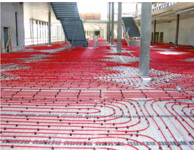
Fußbodenheizung (nach Bauart A ausgelegt) bereit für die Estrichverlegung.
