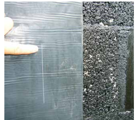
15 Arbeitserleichterung durch Überlappungsmarkierungen für die nächste Bahn.
