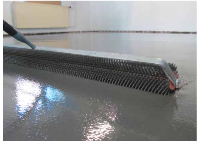
Zum Verteilen und Verdichten kann ambiente® floor mit einer Stachelwalze bearbeitet werden.
