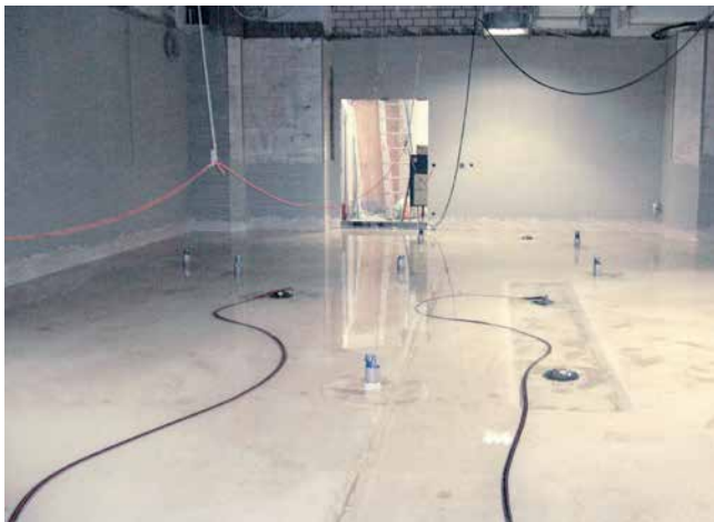
Prüfung der Bodenabdichtung auf Dichtigkeit durch Flutung.
