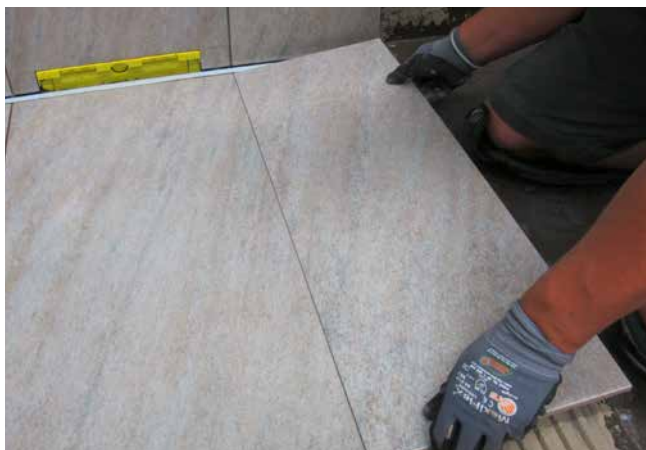
9 Die Fliesen werden an der Wassersammelschiene angearbeitet.
