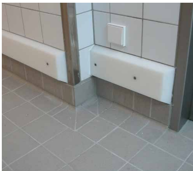
Ausgeführtes Sockeldetail mit Rammschutz.
