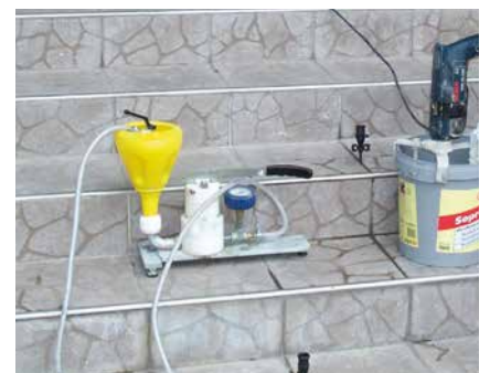
Verpressung eines hohlliegenden Belags auf einer Treppe.
