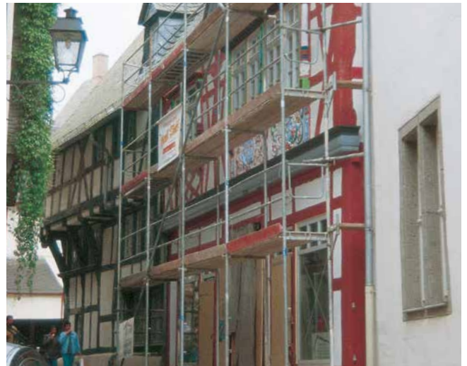
Sanierung im Altbaubereich.
