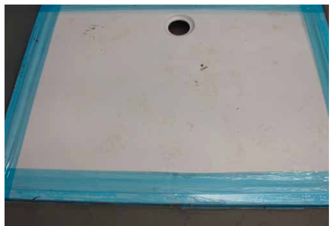
6 Die Duschfläche ist sauber und sicher in die Flächenverbundabdichtung eingebaut.
