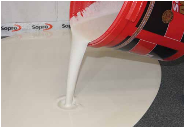
Ausgießen des Sopro Anhydritfließspachtels.
