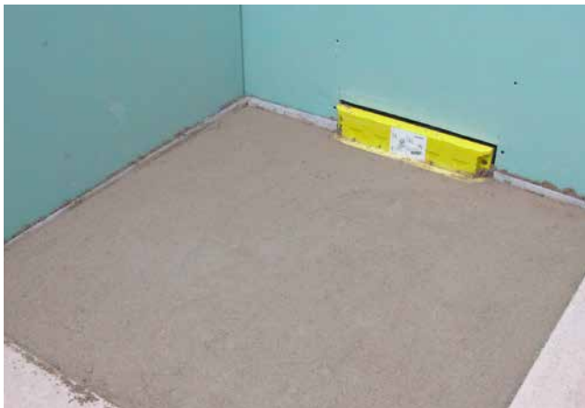
3 Fertig hergestellte Duschfläche mit Sopro Rapidur® M1/Sopro Rapidur® M5 – nach kurzer Abbindezeit entsprechend nutzbar.
