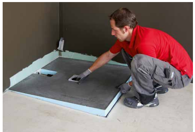
4 Einsetzen des Duschelementes in die Duschecke bzw. Aussparung des Estrichs.
