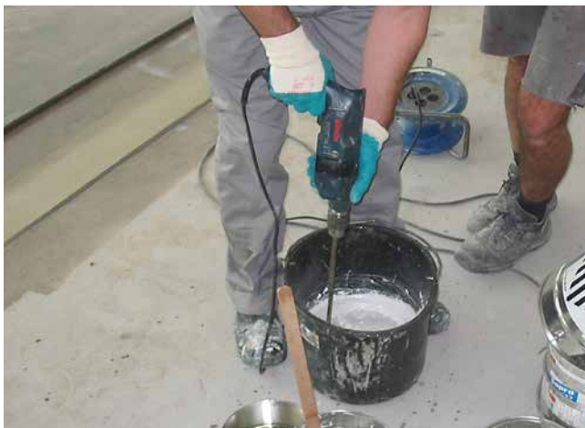
5 Sorgfältiges Anmischen von Sopro PU-FlächenDicht mit Umtopfen und zweitem Mischvorgang.
