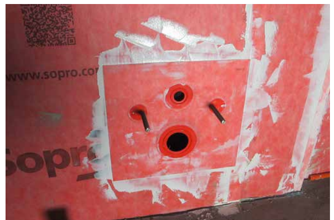
Die Sopro AEB® WC-Manschette ist fest verklebt, die Montage der Toilette kann nach der Fliesenverlegung erfolgen.
