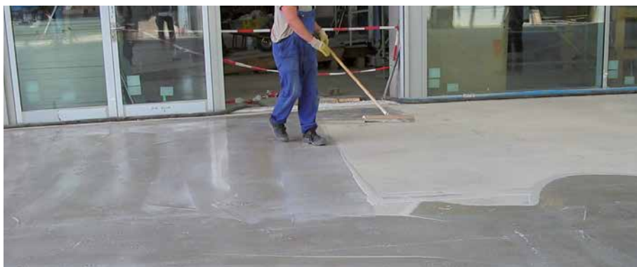
Leichtes Auftragen von Sopro MultiGrund zum Schutz des calciumsulfatgebundenen Estrichs gegen Durchfeuchtung.
