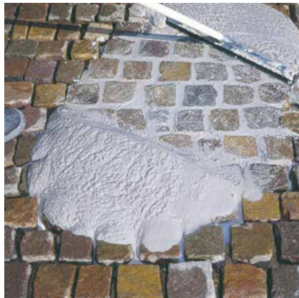
Fugenfüllendes Einbringen des Mörtels.
