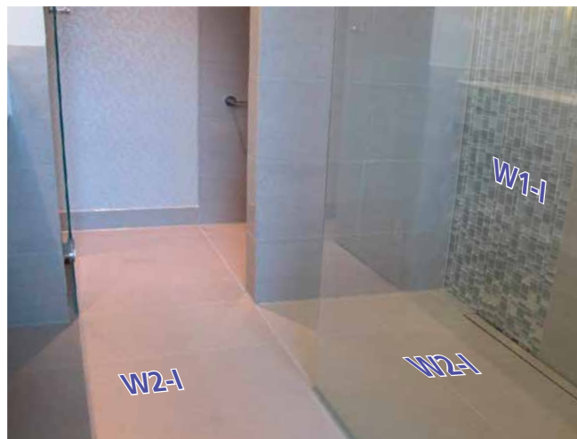
Badezimmer mit Glasscheibenspritzschutz.
