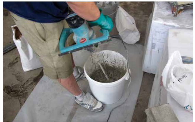
Die Rüttelschlämme ist mit Wasser maschinell anzumischen.
