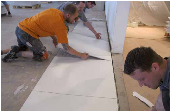
Wenige Stunden nach Einbau des zementären, schnell erhärtenden Fließestrichs Sopro Rapidur® FE ist die Großformatverlegung im Dünnbett ohne weiteres Ausgleichen möglich.
