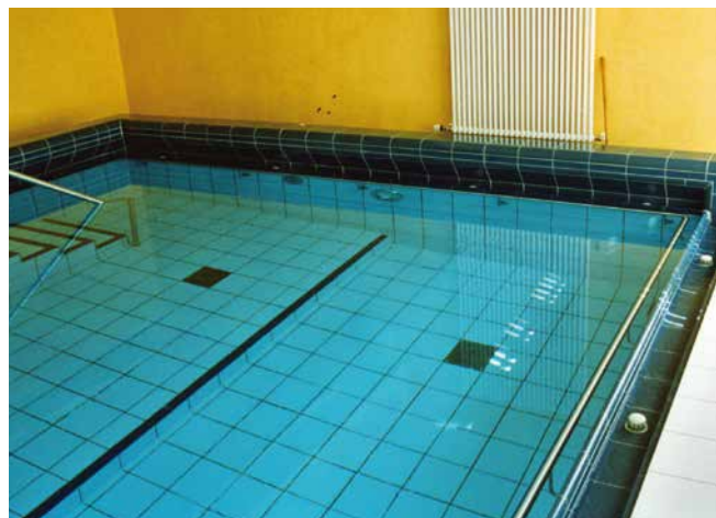
Therapiebecken mit tieflichem Wasserspiegel.
