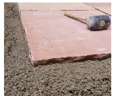
Verlegte Natursteinplatte im entsprechend dick dimensionierten Bettungsmörtel.
