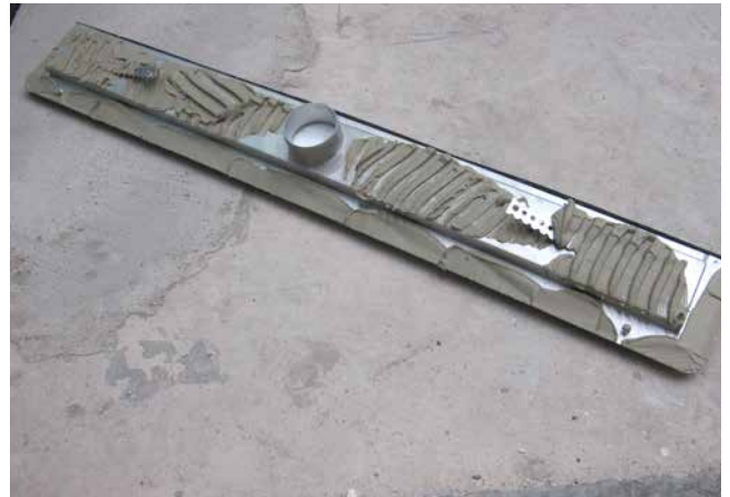
2 Die Rinne ist rückseitig mit Fliesenkleber (Sopro's No.1 S1 Flexkleber) für einen guten Haftverbund zum Estrich abzuspachteln.
