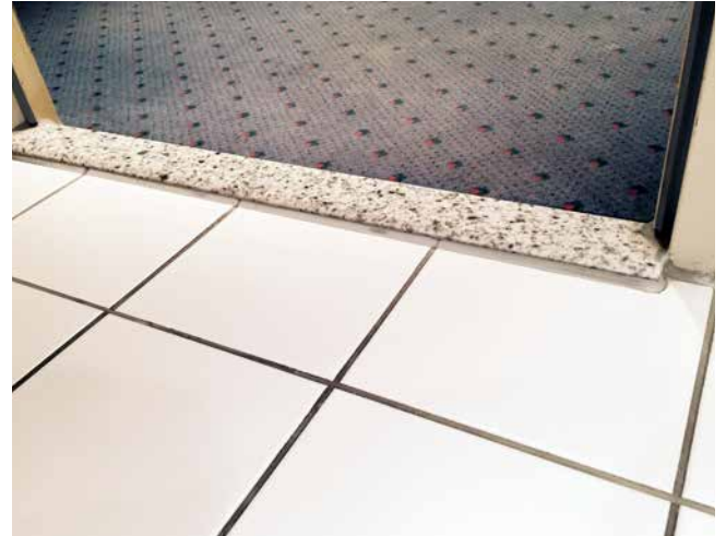
Belag mit Natursteinschwelle.
