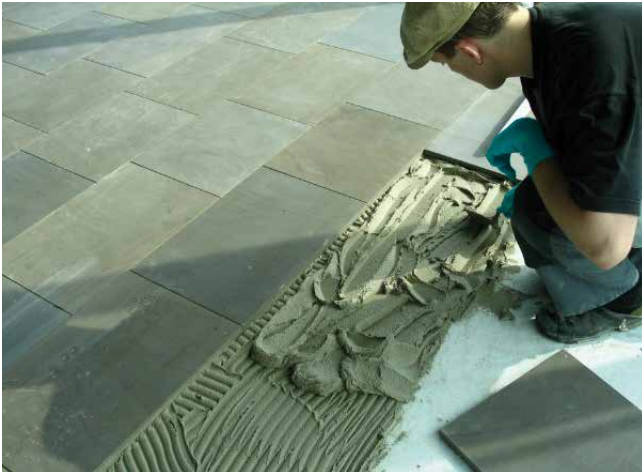
Verlegung des Natursteins im Mittelbettverfahren mit dem Sopro Mittel-DickbettMörtel.
