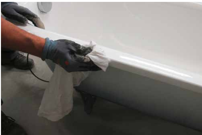
1 Reinigung des Wannensandes, entfernen aller haftungsmindernder Stoffe.
