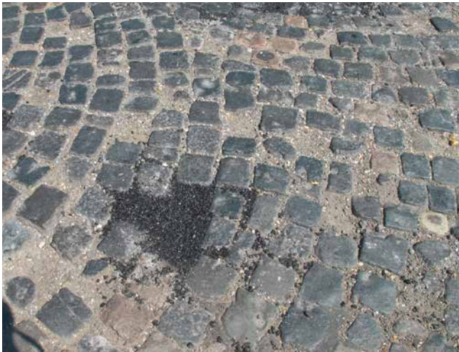
Kaltasphalt zum Auffüllen von schadhafte Pflasterflächen.
