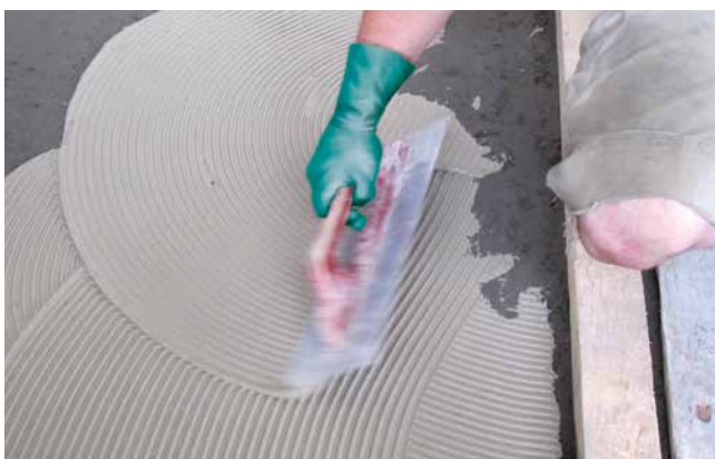
Verteilen der Rüttelschlämme auf dem frischen Bettungsmörtel.
