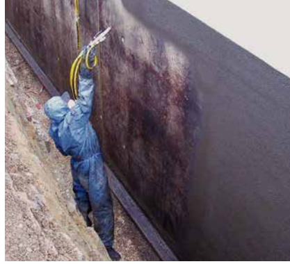
17 Sprühen der Abdichtung auf der Baustelle.
