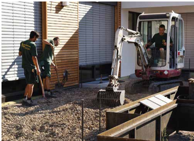
Einbau der ungebundenen Frostschutzschicht.
