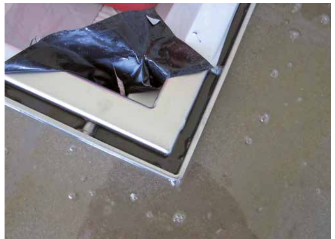
Der umlaufende Edelstahlrahmen ist gut zu erkennen. Die Bolzen werden später durchtrennt, der Rinnenkörper kann sich so frei bewegen.
