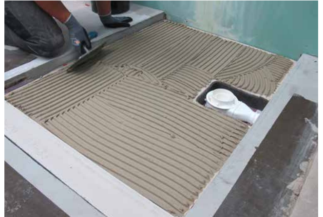
2 Aufziehen von Fliesenkleber (Sopro's No.1 S1 Flexkleber) zur Verklebung der folgenden Duschfläche.
