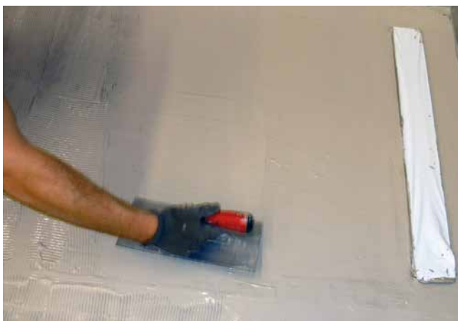
5 Abdichten der Wand- und Bodenflächen mit Sopro DichtSchlämme Flex 1-K.
