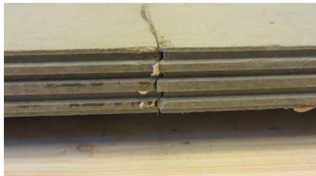
Hohlbodenplatten mit seitlicher Verzahnung zur Herstellung einer monolithischen Verbindung zur Nachbarplatte.
