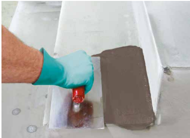
1 Gefällespachtelung mit Sopro RAM 3® Renovier- & Ausgleichsmörtel.
