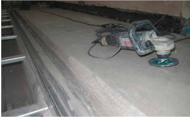
1 Vorbereiten des Estrichs im Anschluss an das Stahlbecken für die Abdichtungsarbeiten.
