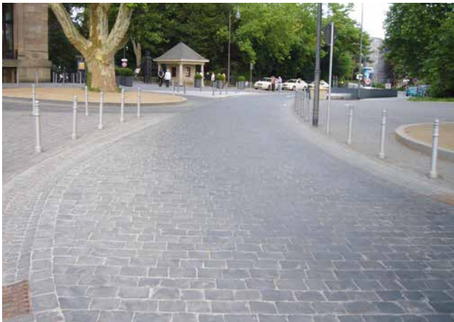
Sopro PflasterFugMörtel hochfest – abgestimmt auf die Festigkeiten von Natursteinpflaster.
