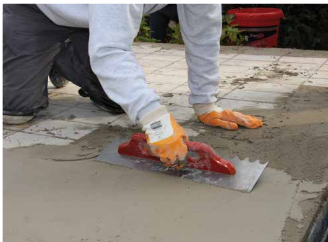
2 Ausgleichen von Fehlstellen mit Sopro RAM 3® als vorbereitende Arbeit für die Abdichtarbeiten.
