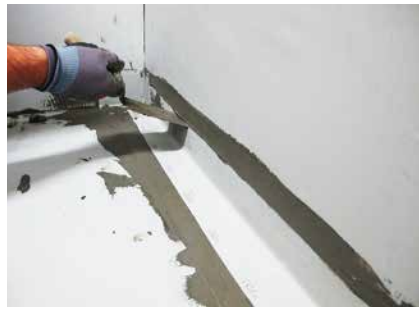
Dichtbänder und Formteile lassen sich mit dem Sopro Fixier- & DichtKleber verleimen.
