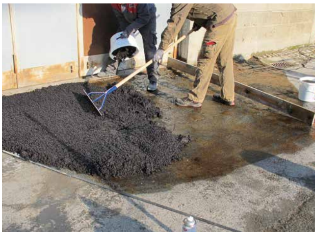
... und etwas überhöht auf der Fläche verteilt.
