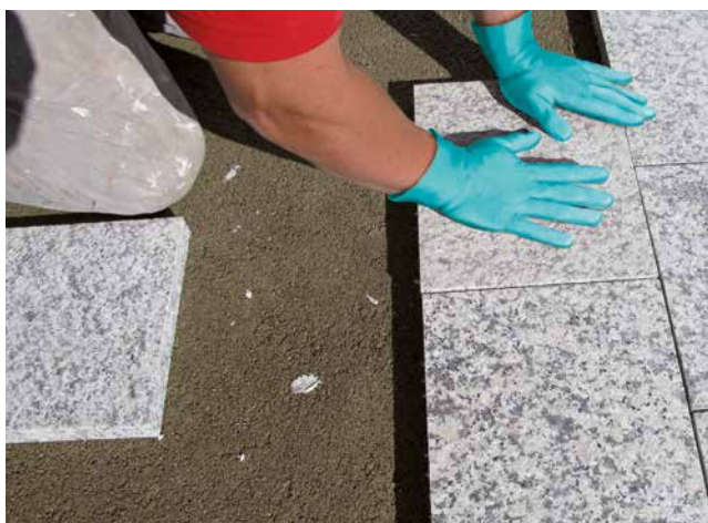
6 Nach dem rückseitigen Auftragen des Dünnbettmörtels wird die Natursteinplatte auf der Drainagemörtel-Lastverteilungsschicht verklebt.
