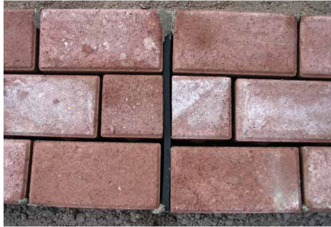
Eingebaute Gummischeibe bei Betonpflasterbelägen als Bewegungsfuge.
