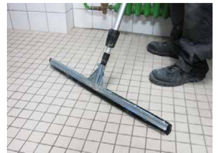
Entfernung des Wassers mittels Gummischieber.
