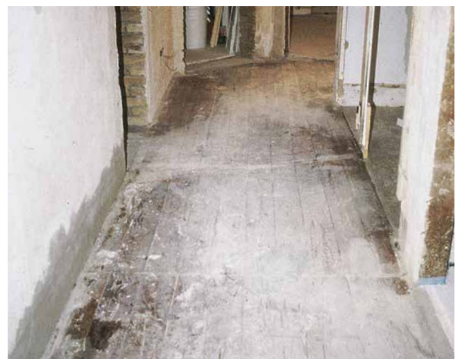
Holzdielen als Untergrund für eine Fliesenverlegung.
