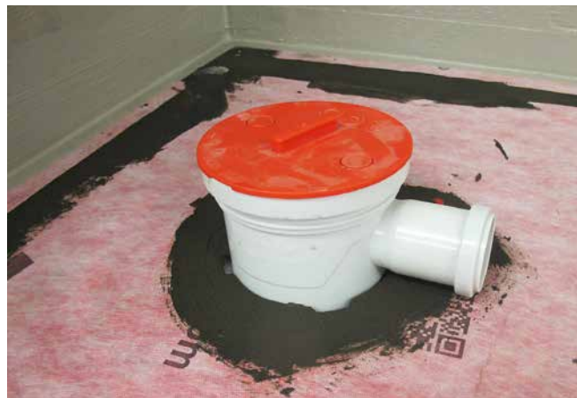
6 Montage des Zwischenentwässerungsaufsatzes.
