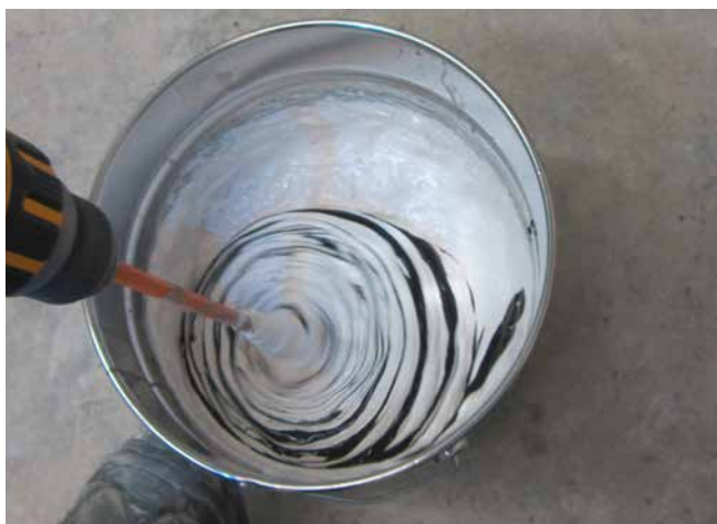
7 Die Sopro PU-FlächenDicht Kontrastfarbe wird in das Sopro PU-FlächenDicht eingemischt – eine graue Farbgebung entsteht.
