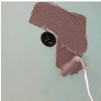
1 Auftragen des Abdichtstoffs.
