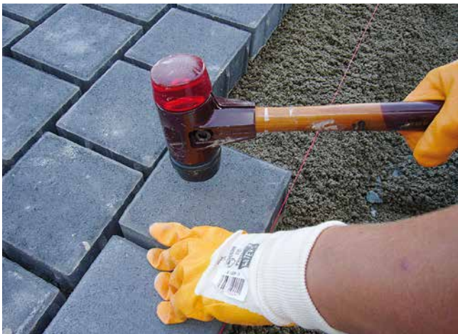
Ausrichten des Steines nach der Schnur und anschließendes hammerfestes Versetzen.
