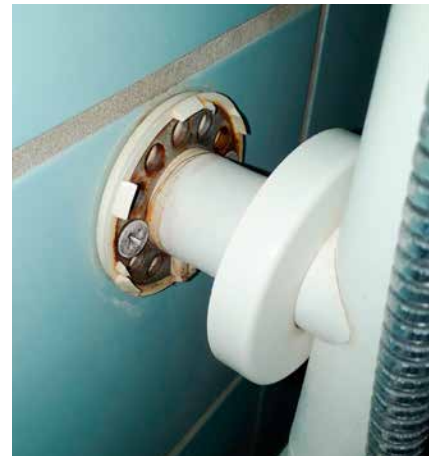
Halterung im Schwimmbad
