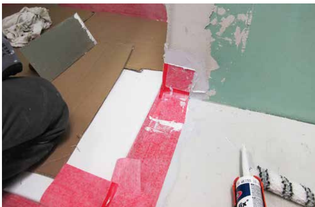
3 Anschluss einer Duschwanne an eine Wandecke innerhalb einer Nische mit der Sopro Wannendicht Multiecke.
