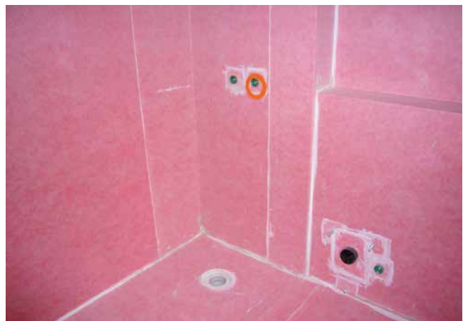
Fertig abgedichtetes Badezimmer - gut sind die Überlappungsbereiche der AEB-Bahn zu sehen, welche mit Sopro Racofix® RMK 818 Montagekleber wasserdicht verklebt sind.
