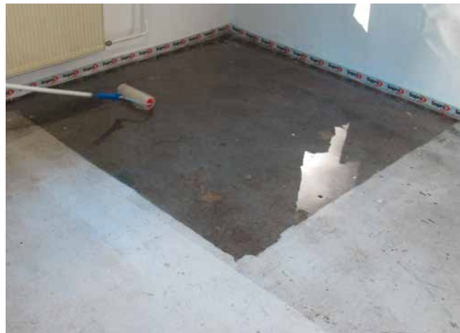
Grundieren der Fläche mit Sopro Epoxi-Grundierung.
