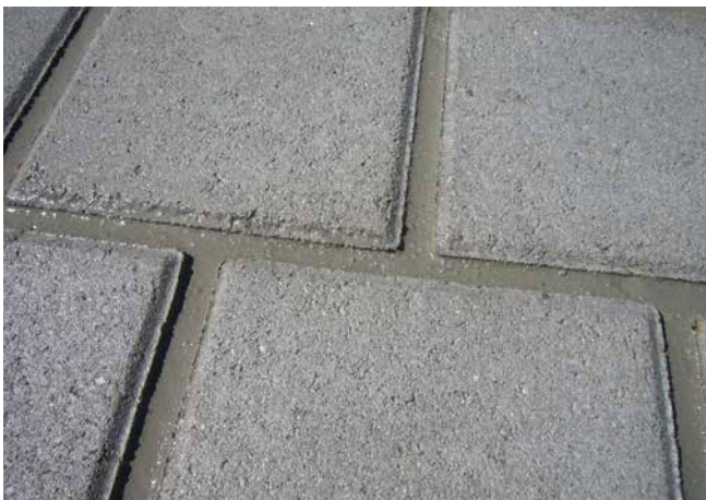
Sopro BetonSteinFuge ist von ihren Eigenschaften und Festigkeiten auf die Besonderheiten der Betonpflastersteine abgestimmt.
