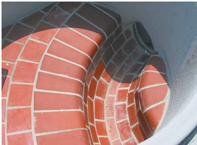
Fäkalien- und sulfatbeständige Verfugung im Kanalisations- und Tierhaltungsbereich.
