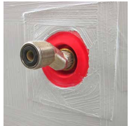
Das Rohr kann ggf. noch zurückgeschnitten werden.
