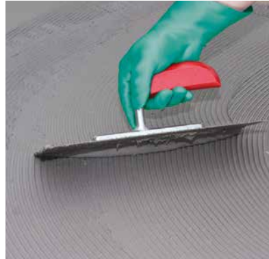
1 Die Horizontalsperre aus z.B. Sopro ZR Turbo XXL oder Sopro TurboDichtSchlämme 2-K lässt sich leicht auf den vorgewässerten Fundamentbeton schlämmen.
