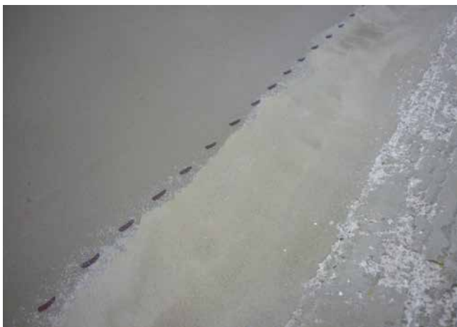
3 Optimal vorbereitete Übergangszone für den Anschluss der neuen Verbundabdichtung.
