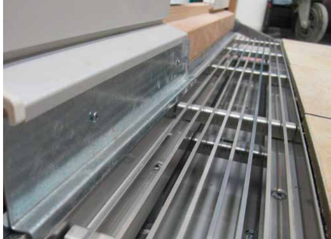
8 Zum Schutz der Abdichtung und einer sauberen Ableitung des Wassers von der Tropfkante des Türelementes in die Rinne (ACO) ist ein Blech vom Spengler einzusetzen und zu fixieren.
