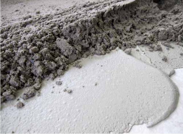
Einarbeiten des Estrichmörtels „frisch-in-frisch“ in die Haftschlämme.
