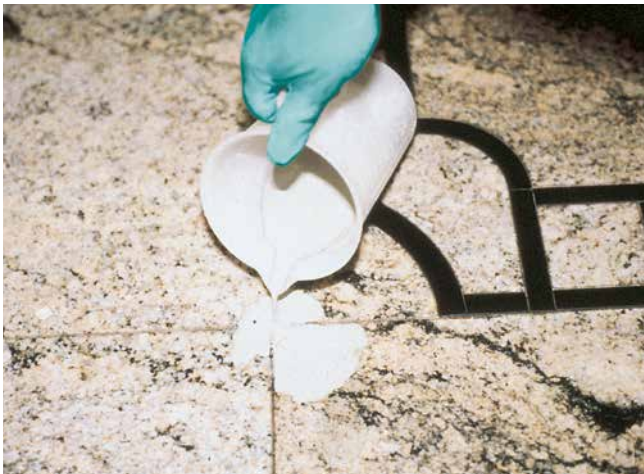
Verfüllen über eine offene Fuge.
