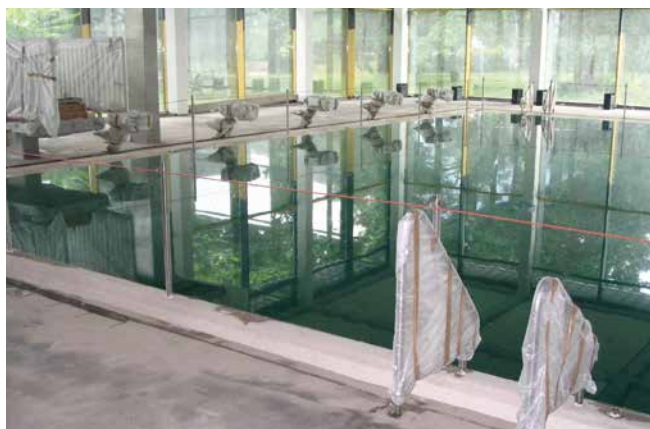
12 Dichtigkeitsprüfung (mind. 14 Tage).
