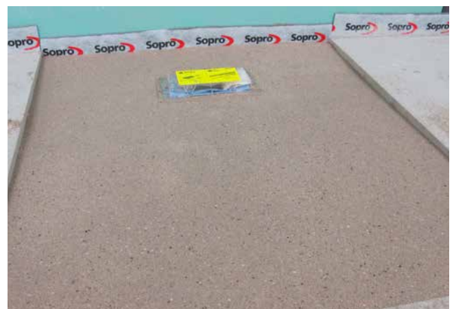
6 Duschfläche hergestellt mit harzgebundenem Estrichmörtel, bereit für die folgenden Abdicht- und Fliesenarbeiten.
