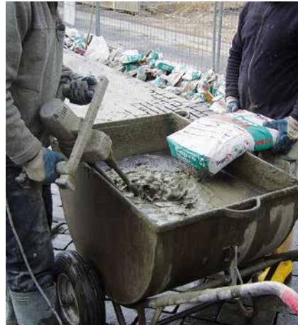
Anmischen des Fugenmörtels mittels Rührgerät.
