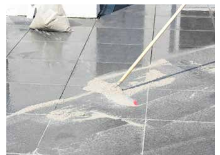
Leichtes Verfugen der Sopro Solitär® F20 mittels Wasserschlauch und Gummischieber.
