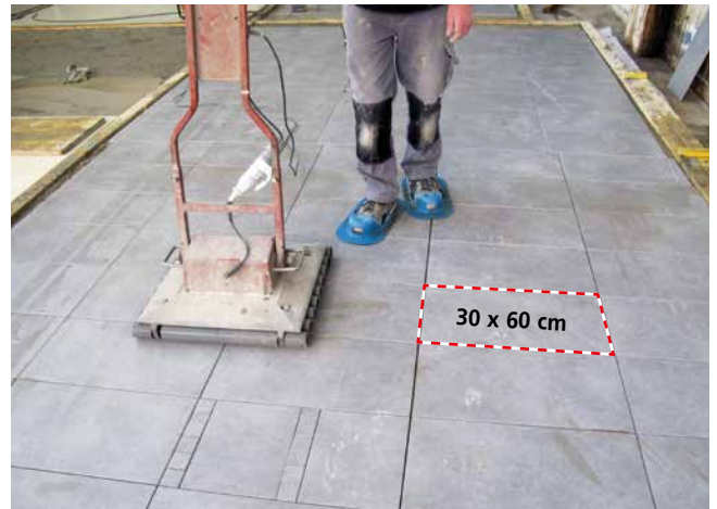
Einrütteln von 30x60 cm Platten mit einem Oberflächen-Rollrüttler in die Sopro RüttelSchlämme.
