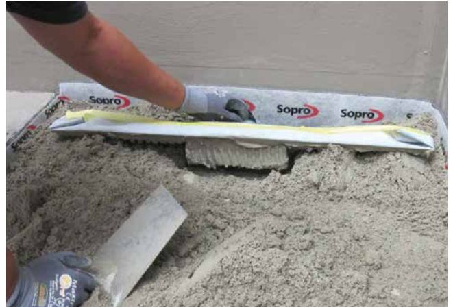
2 Einbau der Rinne mit Sopro Rapidur® M1/Sopro Rapidur® M5 sowie Sopro's No. 1 S1 Flexkleber (Dünnbettmörtel) als Haftbrücke zwischen Rinnenkörper und Estrich.
