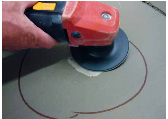
Anschleifen der Schnittkanten zur Herstellung einer Übergangszone.
