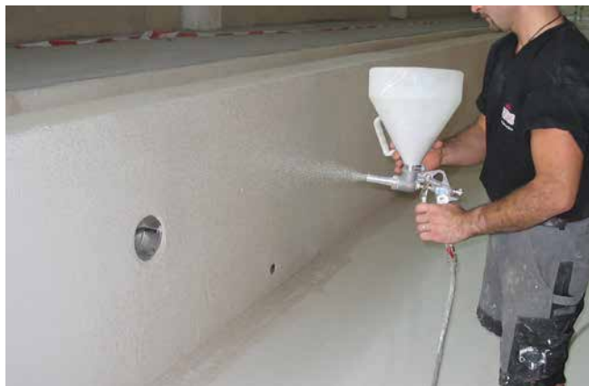
10 Abstreuen der mit Sopro PU-FlächenDicht Wand abgedichteten Fläche mit Quarzsand mittels Trichterpistole.
