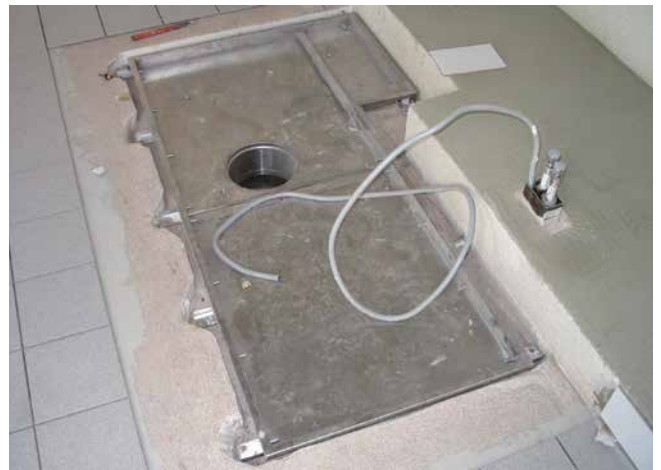
Eingesetzte Rinne in abgedichtete Rinnenmulde.
