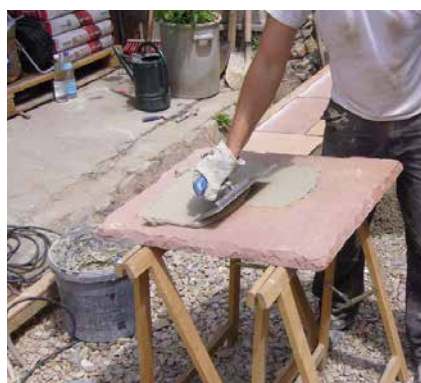
Speziell bei großen Platten ist das Auftragen einer Haftbrücke und das Arbeiten „frisch-in-frisch“ entscheidend für die Langlebigkeit der Konstruktion.
