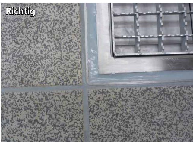
Rinne mit Edelstahlrahmen. Die Situation der Bewegungsfuge ist besser gelöst und dadurch langlebiger.
