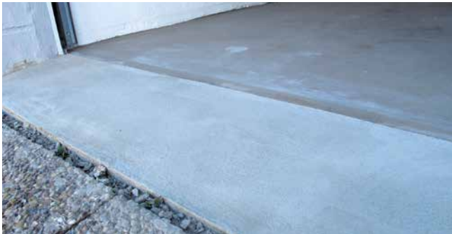
Spachteln von Anrampungen z. B. im Garagentorbereich.
