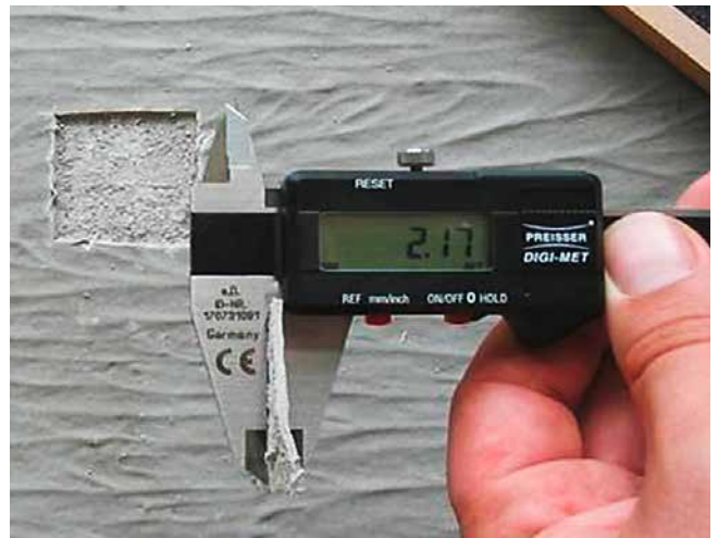
Die Schichtdicke der Ausbauprobe wird mittels Schieblehre ermittelt.
