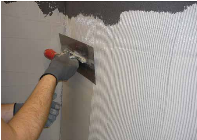
5 Aufzählen der Sopro DichtSchlämme Flex 1-K mit einer 4er-Zahnung, welche anschließend glatt gezogen wird, zur Erreichung der notwendigen Mindestschichtdicke je Arbeitsgang.
