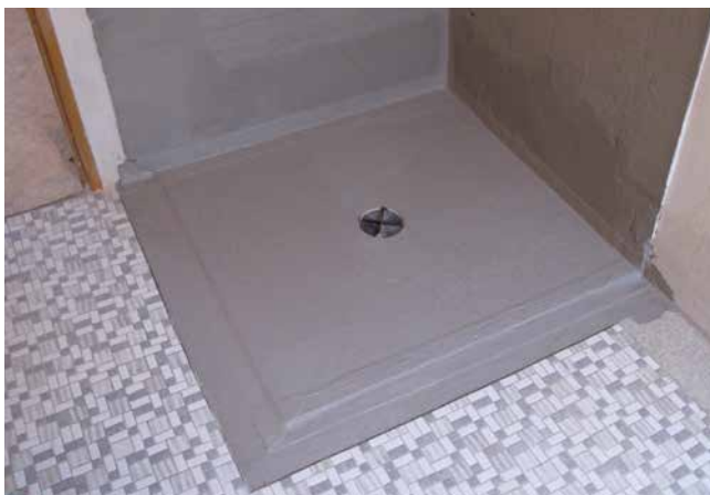
5 Abgedichtetes Duschelement mit Sopro DichtSchlämme Flex 2-K, ausgeführt in zwei Arbeitsgängen.
