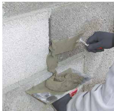
3 Schlecht vermörtelte Fugen und Vertiefungen von mehr als 5 mm sind mit Sopro RAM3® Renovier- & Ausgleichsmörtel zu schließen.
