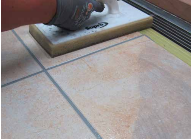
7 Die Verfugung der Fläche erfolgt mit Sopro FlexFuge plus.
