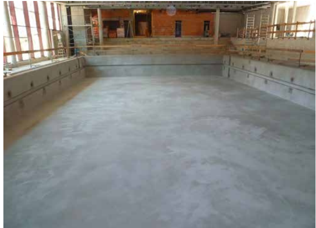
Das neue Betonbecken sollte ein Alter von 6 Monaten besitzen.
