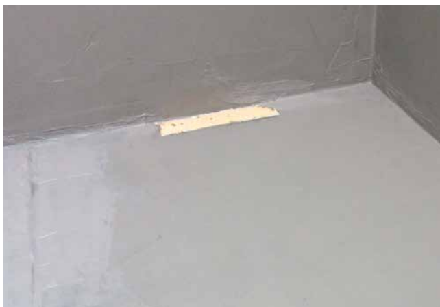
5 Abgedichtete Fläche mit Sopro TurboDichtSchlämme 2-K, bereit für die folgende Fliesenverlegung.
