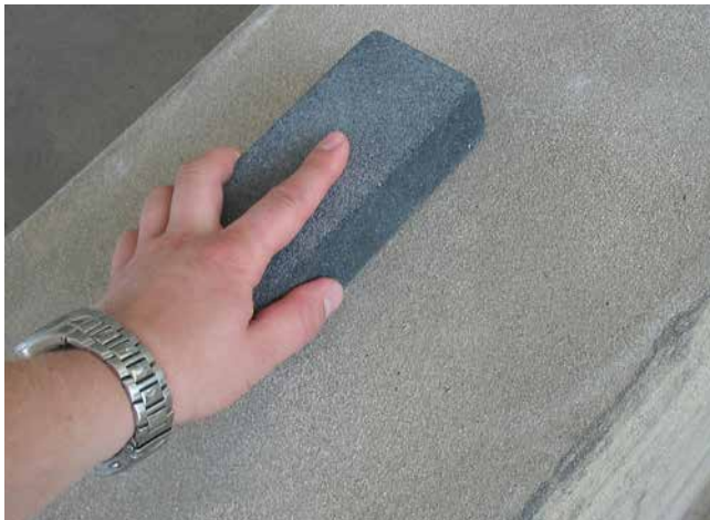
3 Überarbeiten der abgesandeten, trockenen Flächen mit Korundstein.
