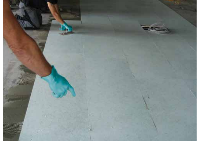
2 Verlegung der Sopro FliesenDämmplatte zur Entkopplung des Oberbelages (Naturstein).
