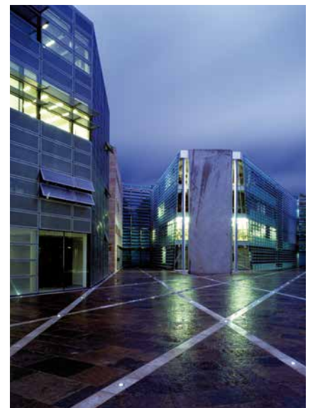
Naturwerkstein im Außenbereich.
