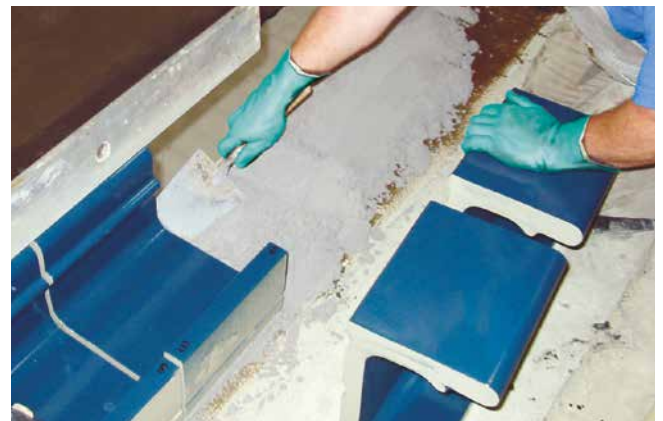
Versetzen von Beckenkopfsteinen mit Sopro EpoxiMörtel.
