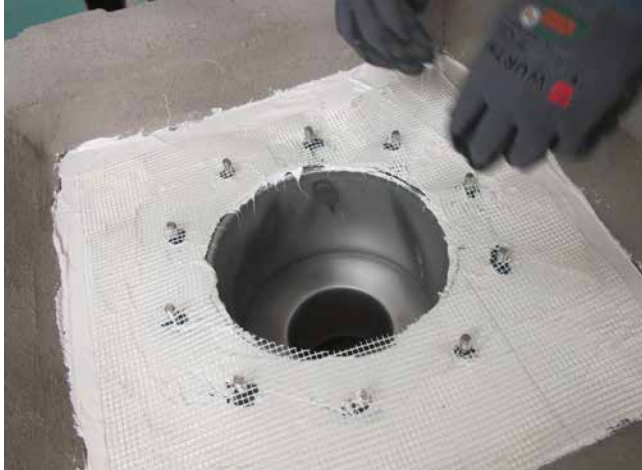
Verarbeitung von Sopro PU-FlächenDicht und Anschluss an den Flansch. Im Bereich des Flansches wird Armierungsgewebe mit eingebettet.
