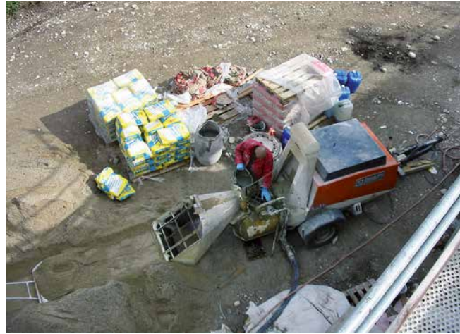
Herstellung eines Zementestrichs mit einer Estrichpumpe.
