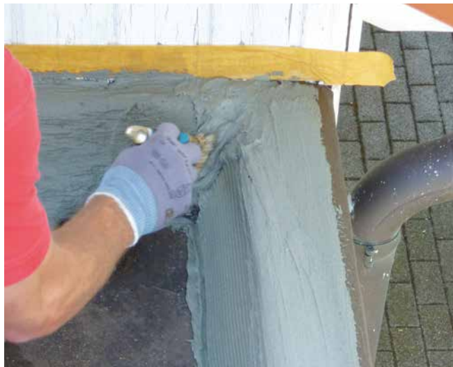
Abdichten einer Betonaufkantung an einem Dach.
