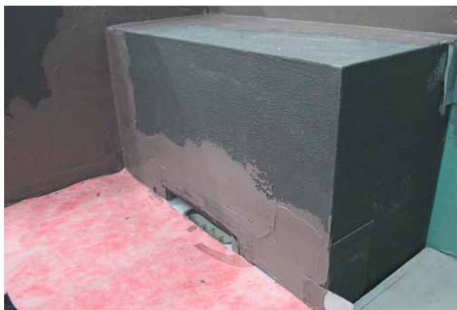
6 Schedel bietet für die Xetis-Wanne auch eine Sitzbanklösung, die für eine Badgestaltung sehr interessant sein kann. Die Entwässerung der Xetis-Wanne wird über das Schedel-Element geführt. Alle Flächen werden mit Sopro TurboDichtSchlämme 2-K abgedichtet.
