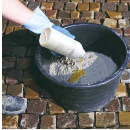
Härterzugabe zum Sand-Harzmischung.
