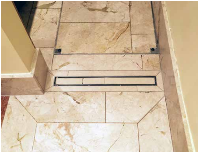
Rinne im Bereich des Durchganges.
