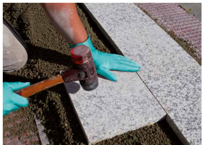
4 Einklopfen der Natursteinplatte in den vorbereiteten drainagefähigen Dickbettmörtel.
