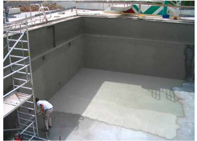
Abdichten eines Springerbeckens im Spritzverfahren.
