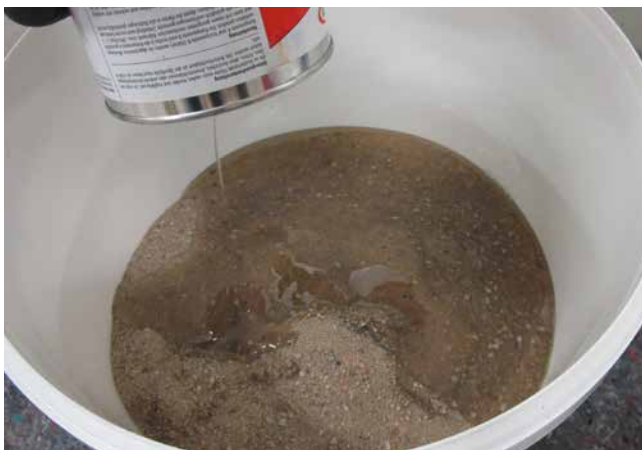
3+4 Anmischen eines harzgebundenen Mörtels zur Herstellung eines dünnschichtigen Estrichs (Sopro Bauharz und Sopro EpoxiEstrichKorn).
