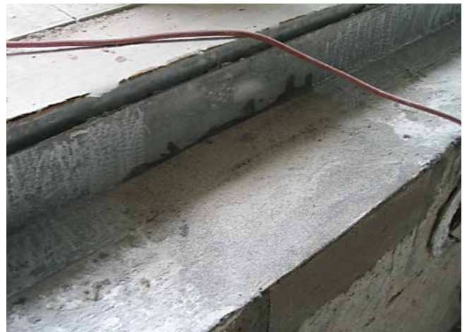
Vorbehandelter Entwässerungskasten mit Reaktionsharz und Gewebeeinlage.
