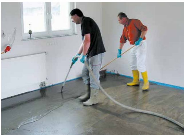
Leichtes Einbringen des Sopro Fließspachtel hochfest HF-S mit der Maschine.
