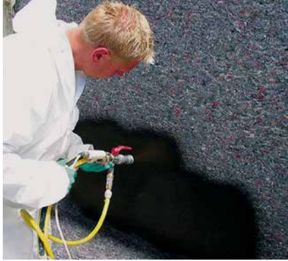
16 Spritzen der Bitumen-Dickbeschichtung mit der Förderpumpe Inomat M8 der Firma Inotec.
