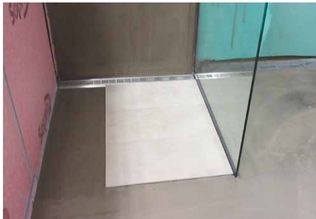
6 Die Abdichtung des Bodens erfolgte mit Sopro TurboDicht-Schlämme 2-K. Zur Bewertung der Einteilung der Fliesen sind bereits einige Fliesen in der Duschfläche ausgelegt.
