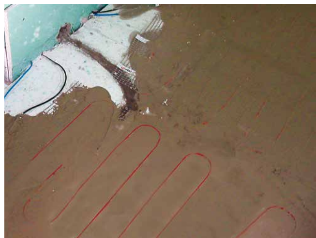
Elektro-Fußbodenheizung eingebettet in Sopro's No. 1 S1 Flexkleber.
