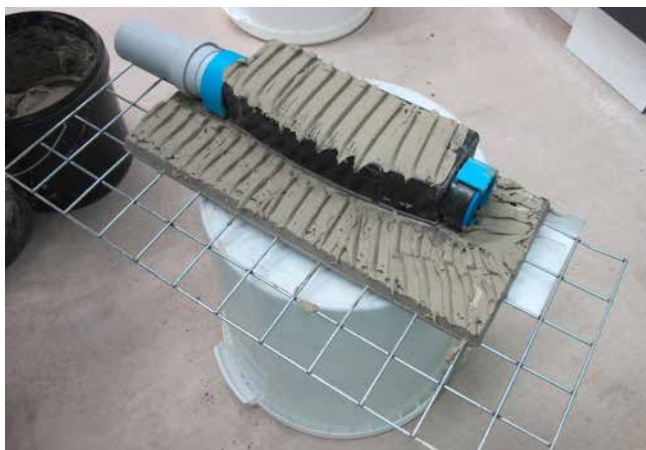
1 Abspachteln des Dallmer Bodenablaufelementes mit Sopro's No. 1 S1 Flexkleber für einen guten Haftverbund zum Estrichmörtel.
