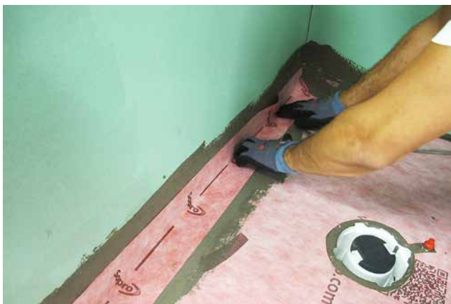
Einlegen von Dichtbändern im Bereich der Bewegungsfugen, fixiert z. B. mit Sopro TurboDichtSchlämme.
