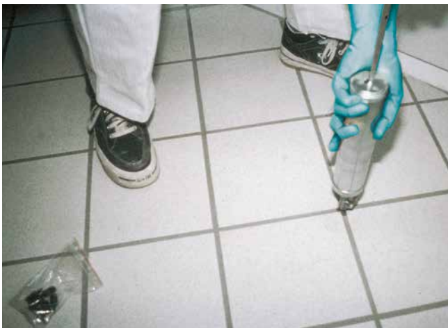
Verpressen mit Handpresse für kleine Flächen.
