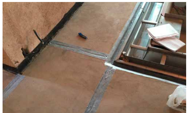
4 Überkleben der Fugen mit Sopro FlexDichtBand als Unterlage für die folgende Abdichtung mit Sopro PU-FlächenDicht.
