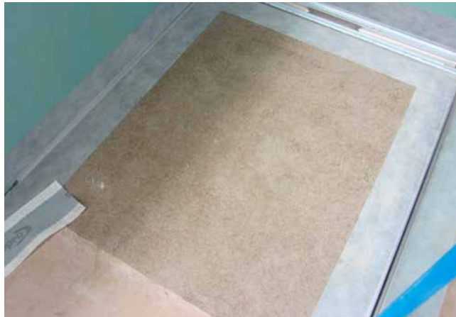
2 Die Rinne ist mit Sopro Rapidur®M1/Sopro Rapidur®M5 ersetzt. Anschließend erfolgt die Verklebung der Dichtbänder.
