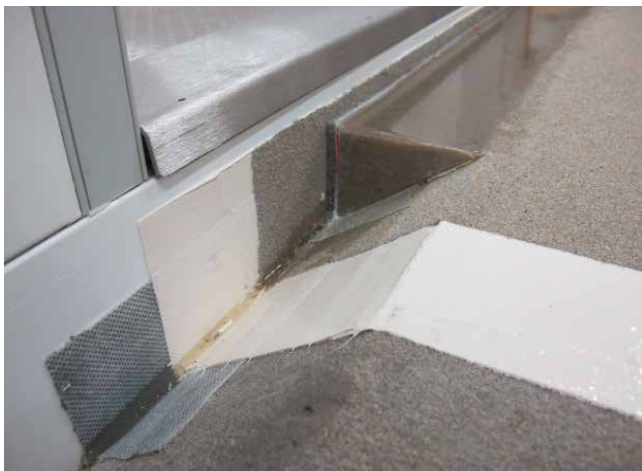
Sopro PU-Flächendicht wird im direkten Kontakt auf der Kühlzellenwand appliziert.
