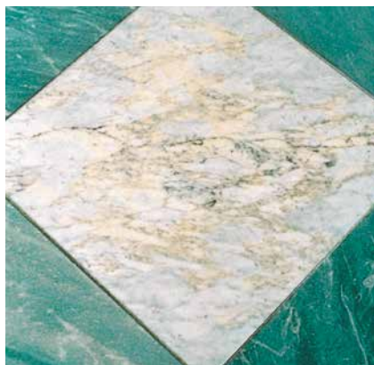
Randzonenverfärbung und farbliche Veränderungen innerhalb der Platten aufgrund des hohen Feuchtepotenzials im Dickbettmörtel.
