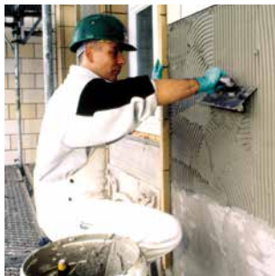
Kombiniertes Verfahren Untergrund.
