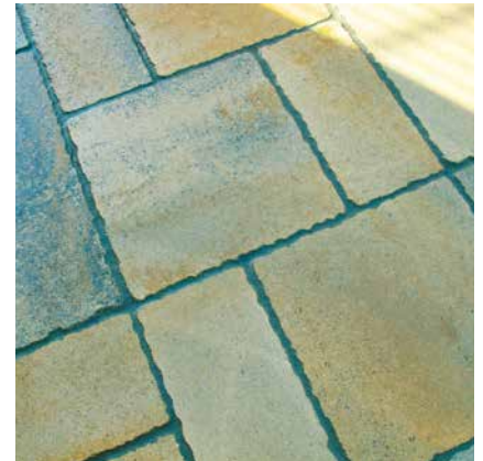
Auch Großpflastersteine lassen sich so dauerhaft verfugen.
