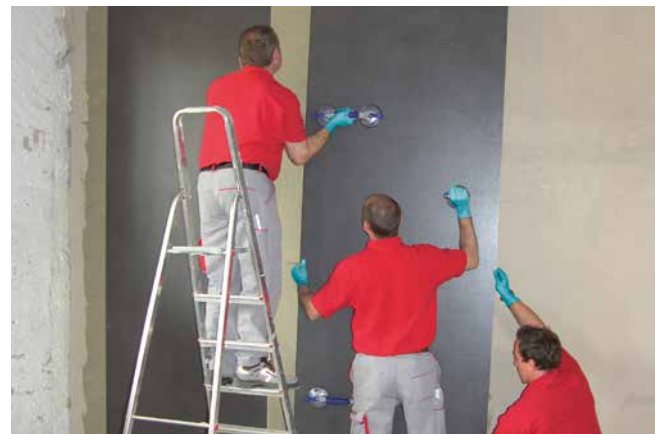
Ansetzen einer Großformatplatte an der Wand mit Sopro MG-Flex ® XXL schnell.
