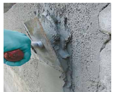
Ausgleichen von Mauerwerk mit Sopro RAM 3® Renovier- & Ausgleichsmörtel für das Ansetzen von Fliesen und Platten im Dünnbettverfahren.
