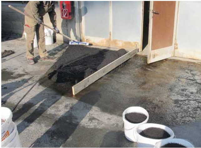
Herstellen einer Zufahrtsrampe.
