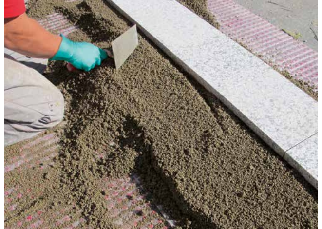
2 Vorbereiten des Drainage-Dickbettmörtels für die „frisch-in-frisch“-Verlegung.
