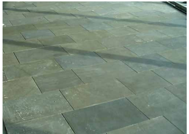
4 Fertig verlegte Fläche.
