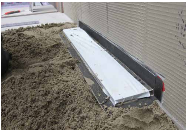
2 Setzen der Rinne in den frischen Zementestrichmörtel (Sopro Rapidur® M1/Sopro Rapidur® M5).
