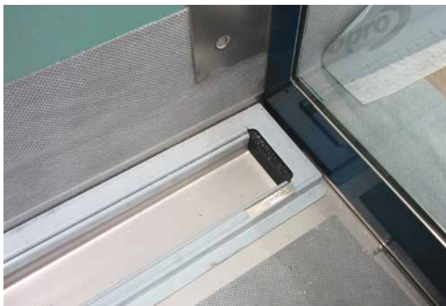
3 Das Detail Rinnenende mit Glasscheibenverwahrung ist gut gelöst.
