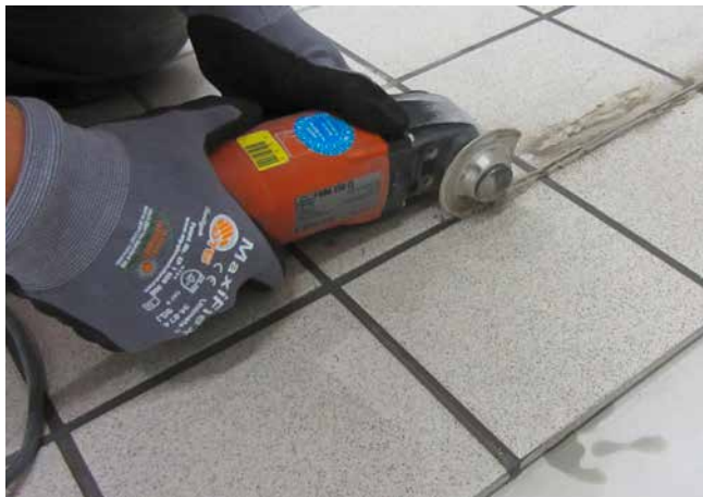
1 Herausschneiden der Fugen an der ersten Fliesenreihe.
