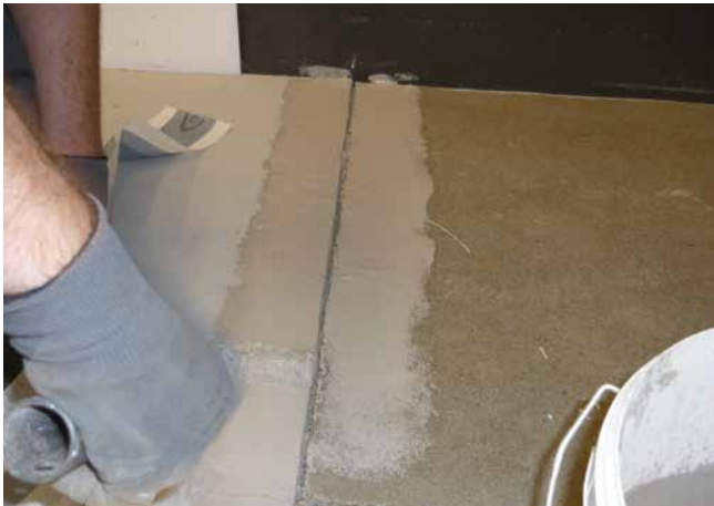
3 Vorlegen der Sopro DichtSchlämme Flex 1-K zur Fixierung der Sopro Dichtbänder im Bereich von Bewegungsfugen etc.
