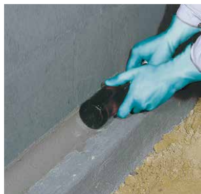
5 Im Eckbereich zwischen Bodenplatte und Wandbereich wird eine Hohlkehle mit Sopro RAM3® Renovier- & Ausgleichsmörtel ausgebildet.
