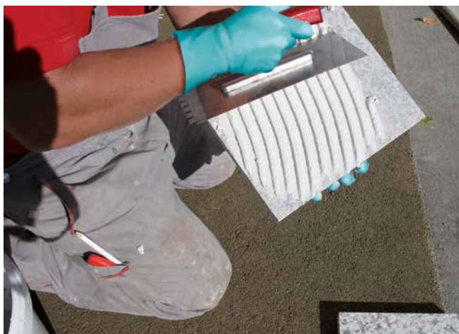
5 Rückseitiges Aufkämmen (Buttering-Verfahren) des Dünnbettmörtels (Sopro Marmor- & Mosaik-Flexkleber) auf die Natursteinplatte.
