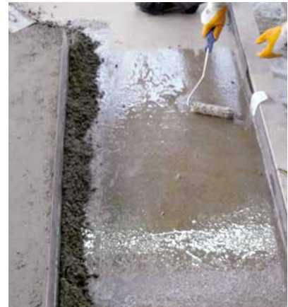
Epoxihaftbrücke für einen Verbundestrich.
