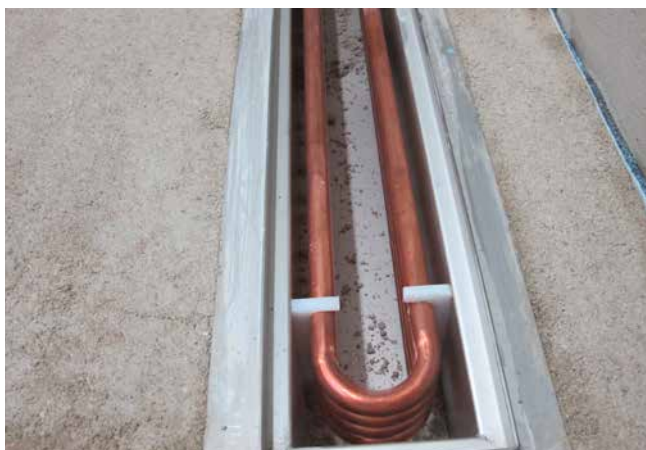
5 Gut sind die Wärmetauscherleitungen innerhalb des Rinnenkörpers erkennbar.
