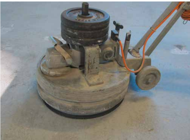
Untergrundvorbereitung ggf. durch Schleifen/Fräsen.
