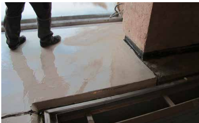
3 Grundieren der Flächen mit Sopro Epoxi-Grundierung mit anschließender Quarzsandabstreuung.
