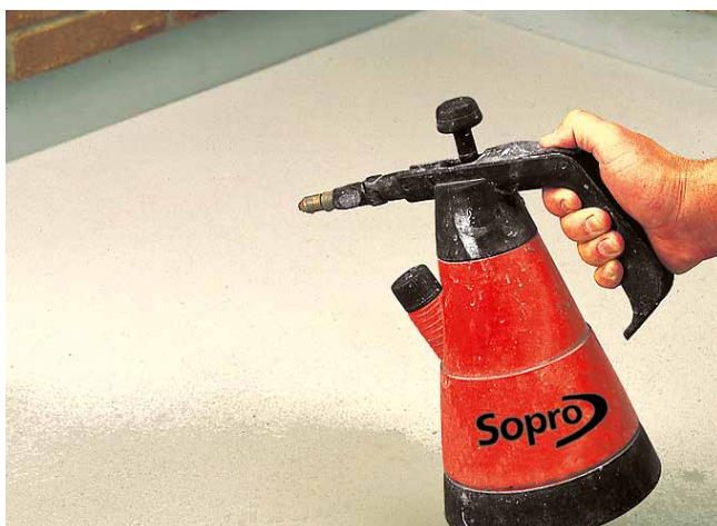
Leichtes Vornässen des Untergrundes vor der Applikation der flexiblen Dichtungsschlämme.
