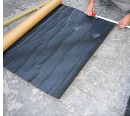
3 Zuschneiden der notwendigen SoproThene® Teilstücke.
