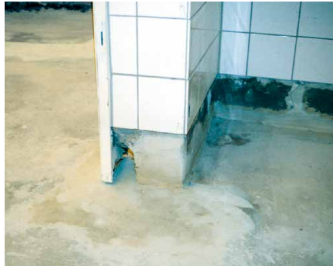
Türzargenhinterschneidung.
