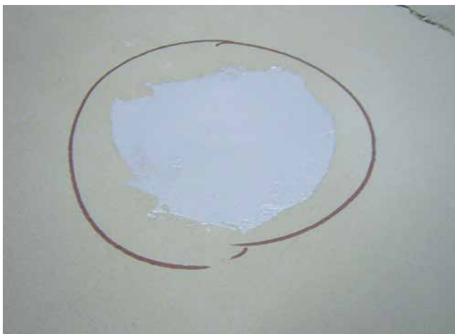
Sauber aufgefüllte Messstelle und somit ergänzte Abdichtfläche.
