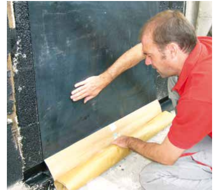
12 Andrücken der SoproThene® über die gesamte Wandfläche.
