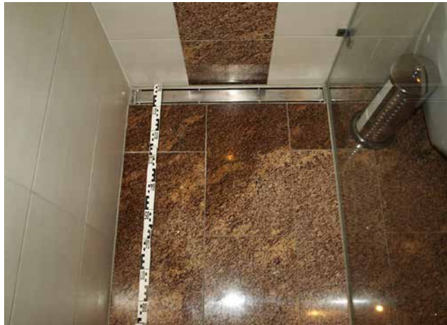
Dusche mit Randzonenverfärbungen im Naturstein nach mehrfacher Nutzung.
