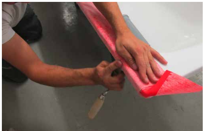
4 Die Bänder sind mittels Spachtel oder Roller fest an den Wannensrand anzudrücken.
