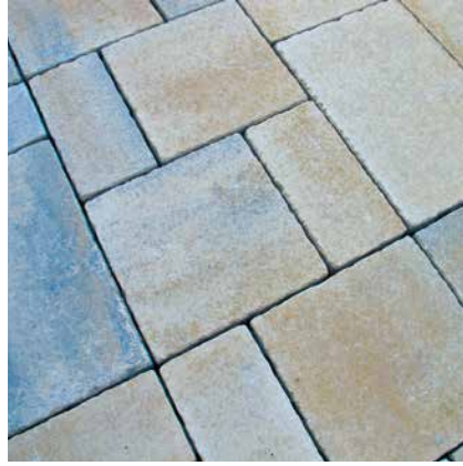
Auch großformatiges Betonpflaster lässt sich in der gebundenen Bauweise verlegen und zementär verfugen.
