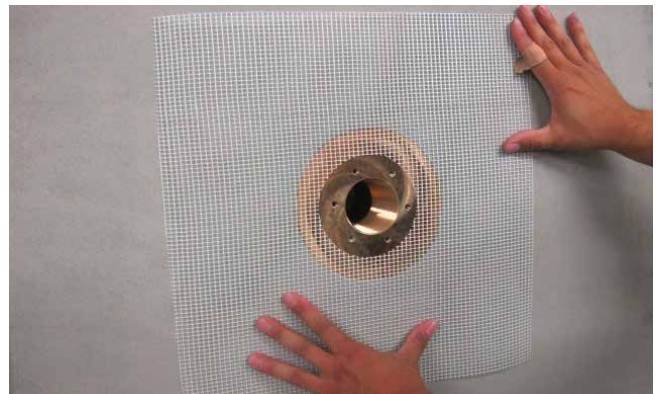
2 Nach der Reinigung des Flansches ist ein Abdichten sofort möglich. Zur Verstärkung ist ein Armierungsgewebe einzufügen.
