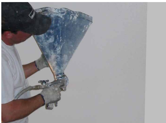
8 Aufbringen von Sopro Quarzsand grob als Haftbrücke in die frische zweite Sopro PU-FlächenDicht Abdichtungsschicht.
