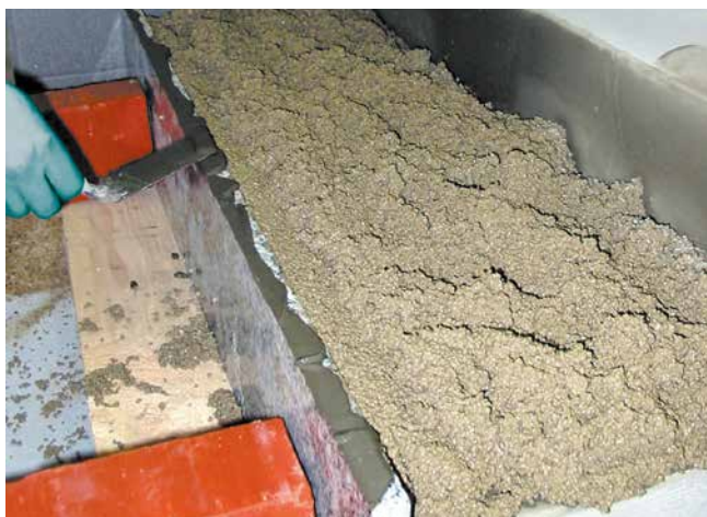
5 Vorbereitetes Drainagemörtelbett zur Aufnahme der Trittstufe.
