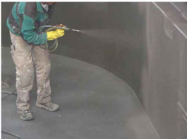
1 Applikation von Sopro TurboDichtSchlämme 2-K in zwei Arbeitsgängen im Spritzverfahren.
