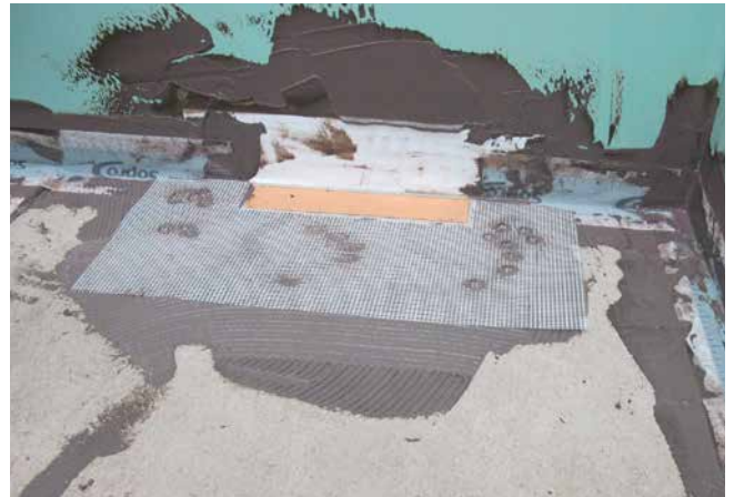
4 Abdichten des Bodenablaufelementes und der Fläche mittels Dichtbändern, Gewebeeinlagen und Sopro TurboDichtSchlämme 2-K.
