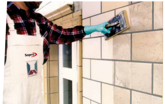
Abwaschen der eingeschlämmten Flächen.
