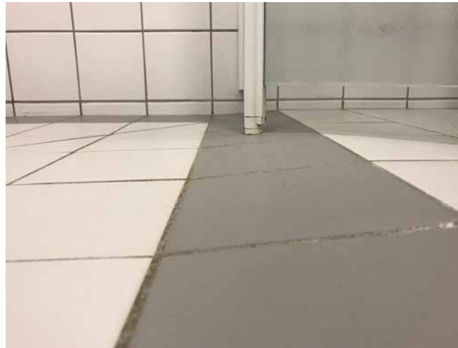
Gut erkennbar ist die Schrägstellung der Formfliese.
