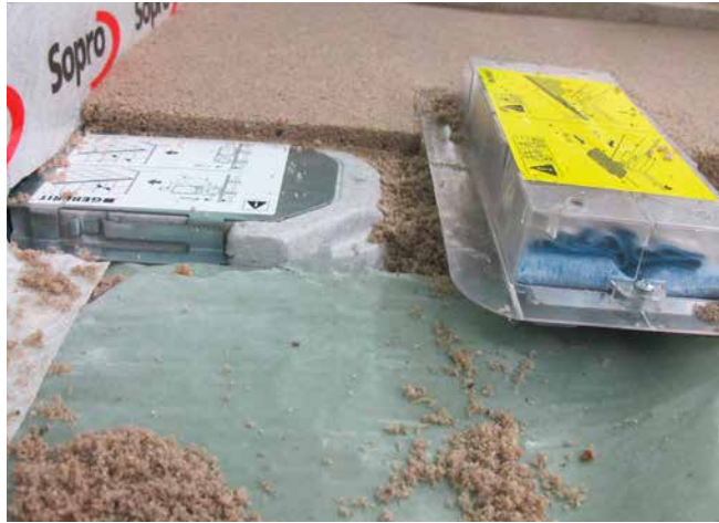
Epoxiestrichaufbau in einer Duschfläche mit geringen Aufbauhöhen.
