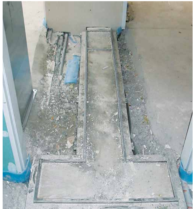
Türzarge und Rinne in Kombination – die Ausführung einer fachgerechten Abdichtung ist hier nicht möglich.
