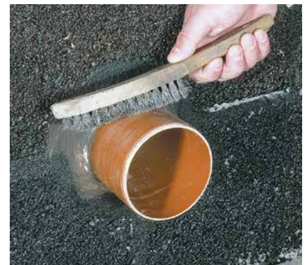
2 Nach Aushärtung der Hohlkehle wird die Oberfläche des Rohres mit einer Drahtbürste oder grobem Schleifpapier aufgeraut.
