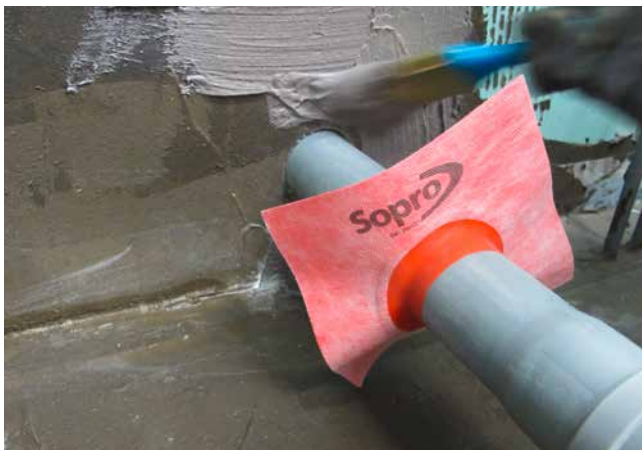
Rohre für die Entwässerung der Wanne lassen sich mittels der Sopro AEB 130 Wandmanschette sicher eindichten.
