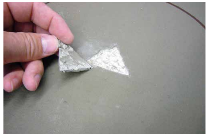
Herausgeschnittenes Abdichtungsstück zur Ermittlung der Schichtdicke.
