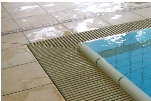
Sehr schön ist der hochliegende Wasserspiegel bei der Wiesbadener Rinne erkennbar, der etwa 3–4 cm höher steht als die Oberkante des Beckenumgangsbodens.
