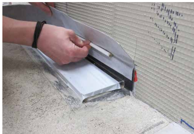
3 Verkleben des Sopro FlexDichtBandes mit Schlaufe als Übergang zwischen dem Metallflansch der Rinne und den angrenzenden Baustoffen.
