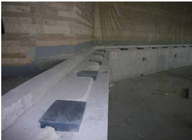
Entwässerungskästen zur Fixierung ausgerichtet.
