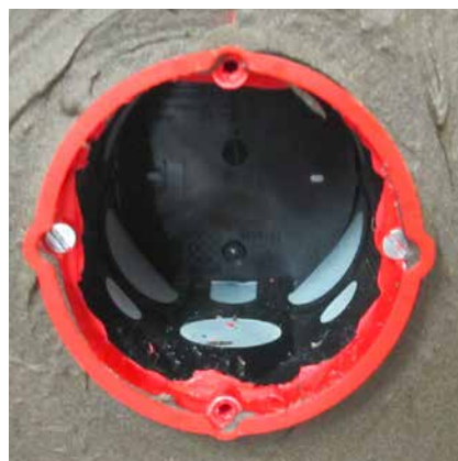
5 Eingedichtete Installationsdose.
