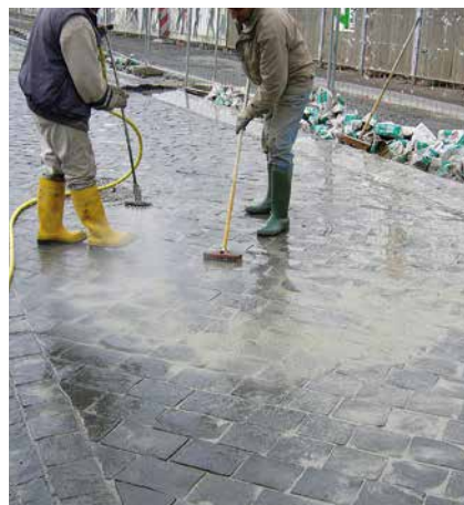
Reinigung mittels Sprühlanze.
