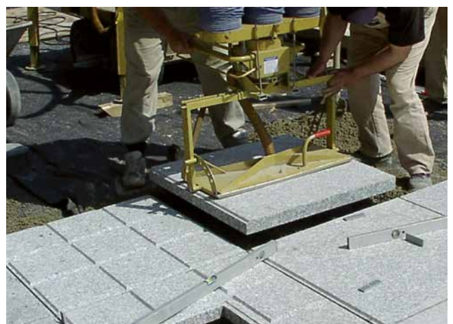
6 Maschinelles Versetzen der mit einem Haftvermittler (Sopro HaftSchlämme Flex) vorbereiteten Platte im Dickbett.
