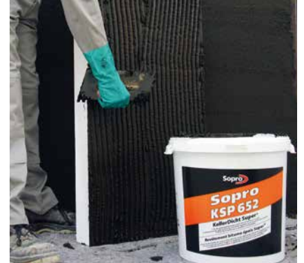
18 Nach vollständiger Durchtrocknung werden geeignete Drainage- oder Dämmplatten, z.B. Sopro KellerDrainSystem, auf die Abdichtung geklebt. Hierzu wird Sopro KellerDicht Super+ vollflächig auf den Platten verteilt.
