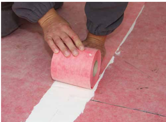
9 Überkleben des Stoßbereiches mit dem Sopro AEB® Dichtband. Optional kann die wasserdichte Verklebung des Dichtbandes auch mit Sopro Racofix® Montagekleber S oder Sopro TurboDichtSchlämme 2-K erfolgen.
