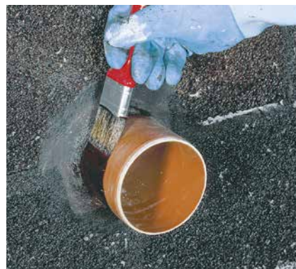
3 Um eine bessere Anhaftung der Bitumen-Dickbeschichtung an das Rohr zu gewährleisten, wird mit einem Pinsel Sopro KellerDichtGrundierung Konzentrat oder Sopro KellerDichtVoranstrich aufgetragen.
