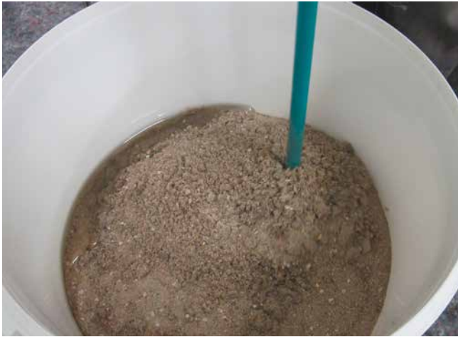
Anmischen von Reaktionsharzestrichmörtel.
