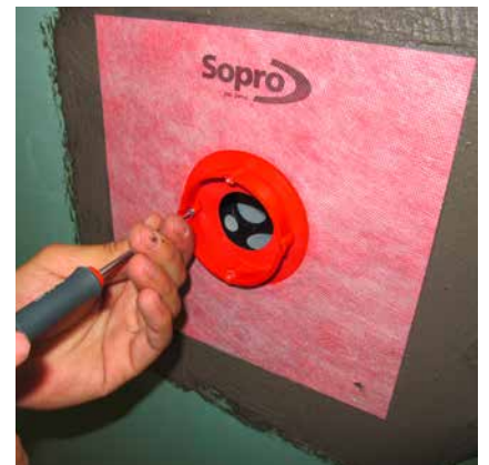
3 Aufschrauben des Aufsatzrings.
