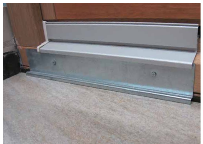
6 Die Fliesenverlegung erfolgt im Dünnbettverfahren mit Sopro megaFlex S2. Zum Türelement hin erfolgt der Abschluss mit einer Schiene.
