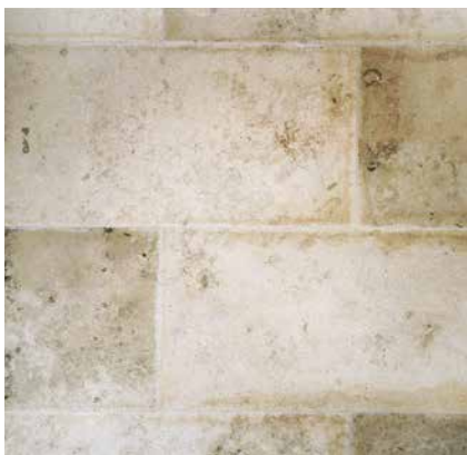
Randzonenverfärbung und farbliche Veränderungen innerhalb der Platten aufgrund des hohen Feuchtepotenzials im Dickbettmörtel.
