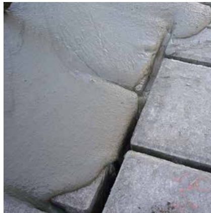
Sopro BetonSteinFuge erlaubt aufgrund ihrer Konsistenz ein leichtgängiges Einbringen und Verfüllen der Fuge.
