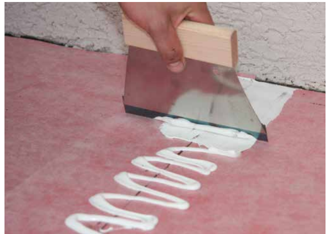
8 Verteilen des Sopro Racofix® Montageklebers mit einer Zahnleiste im Stoßbereich.
