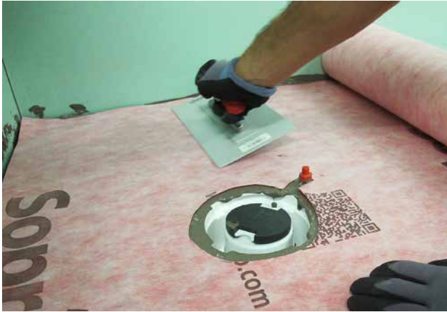
3 Die AEB®-Abdichtungsbahn ist mit Druck in den Sopro Fixier- und DichtKleber einzuarbeiten.
