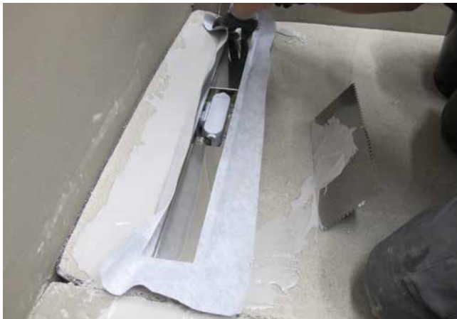
3 Eindichten des aufgeschlagenen Manschettenflansches mit Sopro DichtSchlämme Flex 1-K.
