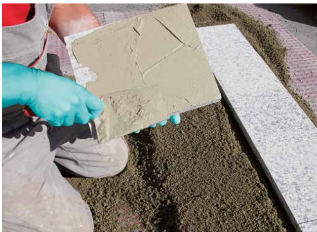
3 Auftragen eines Haftvermittlers (Sopro HaftSchlämme Flex) auf die Rückseite der Natursteinplatte.
