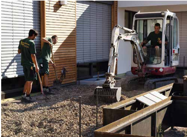
Einbau der ungebundenen Frostschutzschicht.
