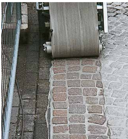
Großflächenreinigung mit Abwaschmaschine.
