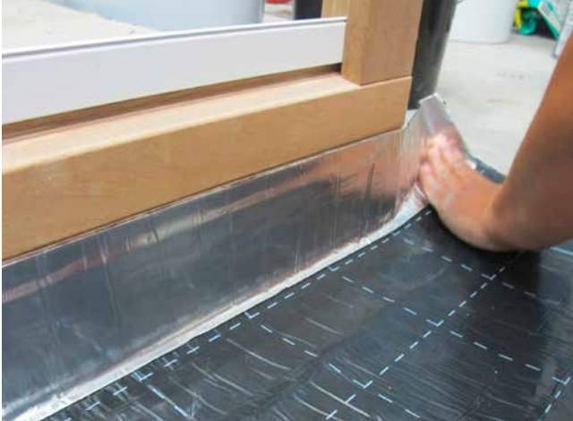
1 Bahnabdichtung mit SoproThere® Abschlussband Aluminium am Türelement.
