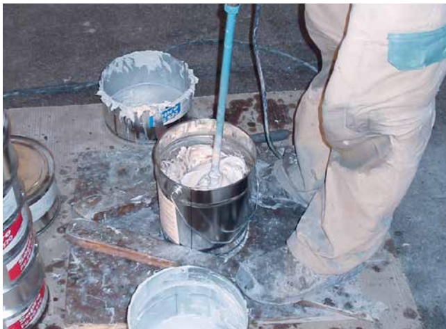
3 Sorgfältiges Anmischen der Komponenten A und B von Sopro PU-FlächenDicht mit entsprechendem Umröpfen.
