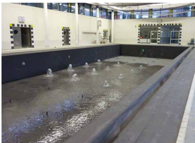
Nach Einbau und Trocknung der Verbundabdichtung wird das Becken auf Dichtigkeit geprüft.
