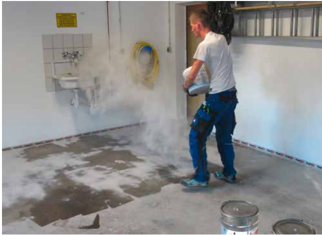
Absanden der Sopro Epoxi-Grundierung im Überschuss.
