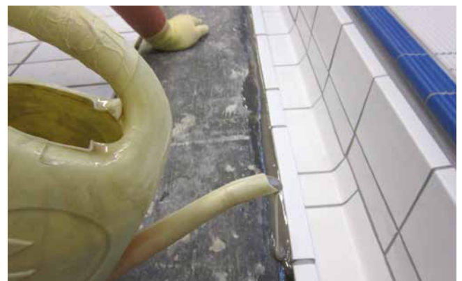
Herstellung einer kapillarbrechenden Fuge mit Sopro Epoxi-Grundierung (mit Quarzsand gemischt).
