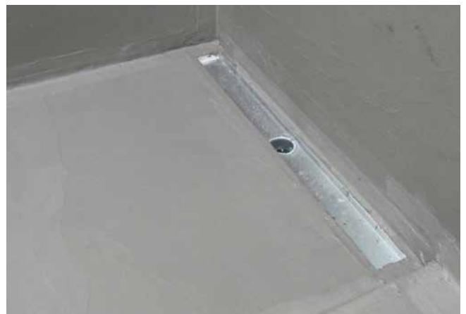
6 Abgedichtete Duschfläche (Zwei Arbeitsgänge), bereit für die Fliesenverlegung.
