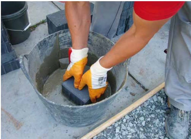
Auftragen der Haftbrücke mittels Eintauchen des Steines in die Sopro HaftSchlämme Flex.
