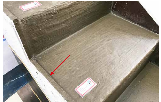
Treppenlauf seitlich mit Kante vorbereitet.
