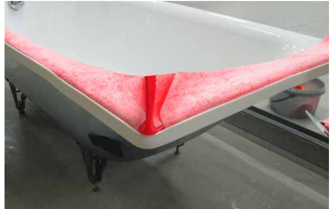
6 Fertig vorbereitete Wanne, bereit für den Einbau.
