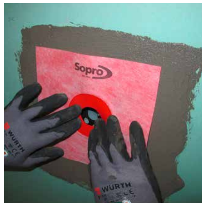
2 Einlegen der Sopro AEB® Wandmanschette.
