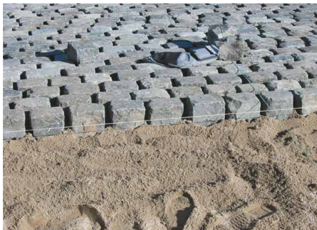
Pflastersteinverlegung mit ungebundenem Unterbau, versetzt im Sand-Kiesbett.
