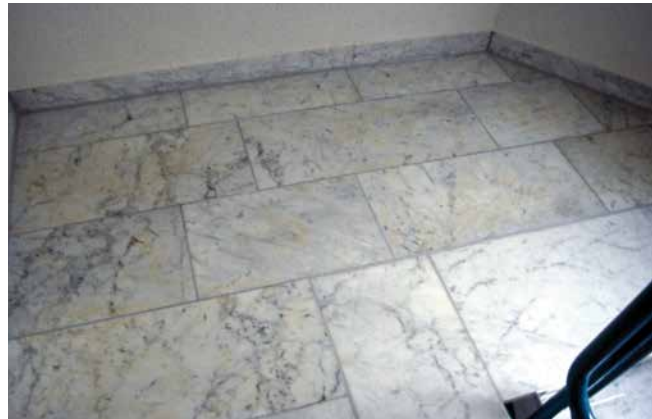
Gelbverfärbung des Natursteins, hervorgerufen durch im Stein vorhandene Pyrite, welche sich durch das hohe Feuchtepotenzial des Dickbettmörtels verändern.
