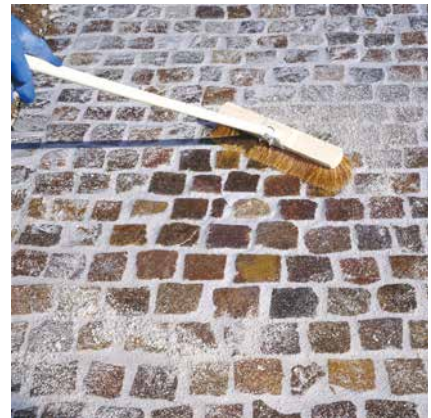
Säubern des verfugten Belages.
