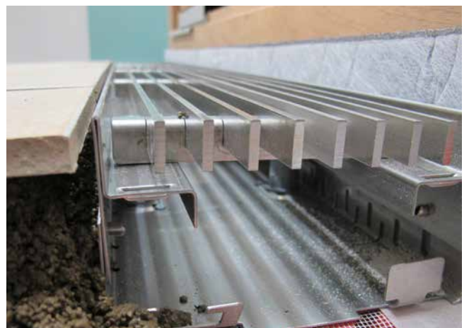
6 Die Fliesen schließen oberkantenbündig mit der ACO-Rinne ab.
