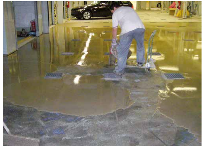
Einbau von Sopro FS 15® plus als vorbereitende Maßnahme für die folgende Verlegung von Großformatfliesen im Dünnbettverfahren.
