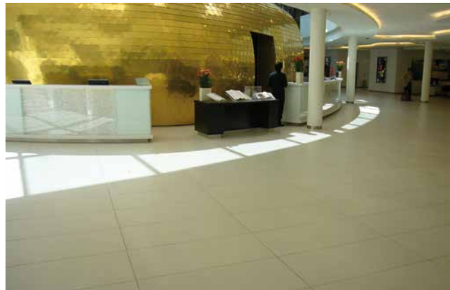
Großformatige Fliesen am Boden einer Eingangshalle verlegt.
