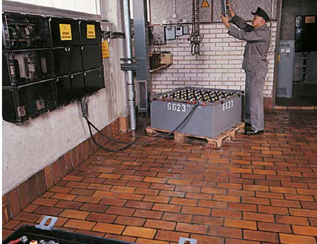
Reaktionsharzverfugung in Bereichen mit hoher Säure- und Chemikalienbelastung, z. B. Batterieladeraum.
