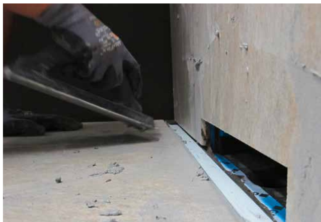
10 Die Verfugung erfolgt mit Sopro DF 10® DesignFuge Flex.
