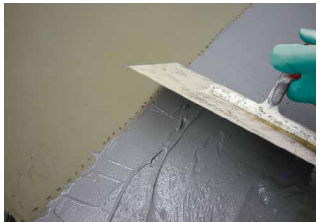
4 Flächiges, überlappendes Anarbeiten der neuen Verbundabdichtung an die Bestandsabdichtung, z. B. mit einem Glätter.
