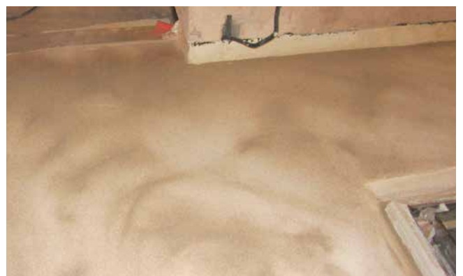
6 Abgedichteter Beckenumgang mit Anschluss an das Edelstahlbecken. Die Abdichtung mit Sopro PU-FlächenDicht ist mit Quarzsand abgestreut, bereit für die folgende Oberbodenbelegung.
