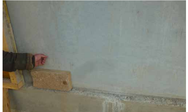
Aufstandsfläche auf der Kellerbetonbodenplatte.
