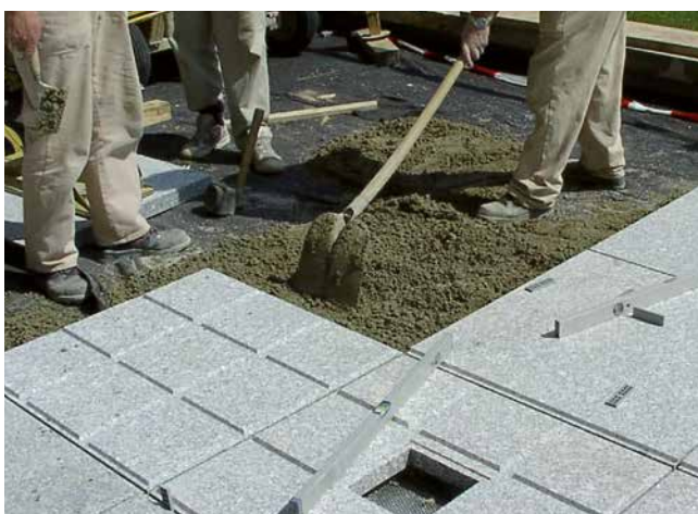
5 Verteilung von Sopro DrainageMörtel eXtra zur Verlegung einer großformatigen Platte im Dickbett.
