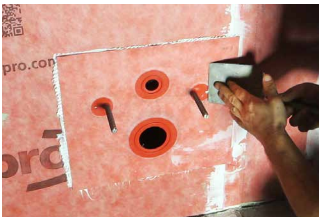
Die Sopro AEB® WC-Manschette wird fest in das Kleberbett eingedrückt/ eingearbeitet.
