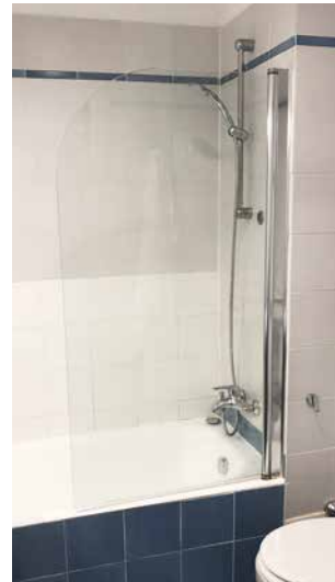
Da der Spritzwasserschutz nicht verhindern kann, dass trotzdem Wasser auf den Boden gelangt, ist der Boden in W1-I einzustufen.
