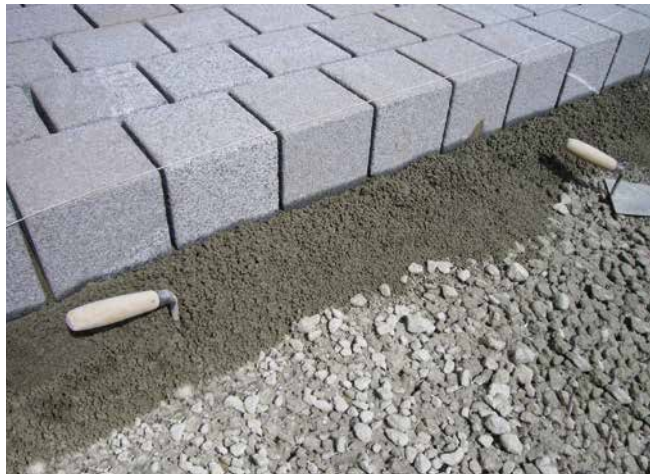
Granitpflastersteine versetzt in drainagefähigem Bettungsmörtel auf einer grobkörnigen, wasserdurchlässigen gebundenen Tragschicht.
