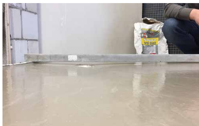
Gefällefläche, hergestellt mit VarioFließspachtel.
