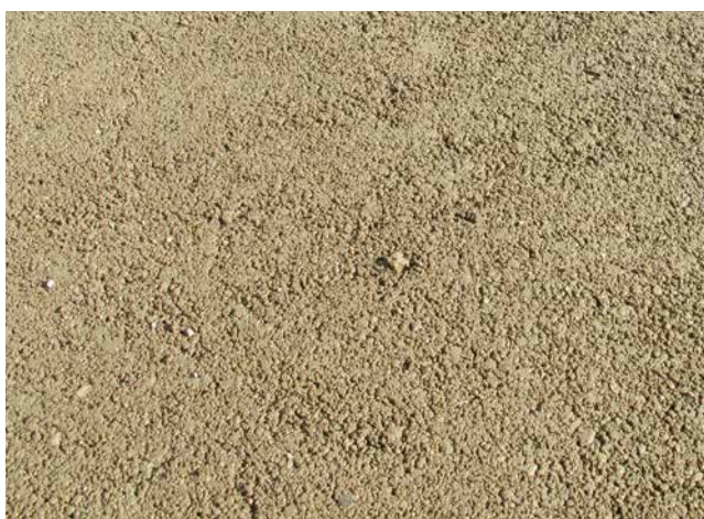
4 Abgebundene Drainage-Estrich-Konstruktion mit offener, wasser-durchlässiger Struktur.
