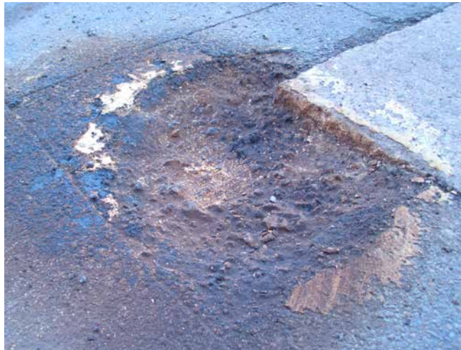
bliche Schden an unseren Straen nach einem langen Winter oder hohen Verkehrsbelastungen.
