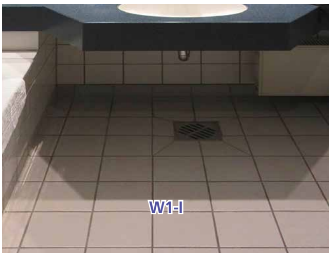
Badezimmer mit Bodenablauf von der Badewanne.
