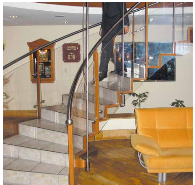
Aufgrund des Eigenschwungsverhaltens der Konstruktion ist eine hohe Spannungsaufnahme des Verlegemörtels erforderlich.
