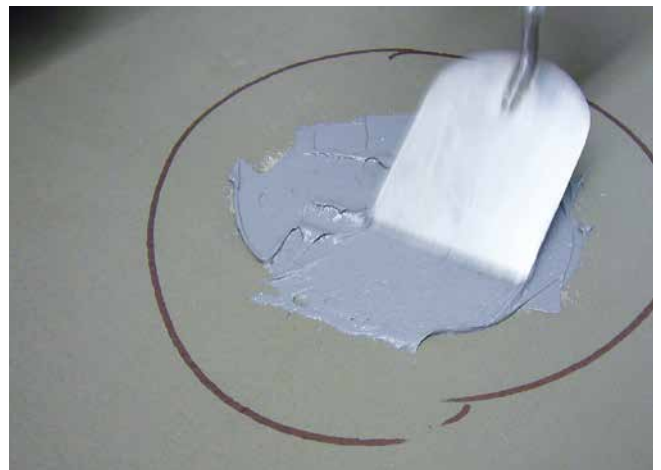
Verfüllen der Messstelle mit dem Verbundabdichtungsmaterial.
