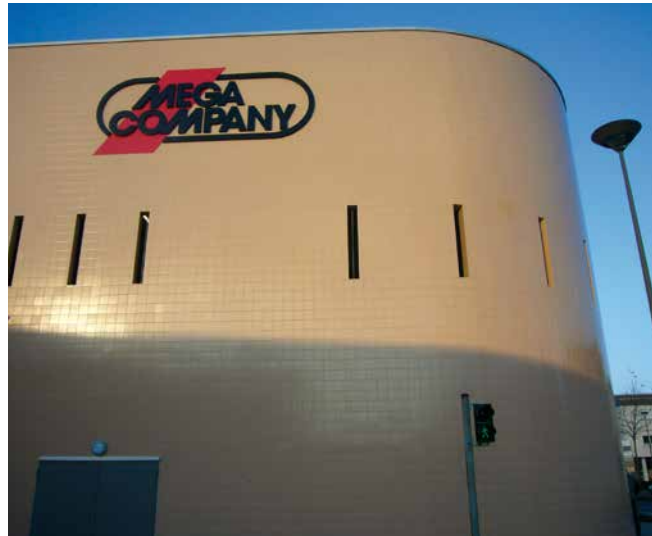
Fassade mit keramischen Fliesen.
