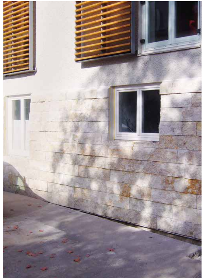
Anmauerung auf einer Aufstandsfläche.
