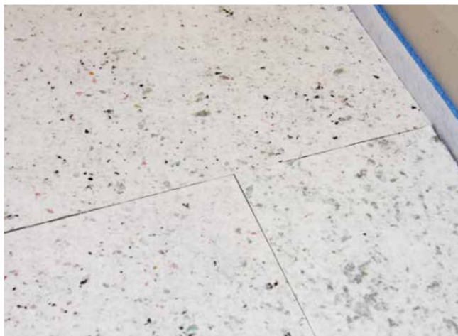
13 Die Verlegung erfolgt stoßversetzt.
