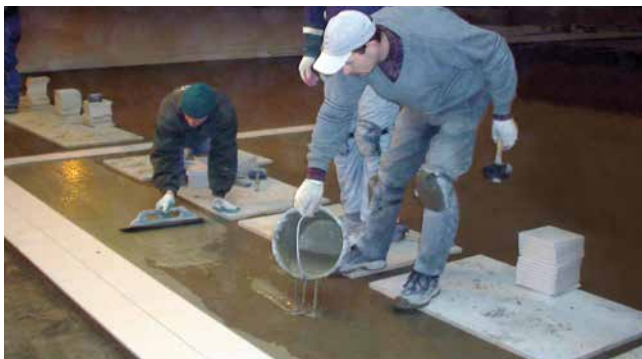
Aufbringen der Sopro RüttelSchlämme auf dem vorbereiteten Mörtelbett.
