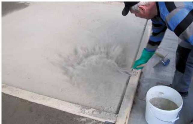
Die Pudertechnik ist generell eine kritische Verarbeitungstechnik, und bei Großformaten nicht zu empfehlen.
