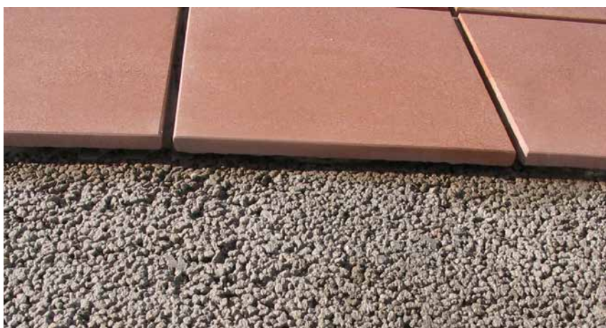
Fliesenverlegung auf Drainageestrich im Dünnbettverfahren.
