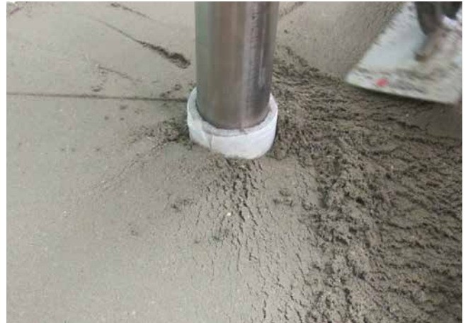
2 Einbau des lastverteilenden Zementestrichs, hergestellt mit z.B. Sopro Rapidur® B1/B5. Um das Hüllrohr ist ein Sopro RandDämm-Streifen gestellt.
