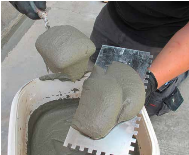
Sopro ZR Turbo XXL steht fluffig auf der Kelle damit Lunker und Unebenheiten in dicker Schicht spachtelbar sind.
