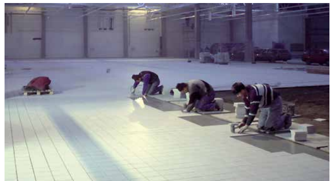
Verlegen der Keramik in die frische Sopro RüttelSchlämme.
