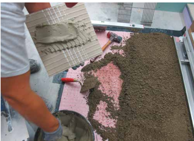
5 Die Fliesenverlegung findet unmittelbar „frisch-in-frisch“, z. B. mit Sopro megaFlex® TX, statt.
