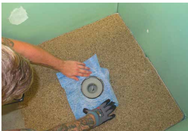
6 Entfalten der werkseitig aufgeschweißten Manschette.
