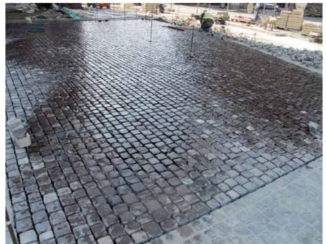
Straßenbereich, befestigt mit Natursteinpflaster.
