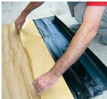
8 Abziehen des Schutzpapiers der SoproThene® von etwa 25–30 cm.
