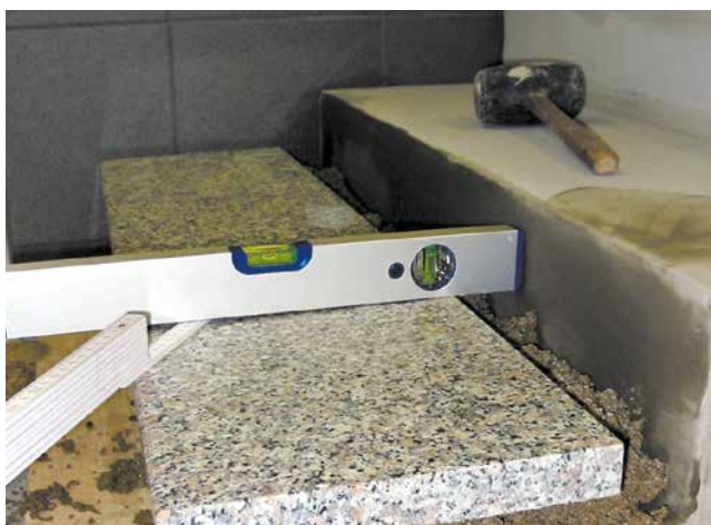
6 Fertige Stufe, versetzt mit Sopro DrainageMörtel eXtra.
