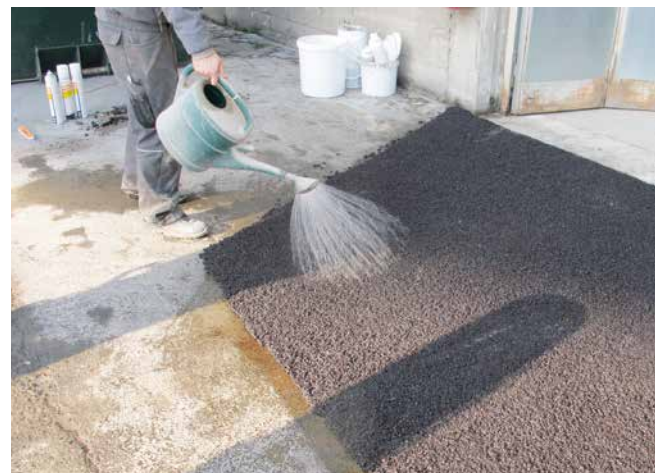
Vor dem Verdichten wird die Fläche mit Wasser befeuchtet.
