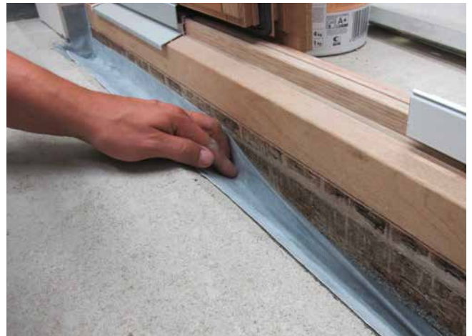
2 Einkleben des Sopro FlexDichtBandes in die abzudichtende Fuge.
