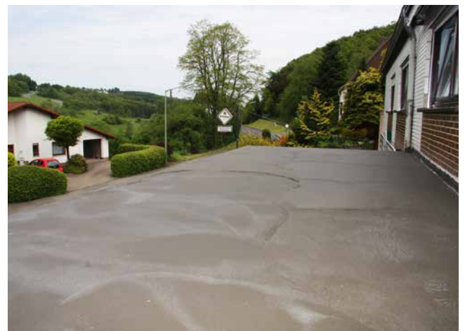
Terrasse/Balkon abgedichtet mit einer zementären, flexiblen Dichtschlämme (Sopro TurboDichtSchlämme 2-K), bereit für die folgende Fliesenverlegung.
