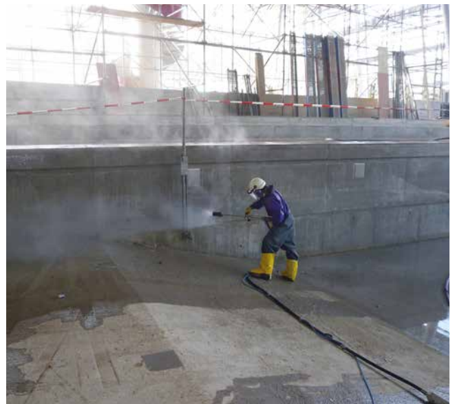
Strahlen der Betonoberfläche mit einem Sandstrahlgerät oder Wasserstrahlhochdruckgerät.
