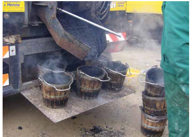
Gussasphalt wird im heißen Zustand auf der Baustelle eingebracht und verbaut.
