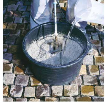
Anrühren von Sopro EpoxiPflasterFuge 2-K mit Zugabe von Wasser.
