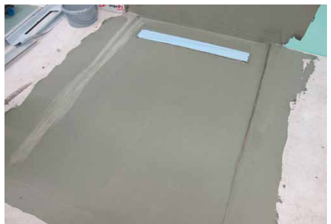
4 Abgedichtete Duschfläche in zwei Arbeitsgängen, bereit für die folgende Fliesenverlegung.
