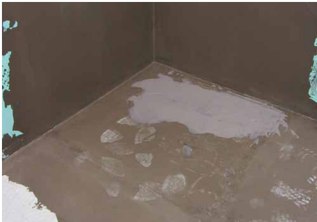
Aufgrund des Deckenaufbaus ist eine Versenkung der Duschtasse in den Boden nicht möglich. Die Boden- und Wandflächen sind mit einer Verbundabdichtung (z. B. Sopro DichtSchlämme Flex 2-K) in dieser Situation einfach abdichtbar.
