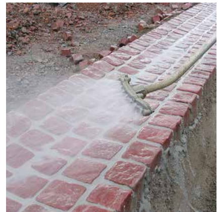
Reinigen der Fläche nach Ansteifen des Fugenmörtels mittels Sprühlanze.
