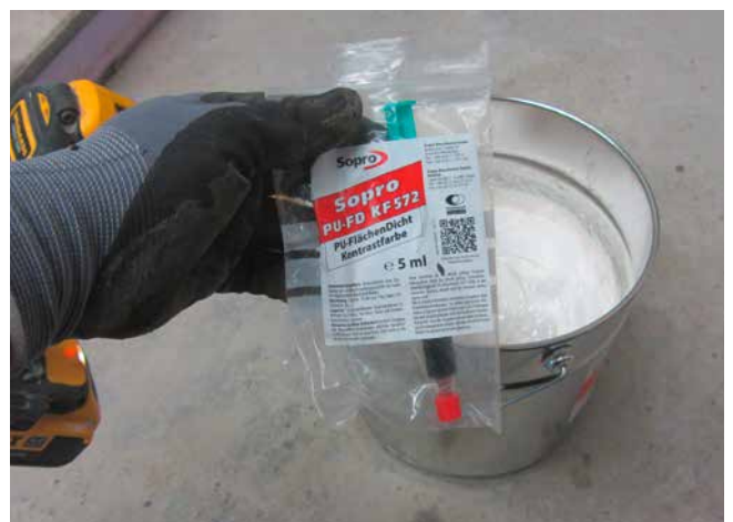
6 Sopro PU-FlächenDicht Kontrastfarbe kann dem Abdichtungsmaterial zugegeben werden, um eine bessere farbliche Unterscheidung zwischen Schicht 1 und Schicht 2 zu erhalten.
