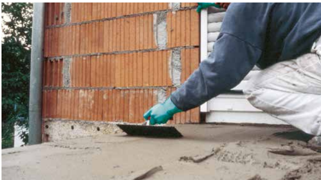
Herstellen einer Gefällespachtelung mit Sopro RAM 3® Renovier- & Ausgleichsmörtel auf einer Balkonkragplatte.
