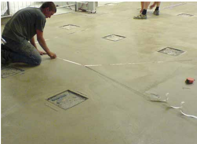
3 Aufkleben der Kupferbänder mit entsprechendem Rastermaß.
