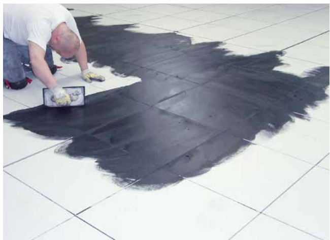
6 Verfugen der Flächen mit Sopro FlexFuge plus mit Zugabe von Sopro Electra Leitdispersion.
