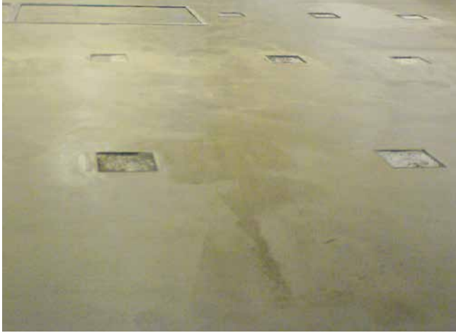
1 Mit Sopro FS 15® plus gespachtelter Boden, grundiert für die folgenden Belagsarbeiten.
