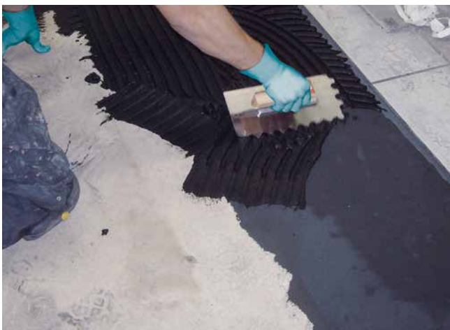
5 Verlegen der Keramik mit leitfähig eingestelltem Dünnbettmörtel.
