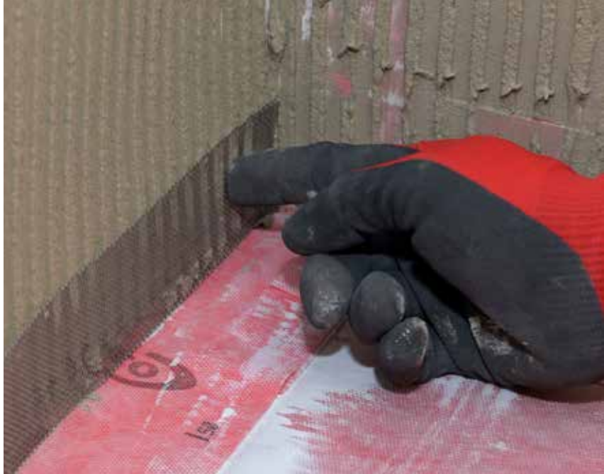
Einlegen des Sopro SchnittschutzBand SB 113
