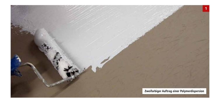
Es gibt drei Arten flüssig zu verarbeitender Verbundabdichtungsstoffe mit unterschiedlichen, von der Abdichtungsnorm DIN 18534-3 geforderten Mindesttrockenschichtdicken.
