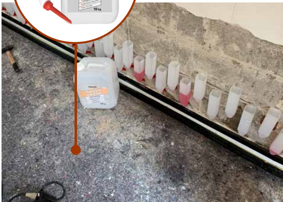
Verkieselung der Wand mit Sopro VK 690 und Sopro Verkieselungstrichtern
