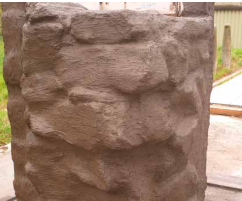
Auftrag der Negativabdichtung auf Bruchstein und Kalksand in einem Versuchsaufbau
