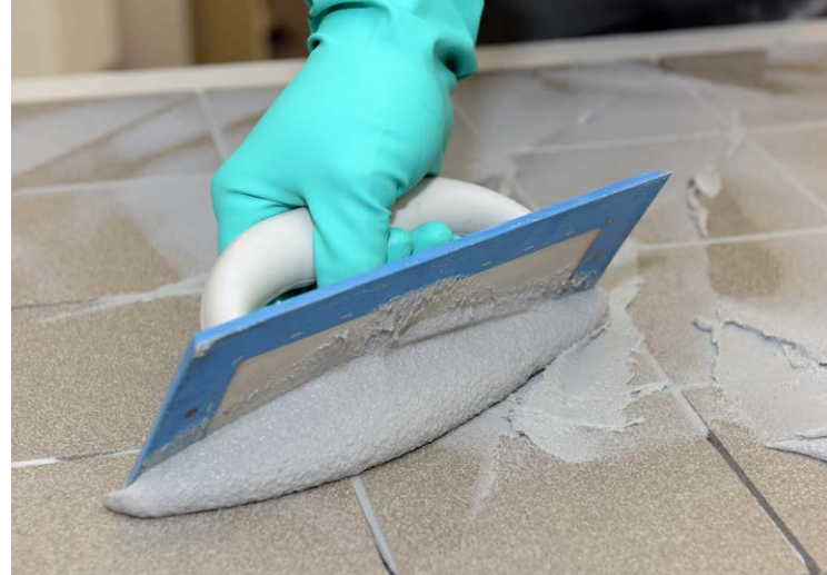
Verarbeitung von Epoxidharzfugenmörtel mit Spezialwerkzeug.
