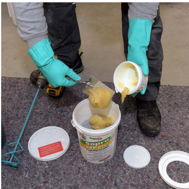
Anmischen von Sopro FugenEpoxi plus, anschließend muss umgetopft werden.
