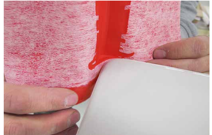
Die elastische Zone der Sopro WannenDichtEcke schmiegt sich an alle Wannenradien an.
