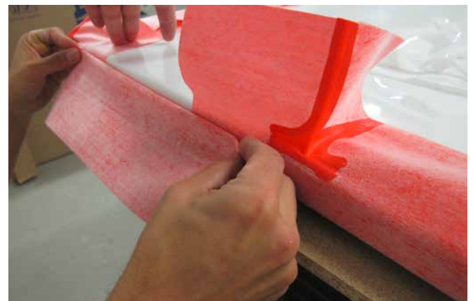
Mit der WannenDicht-Multiecke lassen sich auch die schwierigsten Einbausituationen lösen.
