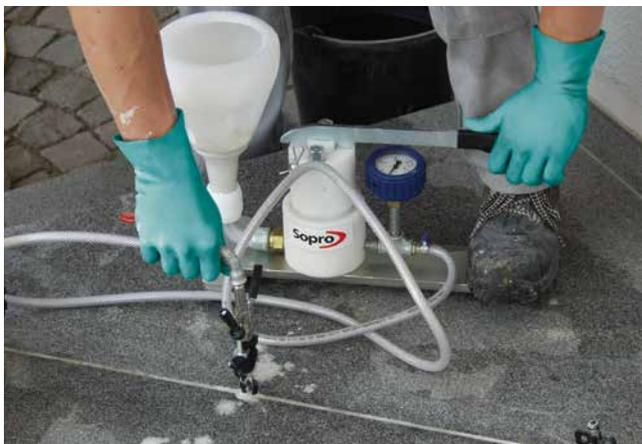
Verpressung mit Injektionspresse (15 bar).
