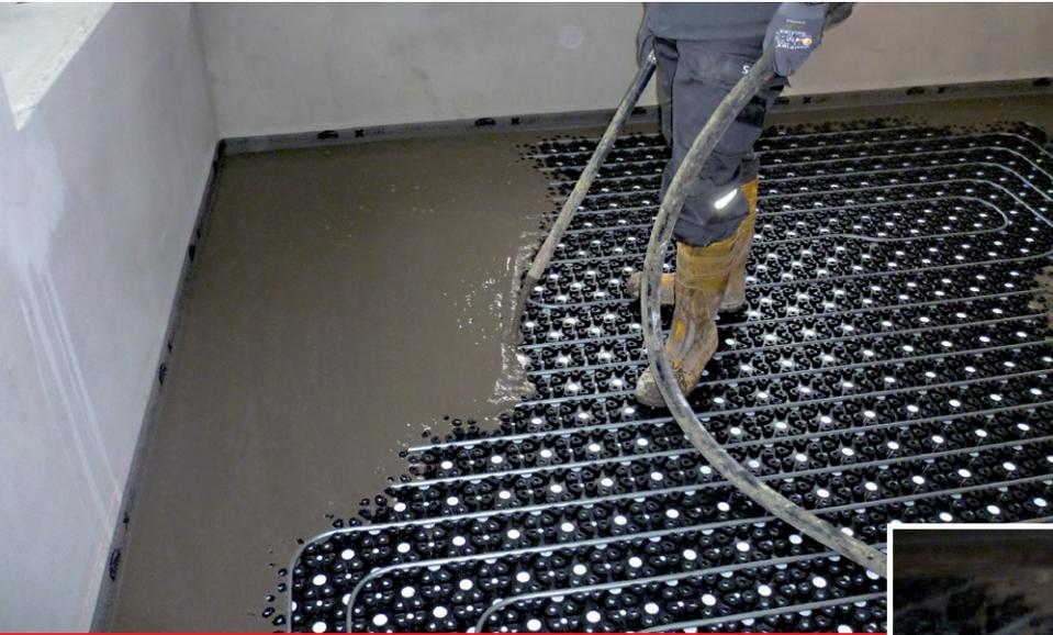
Einbau des Sopro FaserFließspachtel FAS 551 mit einer Pumpe.
