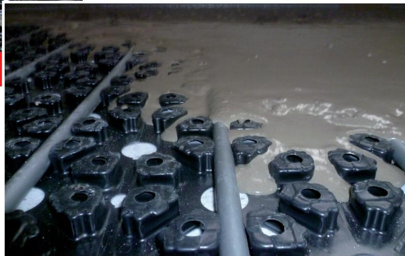
Der Sopro FaserFließspachtel FAS 551 fließt in das Kermi x-net C15 Dünnschichtsystem ein.
