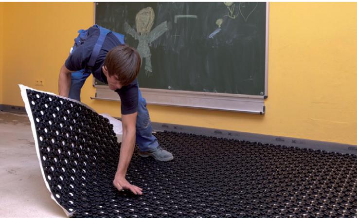
Verlegung des Kermi x-net C15 Dünnschichtsystems.
