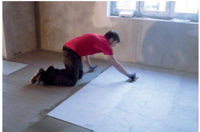
Verklebung der Sopro FliesenDämmplatte FDP 558 mit Sopro's No.1.
