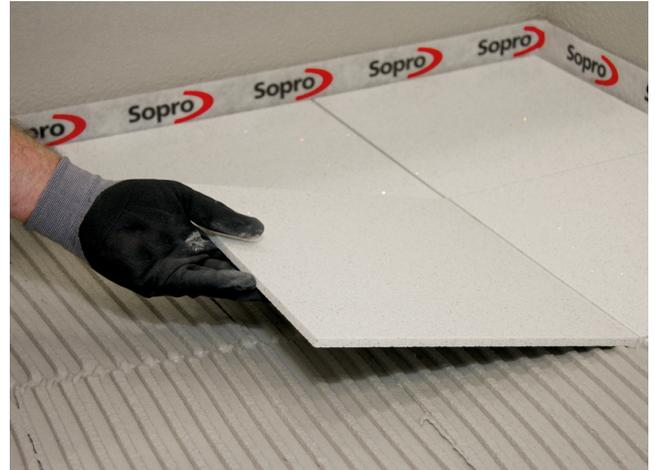
Einlegen einer Aggloplatte. Aufgrund der Schnellerhärtung eignet sich Sopro FKM® Silver auch für die Verlegung verformungsempfindlicher Beläge.
