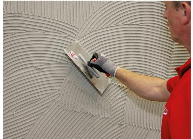
Aufziehen der Kontaktschicht und des Kammbetts in der Dünnbettkonsistenz.
