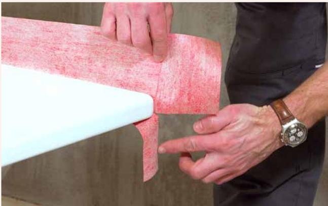
**3** Das Sopro WannendichtBand ist am Wannenende durch das Ankleben eines um 90° gedrehten, ca. 14–16 cm langen, Streifens über den Wannenrand hinaus zu verlängern. Verlängerung im Anschluss einschneiden.
