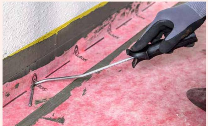
**6** Einlegen des Sopro AEB® Dichtband zur Abdichtung des Sockelbereichs. Das AEB® Dichtband wird dann nach außen hin geglättet.
