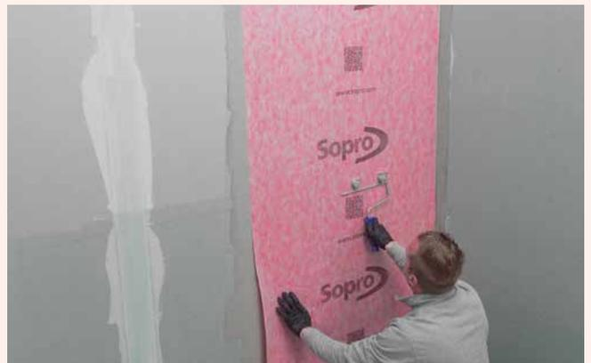
**4** Die passgenau zugeschnittene Sopro AEB® Abdichtungs- und EntkopplungsBahn in die frische Klebeschicht einlegen und von der Mitte her fest andrücken.
