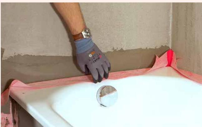
**5** Alle Bänder und Formteile in einer Schicht aus Flüssigabdichtung oder Montagekleber vollflächig ankleben. Alle Überlappungen wasserdicht verkleben. Mit Kelle oder Farbrollen-Bügel alle Teile fest andrücken.
