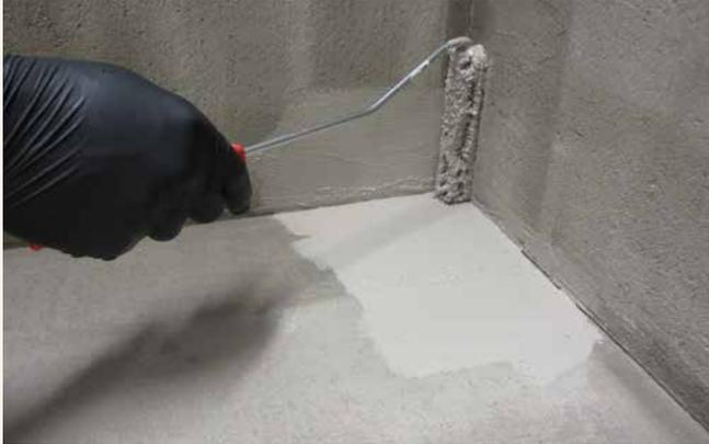
**1** Zunächst im Eckbereich und im Anschlussbereich von Boden- und Wandfläche Sopro Fixier- und DichtKleber oder einen anderen im System geprüften Formteilkleber auftragen.
