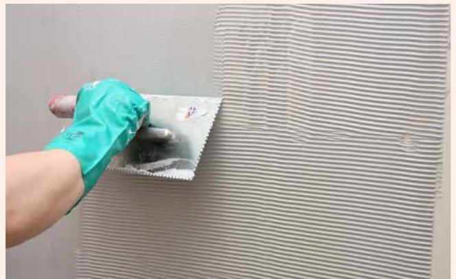
4 Der Auftrag der zweiten Abdichtungsschicht erfolgt analog zur ersten Schicht durch Aufzahnern und Umlegen der Kammstege.
