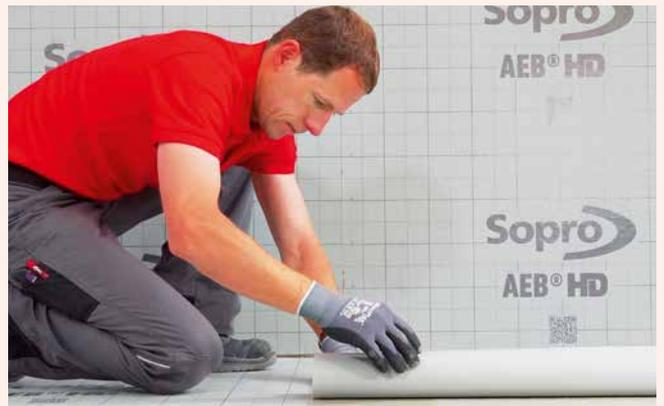
**4** Sofern mit chemischer Beanspruchung zu rechnen ist, werden die Abdichtungsbahnen stumpf gestoßen und mit Sopro AEB® HD Dichtband und Sopro PU-FlächenDicht Wand überarbeitet.
