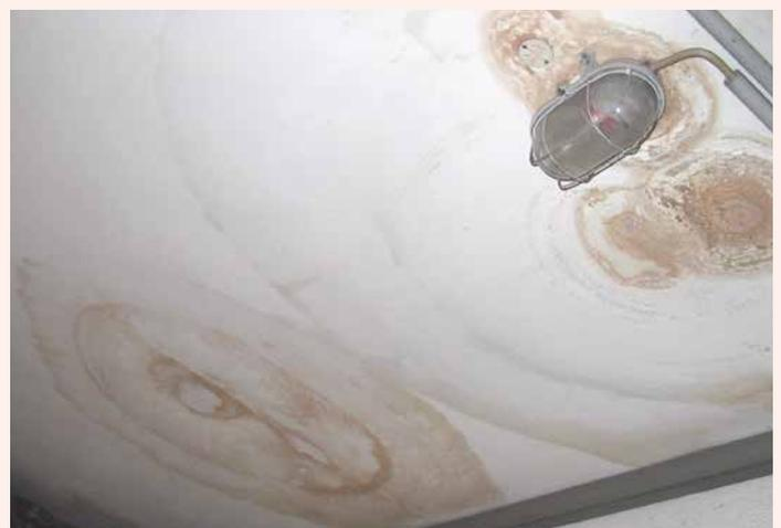
Feuchtigkeitsschaden an der Decke unter schadhafter Abdichtung.
