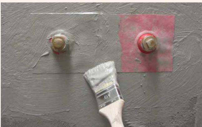
**5** Beim darauffolgenden Abdichten der Flächen werden die Bänder und Formteile mit Sopro FlächenDicht flexibel komplett in zwei Schichten überarbeitet.
