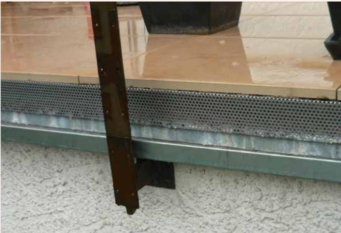
Ausblühungen aus einem nassen Estrich aufgrund fehlerhafter Balkonabdichtung.
