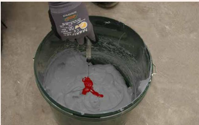
3 Nach 8–24 Stunden die zweite Abdichtungsschicht aufbringen. Zur besseren Unterscheidbarkeit kann die zweite Abdichtungsschicht mit Sopro PU-FlächenDicht KontrastFarbe eingefärbt werden.
