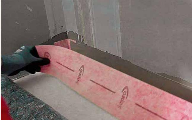
**1** Im Bereich von Innen- und Außenecken die reaktive Sopro DichtSchlämme Flex RS aufbringen. Sopro AEB® Dicht-ecken und Sopro AEB® Dichtband Flex (mit Falz) in das Klebebett mittig einlegen und fest andrücken.
