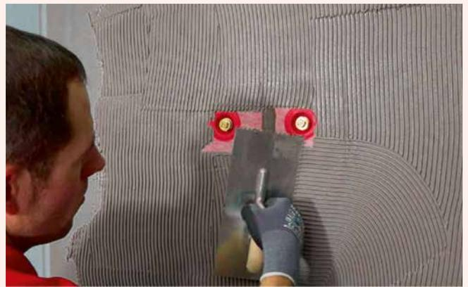
**4** Beim darauffolgenden Abdichten der Flächen werden die Bänder und Formteile mit Sopro DichtSchlämme Flex RS komplett zweischichtig überarbeitet.
