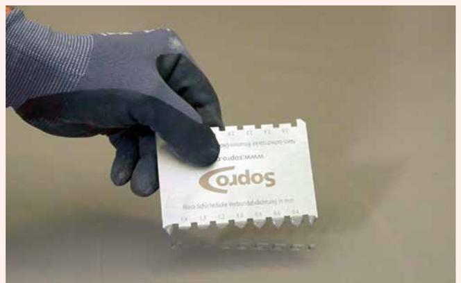
**6** Um später eine ausreichende Trockenschichtdicke von 2 mm zu gewährleisten, kann die Nass-Schichtdicke mit Hilfe eines Schichtdickenmesskamm überprüft werden.
