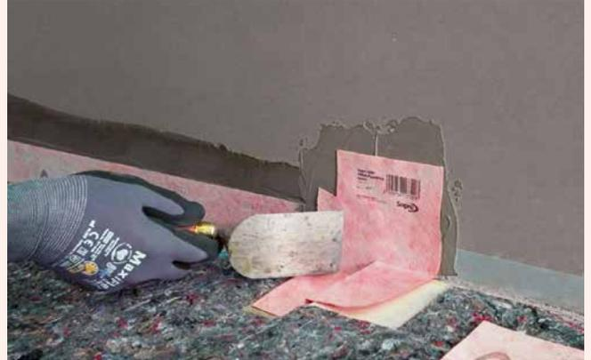
**2** Höhenunterschiede, z.B. bei bodengleichen Duschen, können mit den Sopro AEB® Höhen-Pass-Stücken abgedichtet werden. Diese werden ebenfalls in ein Klebebett aus Sopro DichtSchlämme Flex RS eingebettet.
