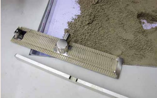
1 Die mit einem Fliesenkleber (z. B. Sopro's No. 1 als Haftbrücke) rückseitig abgespachtelte Rinne wird in den frischen Estrichmörtel aus Sopro Rapidur® M1 oder Sopro Rapidur® M5 eingearbeitet.
