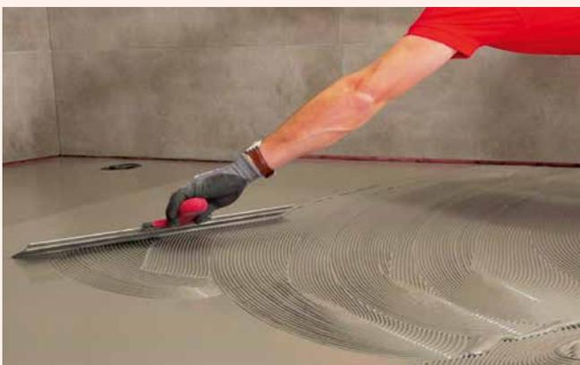
**5** Der Auftrag der Flächenabdichtung erfolgt durch Aufzählen und Umlegen der Kammstege. Nach ausreichender Trocknungszeit kann die zweite Schicht aufgetragen werden.
