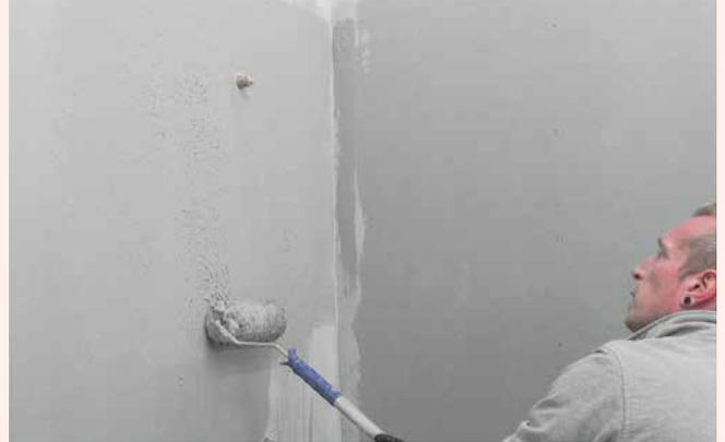
**2** Für schnelle Arbeitsfortschritte beim Auftrag eine Lammfellrolle verwenden. Sopro Fixier- & DichtKleber vollflächig aufrollen. Für ein gleichmäßig deckendes Ergebnis den Kleber im Kreuzgang auftragen.
