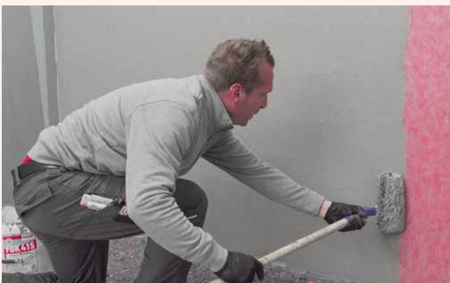
**5** Die Überlappungen der Sopro Abdichtungs- und Entkopplungs- Bahn ca. 5 cm mit Sopro Fixier- & DichtKleber überarbeiten. Die Abschlüsse der Sopro AEB® Abdichtungs- und Entkopplungs- Bahn ebenfalls mit Sopro Fixier- & DichtKleber überarbeiten.
