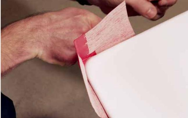
**1** Wannenrand mit einem geeigneten Reiniger von Verunreinigungen, Fetten und haftungsmindernden Substanzen befreien. Sopro WannendichtEcke ausrichten, ankleben und festdrücken.
