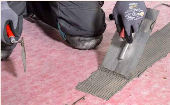
**3** Im Stoßbereich wird z.B. Sopro TurboDichtSchlämme 2-K auf die Sopro AEB® plus aufgetragen und mit einem feingezahnten Spachtel aufgekämmt (Alternativ Sopro Fixier- und DichtKleber aufrollen).
