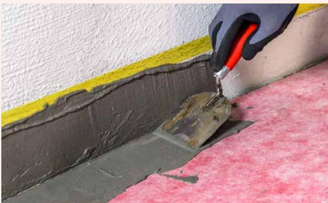
**5** Der Sockelbereich wird mit flexiblem Sopro Dünnbettmörtel aufgespachtelt. Der angrenzende Bereich mit Sopro TurboDichtSchlämme 2-K aufgezehnt (Alternativ Sopro Fixier- und DichtKleber aufrollen).
