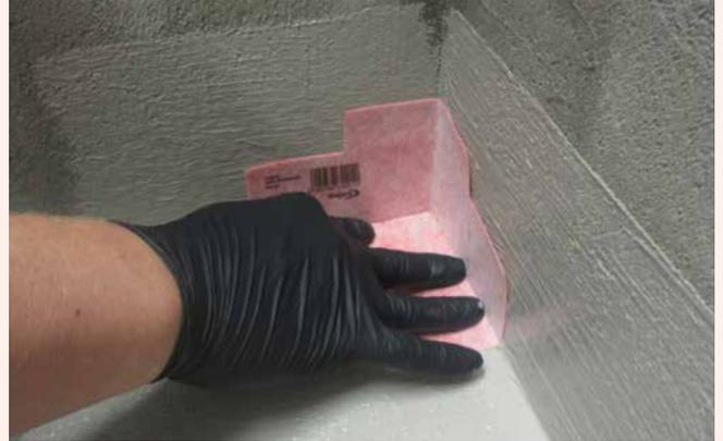
**2** Im Bereich von Innen- bzw. Außenecken die vorgeformten Sopro AEB® Dichtecken einlegen. Verklebung der Überlappungen der Bänder und Formteile mit Sopro Fixier- und DichtKleber oder einem anderen im System geprüften Stoß- und Überlappungskleber durchführen.
