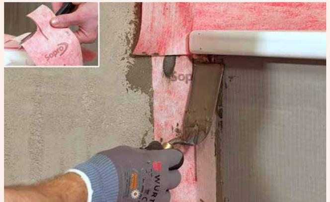
**4** Senkrecht vom Boden kommendes Sopro AEB® Dichtband Flex (oder Dichtband Flex mit Falz) mit einer runden Aussparung am oberen Ende versehen. Dieses an der Wannendichtband-Verlängerung überlappend ansetzen und verkleben.
