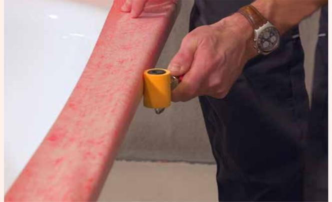
**2** Das Sopro WannendichtBand wird auf die Abmessungen der Badewanne zurecht geschnitten. Eine Überlappung der Bänder und Formteile von mindestens 50 mm ist mit einzuberechnen. Bänder unbedingt spannungsfrei ankleben.
