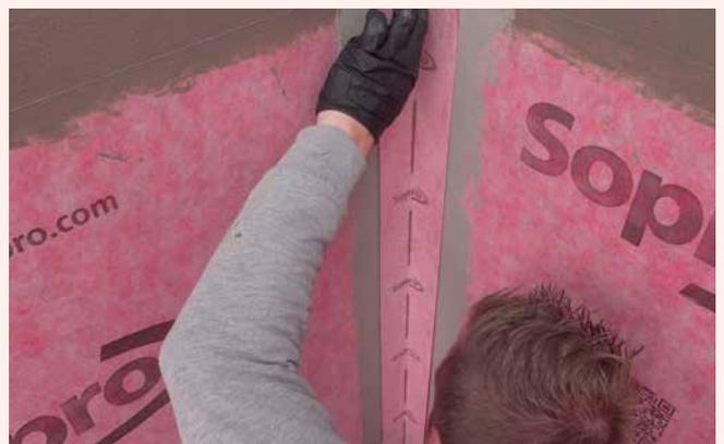
**6** Stoßbereiche der Sopro AEB® Abdichtungs- und EntkopplungsBahn werden mit Sopro einem AEB® Dichtband überarbeitet. Das passgenau zugeschnittene Sopro AEB® Dichtband in die frische Klebeschicht einlegen und fest andrücken.
