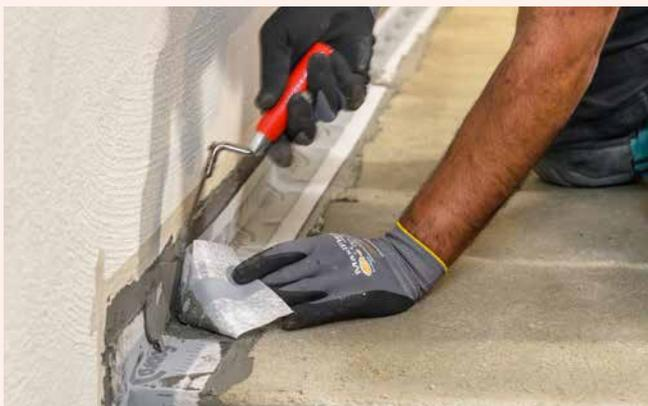
**3** ... des anschließend einzulegenden Sopro Dichtband/ Sopro Dichtband mit Falz, das zusätzlich fest anzudrücken ist.
