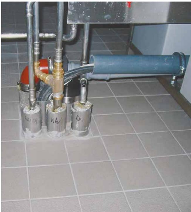
Hüllrohre (Sonderanfertigung) zur Durchführung von Versorgungsleitungen
