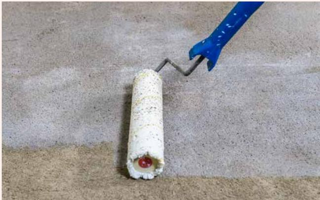
**1** Vornässen bzw. Grundieren des Untergrunds für den nachfolgenden Auftrag einer flexiblen Sopro Dichtschlämme (z. B. Sopro TurboDichtSchlämme 2-K).
