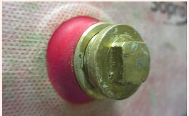
**4** Sopro AEB® Wandmanschetten über die Rohrstutzen stülpen. Die flexiblen Dichtlippen der Sopro Wandmanschetten legen sich dicht an.
