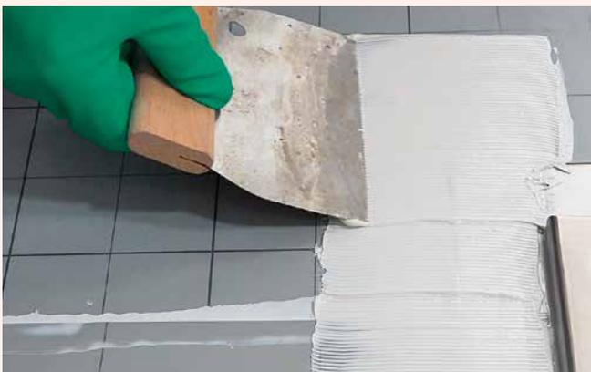
**5** Der chemisch beständige Stoß- und Überlappungskleber Sopro PU-FlächenDicht Wand wird dabei fein aufgezhant...
