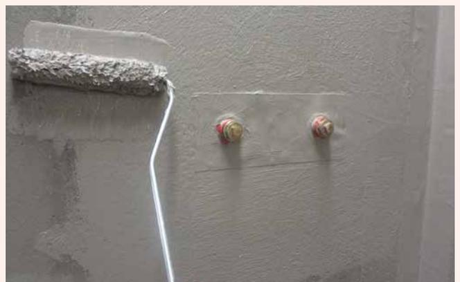
**6** Sopro FlächenDicht flexibel satt auftragen. Der Auftrag der zweiten Schicht erfolgt nach ausreichender Festigkeit der ersten Schicht in einer Kontrastfarbe.
