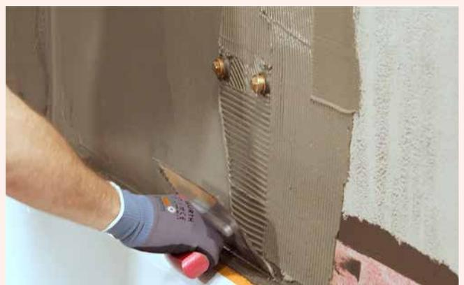
**6** Bänder und Formteile vollflächig überarbeiten. Alle Übergänge der Bänder und Formteile zur Wanne mit einem Pinsel sorgfältig überarbeiten.
