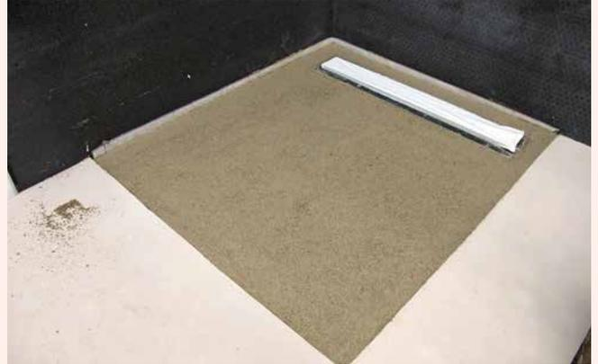
2 In den Estrichmörtel aus Sopro Rapidur® M1 oder Sopro Rapidur® M5 fertig eingebaute Rinne.
