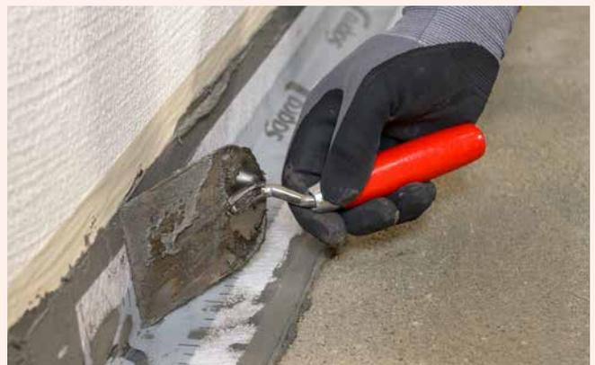
**4** Überarbeiten des Sopro Dichtband/Sopro Dichtband mit Falz mit einer flexiblen Sopro Dichtschlämme (z. B. Sopro TurboDichtSchlämme 2-K).
