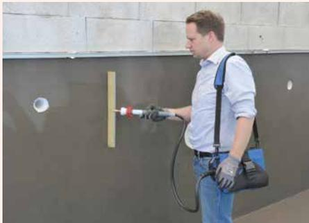
**1** Die Abdichtungsschicht wird mit einem elektrischen Streustrombesen abgefahren.
