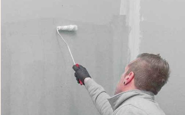
**1** Saugende Untergründe mit Sopro Grundierung vorbehandeln. Bei Verwendung des Sopro Fixier- und DichtKleber die Flüssigkomponente B vorgeben und mit der gesamten Menge der Pulverkomponente A maschinell klumpenfrei anmischen.
