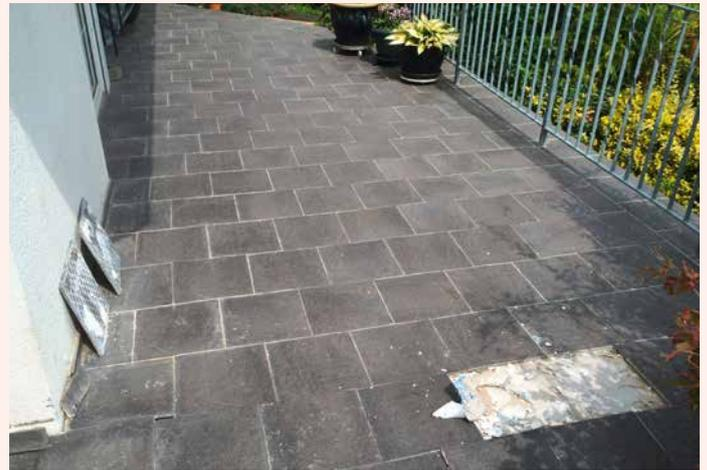
Beschädigter Fliesenbelag aufgrund fehlerhafter Balkonkonstruktion.
