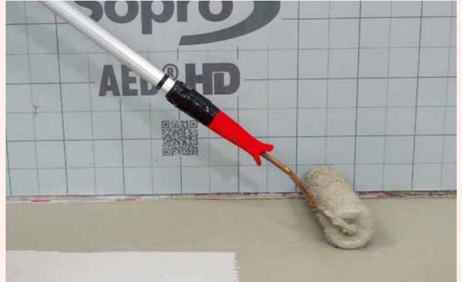
**2** Zur Fixierung der Bahnen Sopro Fixier- und Dichtkleber vollflächig und deckend mittels einer Lammfellrolle auftragen. Für ein gleichmäßig deckendes Ergebnis den Kleber im Kreuzgang auftragen.
