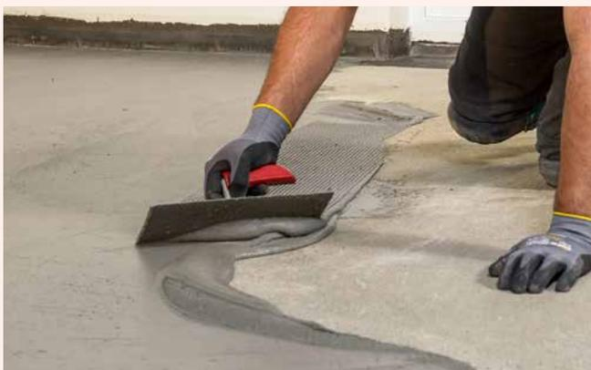
**5** Die erste Abdichtungsschicht wird gespachtelt oder mit der Lammfellrolle aufgetragen, wobei das Sopro Dichtband nahtlos in die Abdichtung eingebunden wird.
