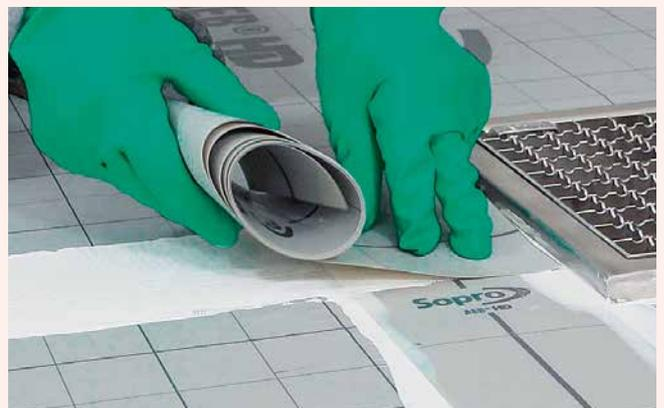
**6** ... und das Sopro AEB® HD Dichtband vollflächig den Kleber eingelegt und andrückt. Dichtbänder und Formteile sind mind. 5 cm überlappend zu verkleben.
