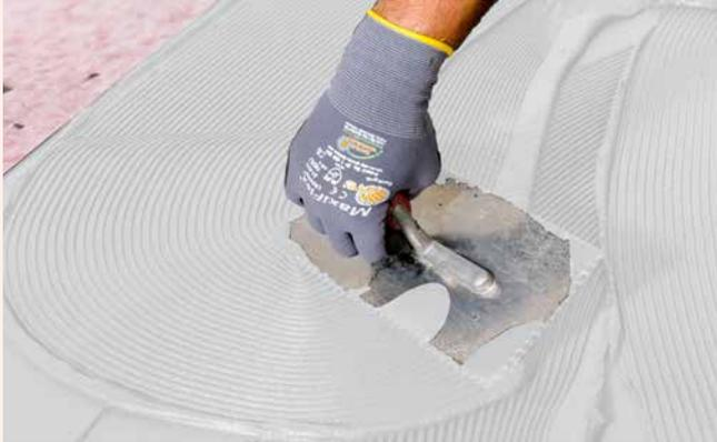
**1** Zunächst wird ein flexibler Sopro Fließbettmörtel (z. B. Sopro megaFlex turbo Silver) auf die mit Gefälle vorbereitete Fläche aufgezogen (Alternativ Sopro Fixier- und DichtKleber aufrollen).
