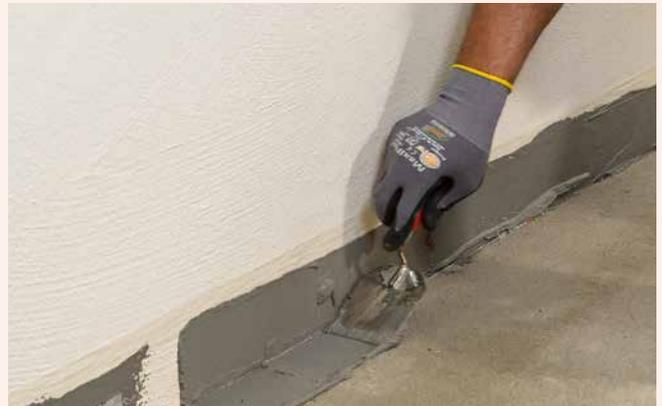
**2** Einstreichen des Sockelbereichs mit einer flexiblen Sopro Dichtschlämme (z. B. Sopro TurboDichtSchlämme 2-K) zur Fixierung ...
