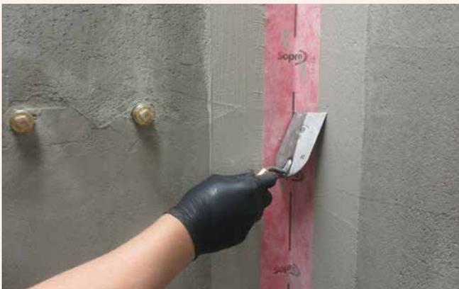
**3** In Eckbereichen bzw. dem Anschlussbereich von Boden- und Wandflächen Sopro AEB® Dichtbänder in das zuvor aufgekämmte/aufgerollte Klebebett einlegen.
