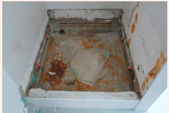
Beschädigte Verbundabdichtung im Duschbereich durch fehlerhafte Abdichtung.
