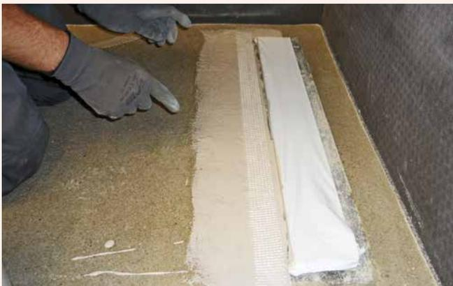
3 Eindichten des Rinnenkörpers mit Sopro DichtSchlämme Flex 1-K. Der Übergang wird durch Einlegen eines Armierungsgewebestreifens in die Verbundabdichtung verstärkt.
