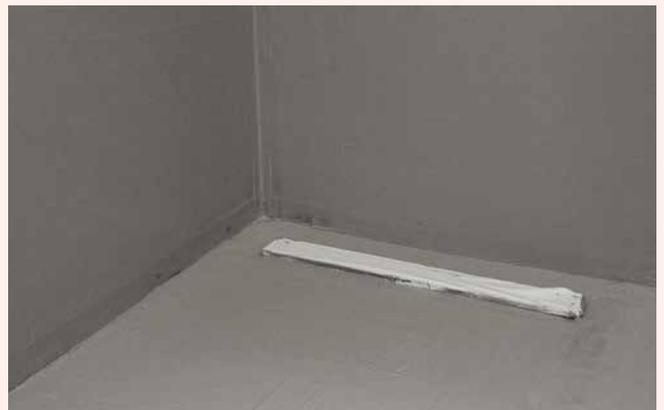
4 Komplett abgedichtete Duschecke in zwei Arbeitsgängen (Wand- und Bodenfläche) mit Sopro DichtSchlämme Flex 1-K, bereit für die folgende Fliesenverlegung.
