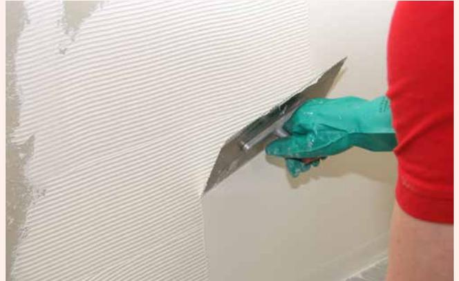
2 Sopro PU-FlächenDicht Wand aufzahnern und anschließend die Kammstege umlegen. Erforderliche Nass-Schichtdicke pro Abdichtungsschicht: 0,6 mm.
