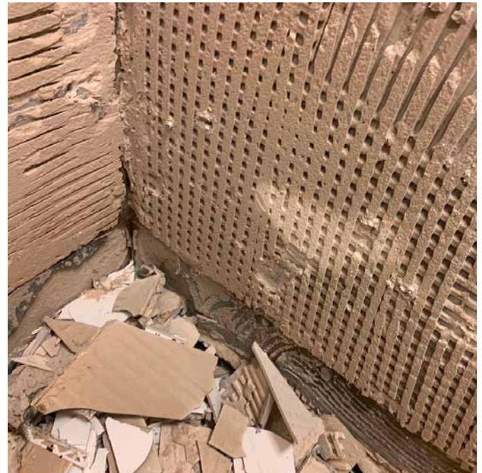
Hier wurde das Buttering-Floating-Verfahren angewendet. Allerdings entstanden viele Hohlräume, da die Kleberstege auf Untergrund und Plattenrückseite nicht parallel zueinander liegen.
