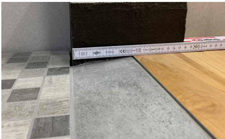
Eine fertige Schwelle im Durchgang zwischen Badboden und trockenem Flurbereich
