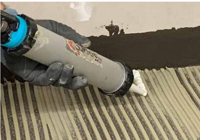
Erstellung einer Kapillarsperre mit Sopro Racofix® Montagekleber RMK 818
