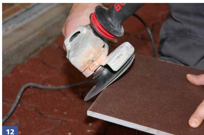
12 Sichtkanten/scharfkantige Kanten mit Diamant-Pad oder Schleifscheibe bearbeiten.
