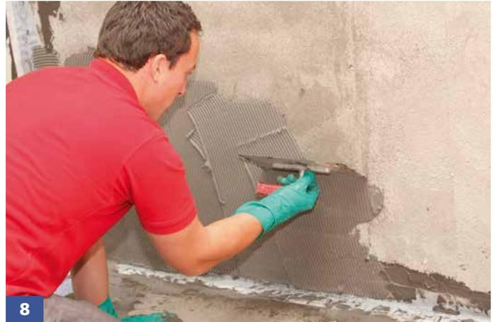
Zur flächigen Abdichtung, die Dichtschlämme mit einer 4 mm Zahnung aufziehen ...
