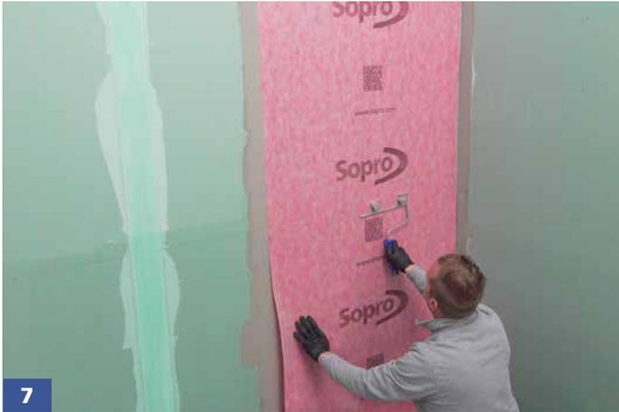
**7** Die passgenau zugeschnittene Sopro AEB® Abdichtungs- und Entkopplungsbahn in die frische Klebeschicht einlegen und von der Mitte her fest andrücken.
