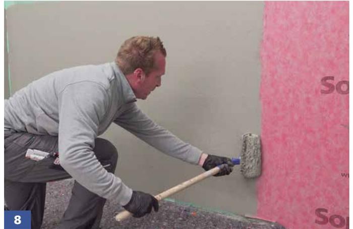
**8** Die Überlappungen der Sopro Abdichtungs- und Entkopplungsbahn ca. 6 cm mit Sopro Fixier- & Dichtkleber 2-K überarbeiten.
