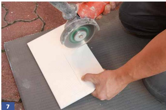
7 ... und mittels Winkelschleifer zuschneiden.
