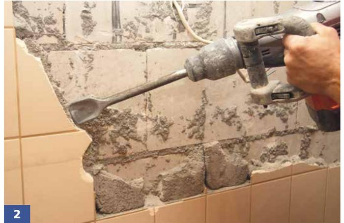
... oder maschinell mittels Bohrhammer und entsprechendem Meißel-Aufsatz abschlagen.
