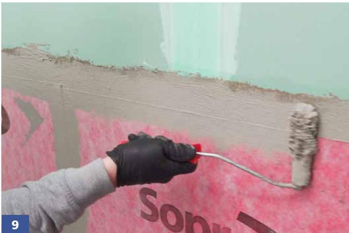
**9** Die Abschlüsse der Sopro AEB® Abdichtungs- und Entkopplungsbahn mit Sopro Fixier- & Dichtkleber 2-K überarbeiten.
