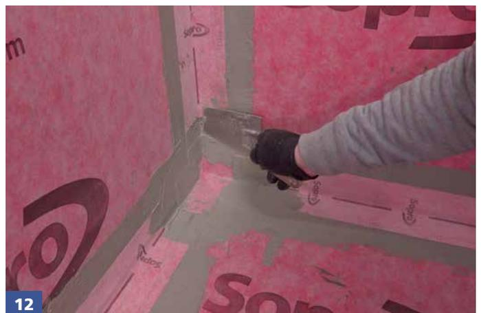
**12** Die Abschlüsse des AEB® Dichtband Flex werden im Anschluss ebenfalls mit Sopro Fixier- & Dichtkleber 2-K überarbeitet.
