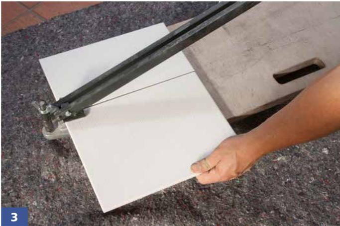
**3** Die Fliese an der Brechvorrichtung anlegen und durch Druck auf den Hebel entlang des Ritzes brechen.
