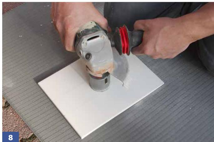
8 Durchdringungen (z. B. für Anschlüsse von Armaturen) können mittels Diamantbohrkronen hergestellt werden.
