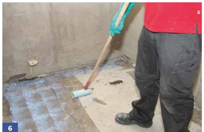
Auch saugfähige Bodenflächen (z. B. Zementestriche) werden mit Sopro Grundierung vorbehandelt.
