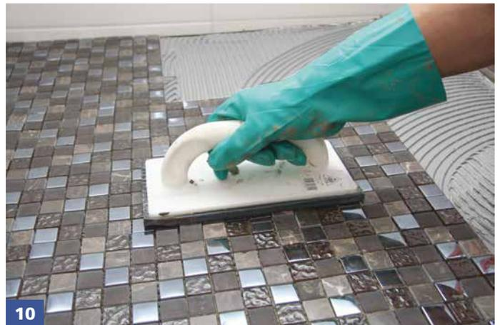
10 Um bei der Mosaikverlegung eine gleichmäßige Oberfläche zu erhalten, das Mosaik gleichmäßig mittels Anklopfbrett andrücken.
