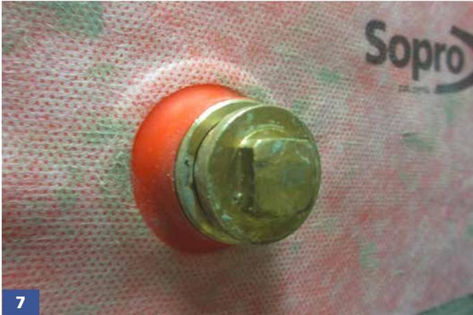
Durchdringungen im Wandbereich werden mit Sopro Wandmanschetten mit flexibler Dehnzone abgedichtet.
