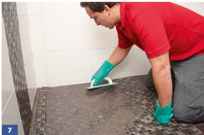
Den Fugenmörtel mit einer geeigneten Fugscheibe diagonal zum Fugenverlauf einbringen.
