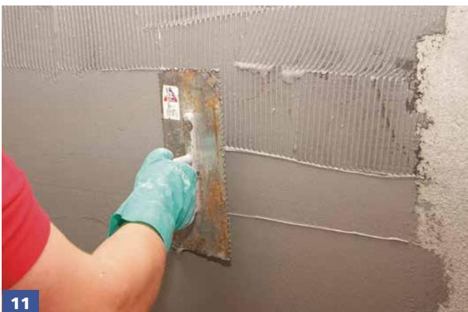
Nach Trocknung wird die zweite Abdichtungsschicht aufgebracht. Die Dichtschlämme mit der Zahnung aufziehen, anschließend die Kammstege umlegen.
