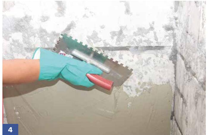
4 Mit der glatten Seite der Kelle zunächst unter Druck eine Kontaktschicht aufziehen ...
