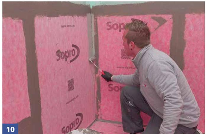
**10** Stoßbereiche der Sopro AEB® Abdichtungs- und Entkopplungsbahn werden mit Sopro AEB® Dichtband Flex überarbeitet.
