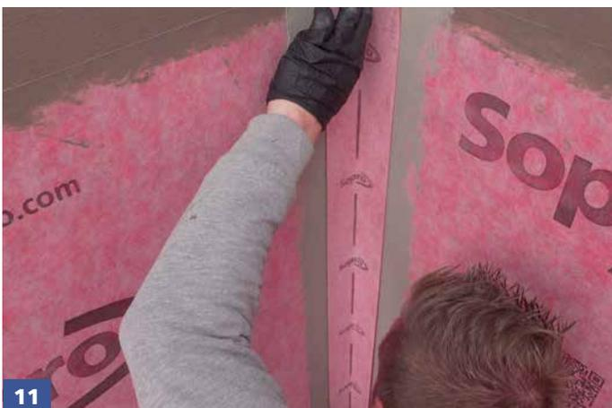
**11** Das passgenau zugeschnittene Sopro AEB® Dichtband Flex in die frische Klebeschicht einlegen und fest andrücken.
