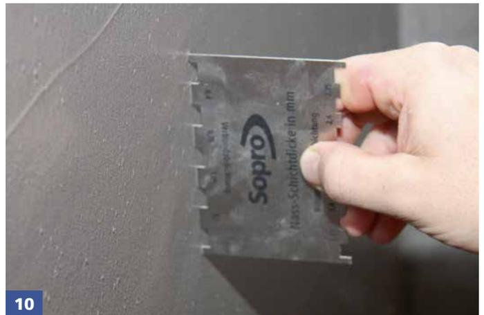
Prüfung der Nass-Schichtdicke: erforderliche Nass-Schichtdicke siehe Technische Produktinformation des verwendeten Abdichtungsstoffs.
