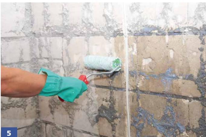
Die Grundierung mittels Rolle, Pinsel oder Quast auf den saugfähigen Untergrund (z. B. Mauerwerk) auftragen.
