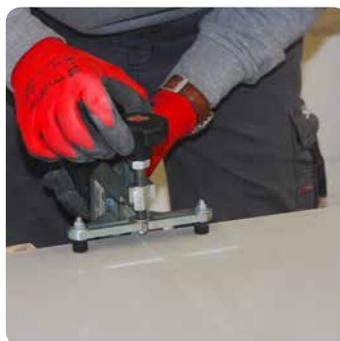
Anbringung der Brechvorrichtung an einer Großformatfliese
