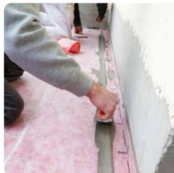
Verkleben des Abdichtungsbandes mit TurboDichtSchlämme 2-K
