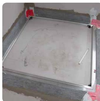
Eingedichtete Dichtbänder im Bereich der Duschecke
