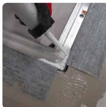
Eindichten der WannenDichtBand-Komponenten
