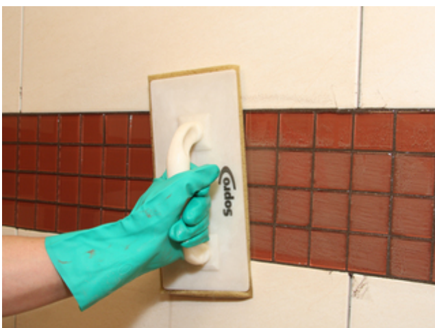
5 Abwaschen des Glasmosaiks nach ausreichender Standzeit des Fugenmörtels.
