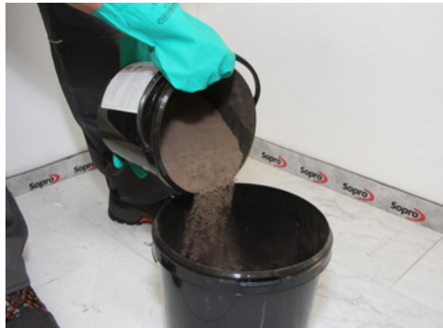
2 Sopro DF 10 zudosieren und maschinell anrühren.
