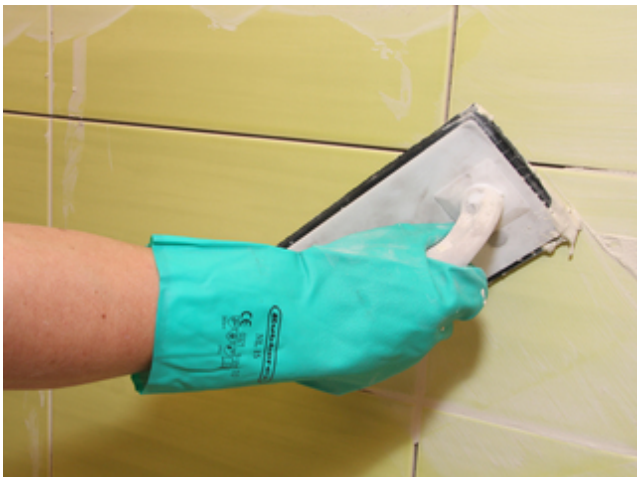
9 Einfugen von Sopro DF 10 in Steingutfliesen.
