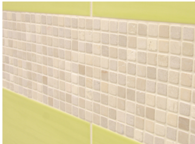
10 Steingut- und Natursteinmosaikflächen verfugt mit Sopro DF 10.
