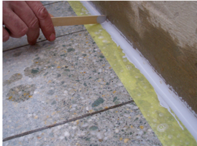
4 Die mit Sopro Glättmittel eingesprühte, offene Fuge mit entsprechendem Glättwerkzeug abziehen.
