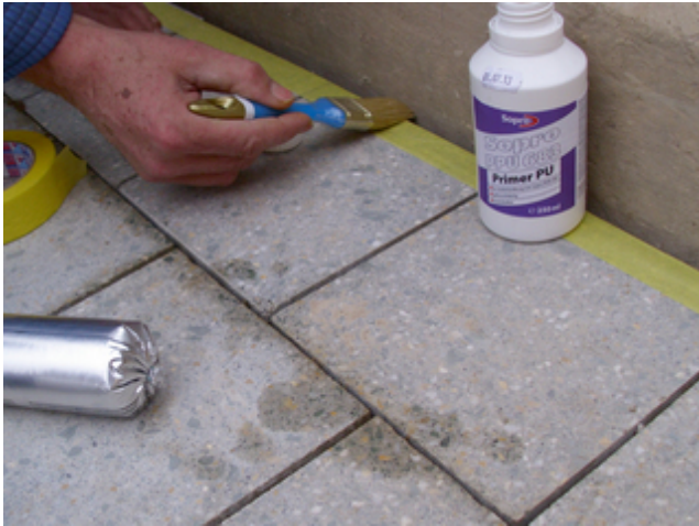
1 Die zuvor mit Klebeband abgeklebte Fuge wird mit Sopro Primer PU eingestrichen
