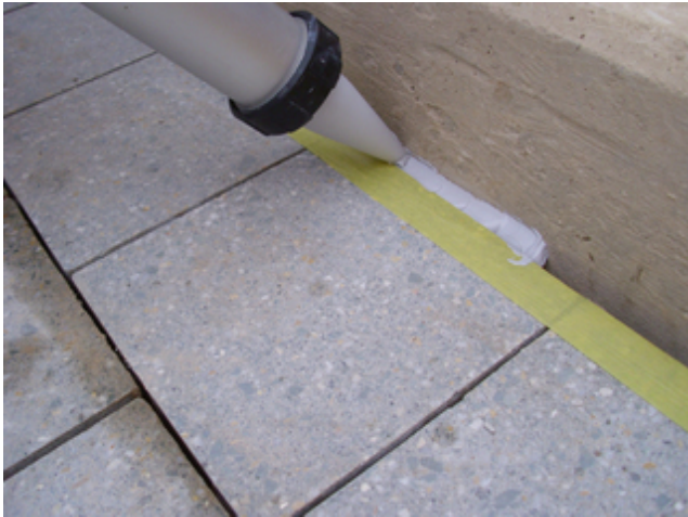
3 Hohlraumfreies und blasenfreies Einbringen des Sopro PU-Dichtstoffes mit einer Schlauchspritzpistole.
