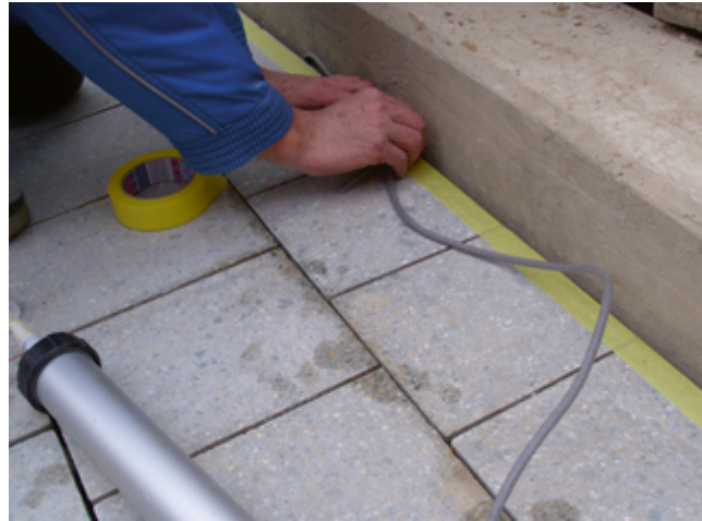
2 Einlegen einer PE-Rundschnur nach Trocknung des Sopro Primer PU.
