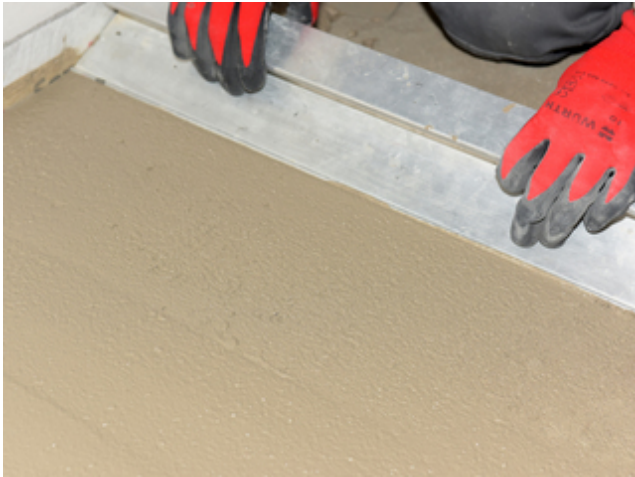
3. Selbstheilungseffekt durch selbstständiges Verdichten des Materials.
