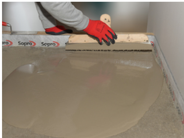
2. Leichtgängiges Verteilen der Fließspachtelmasse. Unmittelbar anschließendes Entlüften mit einer Stachelwalze ist erforderlich.
