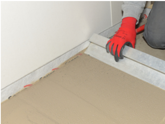
3. Herstellen eines Gefälles durch Abziehen mit der Latte.
