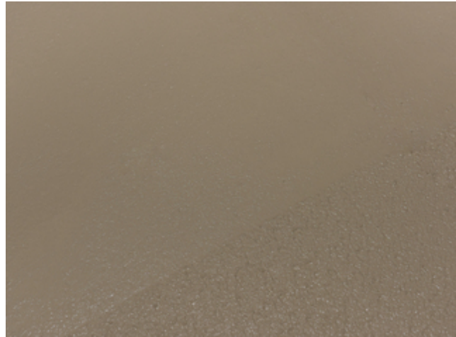
4. Somit werden Kellenschläge und Lunker vermieden.
