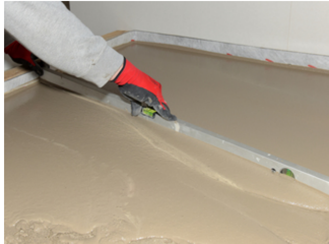
2. Herstellung eines Gefälles durch Ausbreiten mit der Abziehlatte.
