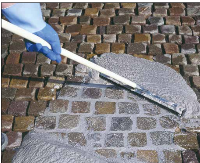
5 Fugenfüllendes Einbringen von Sopro EpoxiPflaster-Fuge 2-K.
