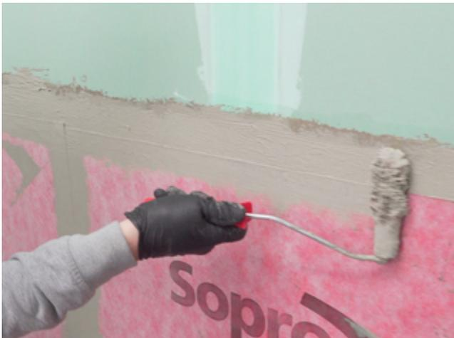
9) Die Abschlüsse der Sopro AEB® Abdichtungs- und Entkopplungsbahn mit Sopro DichtSchlämme Flex RS überarbeiten.
