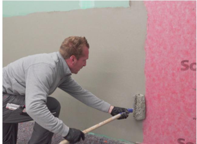
8) Die Überlappungen der Sopro Abdichtungs- und Entkopplungsbahn ca. 5 cm mit Sopro DichtSchlämme Flex RS überarbeiten.
