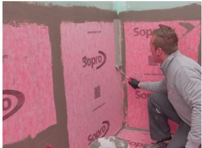
10) Stoßbereiche der Sopro AEB® Abdichtungs- und Entkopplungsbahn werden mit Sopro AEB® Dichtband Flex überarbeitet.
