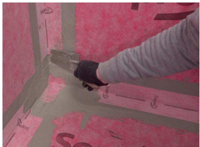
12) Abschlüsse des AEB® Dichtband werden im Anschluss mit Sopro DichtSchlämme Flex RS überarbeitet.
