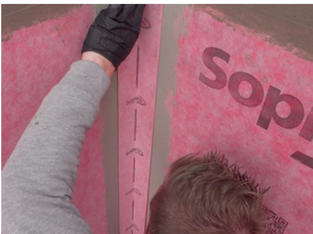
11) Das passgenau zugeschnittene Sopro AEB® Dichtband in die frische Klebeschicht einlegen und fest andrücken.
