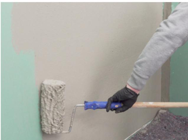
5) Für ein gleichmäßig deckendes Ergebnis Sopro DichtSchlämme Flex RS im Kreuzgang auftragen.
