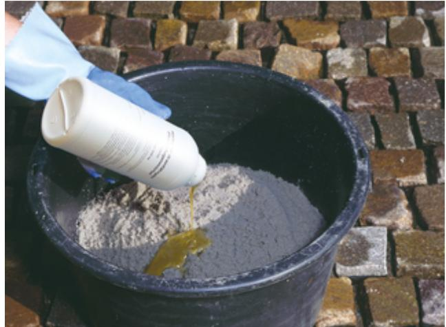
2. Härterzugabe und Anrühren von Sopro EpoxiPflasterFuge 2-K.
