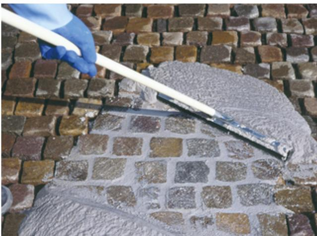
5. Fugenfüllendes Einbringen von Sopro EpoxiPflasterFuge 2-K.
