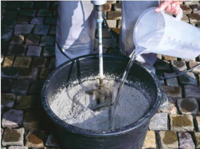
3. Nach dem Anrühren von Sopro EpoxiPflasterFuge 2-K ca. 2 l Wasser zugeben und erneut anrühren.
