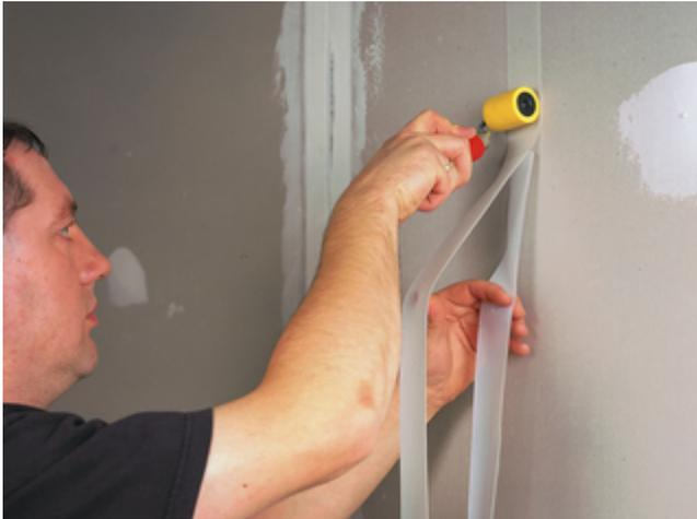
1) Sopro Fixier-Band wird auf der mit Sopro Grundierung vorbehandelten Fläche angebracht.
