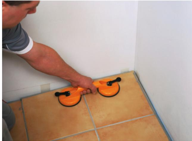
4) Nach Entfernen der Sockelleisten wird der Fliesenbelag, hier beginnend im Eckbereich, mittels eines Sauggriffes aufgenommen.
