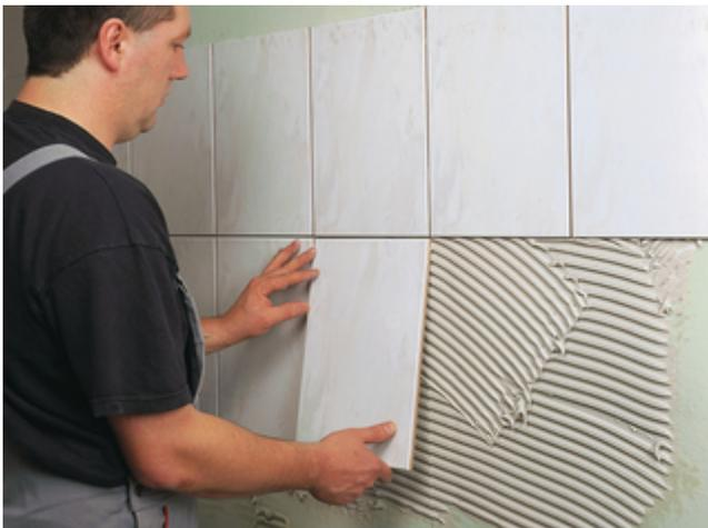
3) Die Fliesen werden in herkömmlicher Technik mit einem Sopro Fliesen-Kleber angesetzt.
