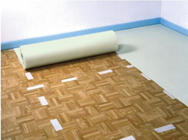
1) Das vorher zugeschnittene Sopro WE-Vlies wird in die mit Sopro Fixier-Band vorbereitete Bodenfläche eingerollt.
