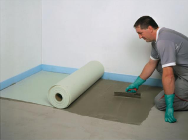
1) Das zugeschnittene Sopro WE-Vlies wird in einen schnell erhärtenden Sopro Dünnbettmörtel, z. B. Sopro's No.1 schnell, eingerollt und mit einer Glättkelle angedrückt.
