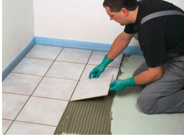
2) Nach Erhärtung des Sopro Fliesenklebers werden die Fliesen in herkömmlicher Verlegetechnik mit flexiblem Sopro Fugenmörtel verfugt.
