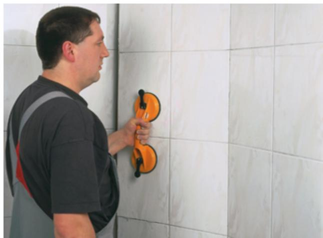
6) Nach Entfernen der Sanitäröbjekte und dem Aufschneiden der Silikonfugen wird der Fliesenbelag mittels eines Sauggriffes aufgenommen.
