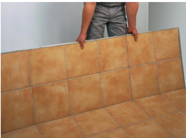
5) Beim Rückbau wird der Belag durch Umklappen in der Fuge gebrochen und kann durch Einschneiden des WE-Vlieses auf der Rückseite einfach entfernt werden.
