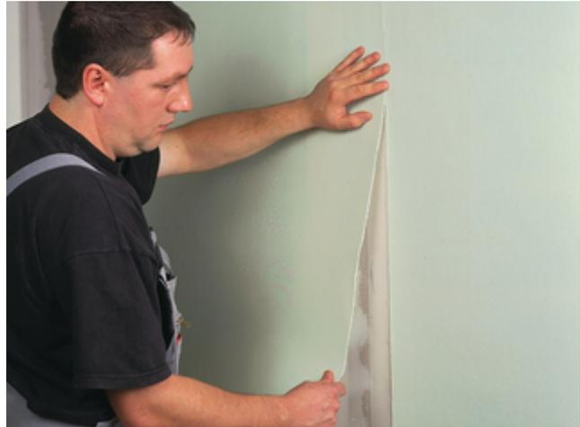
2) Das zugeschnittene Sopro WE-Vlies wird an den Stößen mittig auf dem Sopro Fixier-Band befestigt.
