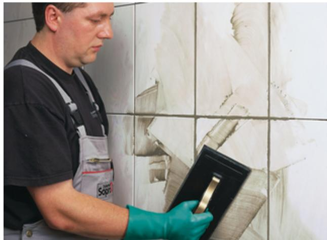
4) Anschließend wird der Belag mit einem Sopro Fugenmörtel verfugt.
