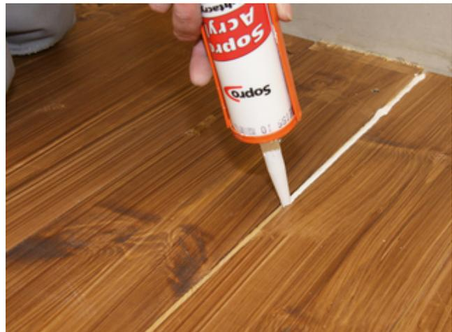
4) Damit die selbstverlaufende Spachtelmasse für die Ausgleichsarbeiten nicht in die Fugen zwischen den Holzdielen einläuft, sind die Fugen mit Sopro Dichtacryl zu schließen.
