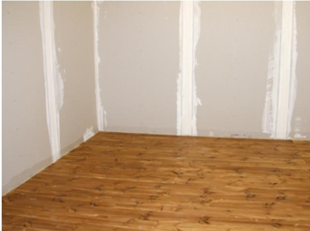
1) Holzdielenboden, der im Rahmen einer Sanierung mit einem keramischen Belag belegt werden soll.
