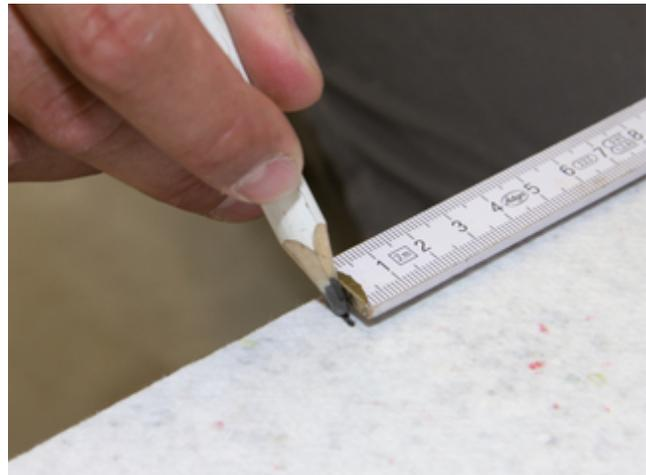
3) Anriss zum maßgenauen Schneiden einer Sopro FliesenDämmplatte.
