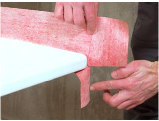
5) Das Sopro WannenDichtBand ist am Wannenende durch das Ankleben eines um 90° gedrehten, ca. 14 – 16 cm langen, Streifens über den Wannenrand hinaus zu verlängern. Verlängerung im Anschluss einschneiden.
