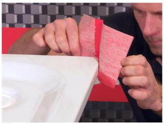
3) Nach dem Abziehen der Schutzfolie vom Klebestreifen die Sopro WannenDichtEcke am Wannenrand ausrichten, ankleben und festdrücken. Das hochflexible Formteil ist für alle gängigen Wannenradien geeignet.
