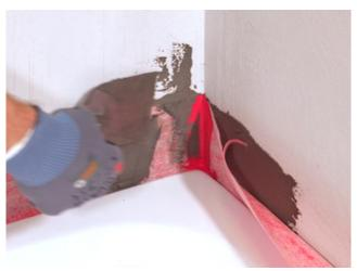
9) Bänder und Formteile in eine Schicht aus im System geprüften Stoß- und Überlappungskleber vollflächig einlegen. Mit Kelle oder Farbrollen- Bügel alle Teile fest andrücken.
