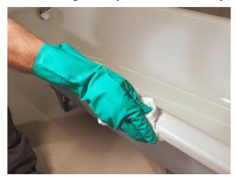
1) Wannenrand mit einem geeigneten Reiniger von Verunreinigungen, Fetten und haftungsmindernden Substanzen befreien. Danach ablüften lassen. Die Reiniger dürfen keinen trennend wirkenden Film hinterlassen!
