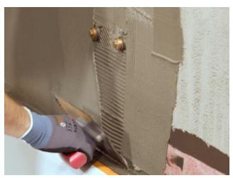
10) Vor dem Aufbringen jeder Lage Flächenabdichtung den Wannenrand mit Kreppband abkleben. Bänder und Formteile vollflächig überarbeiten. Vor Trocknung der jeweiligen Lage das Kreppband wieder entfernen.
