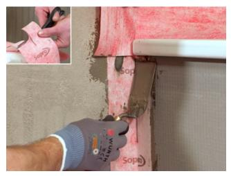
8) Senkrecht vom Boden kommendes Sopro AEB<sup>®</sup> Dichtband Flex (mit Falz) mit einer runden Aussparung am oberen Ende versehen. Dieses an der Wannendichtband-Verlängerung überlappend ansetzen und verkleben.
