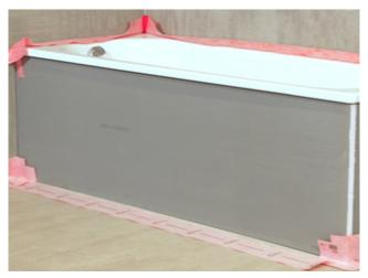
7) Im Bereich vor und über der Wanne sind Sopro AEB<sup>®</sup> Dichtband Flex (mit Falz) sowie AEB<sup>®</sup> Dichtecken zu verwenden. Alle waagerechten und senkrechten Bänder auf die richtige Länge zurecht schneiden (mind. 50 mm Überlappung)
