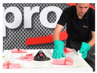
1) Wannenrand mit einem geeigneten Reiniger von Verunreinigungen, Fetten und haftungsmindernden Substanzen befreien. Danach ablüften lassen. Die Reiniger dürfen keinen trennend wirkenden Film hinterlassen!
