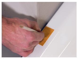
2) Zu Beginn die Duschwanne in die spätere Position einsetzen. Markierungen für die Formteile am Duschwannenrand, je nach Raumgeometrie, mit Hilfe von Kreppband und Bleistift anbringen.
