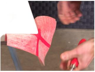
5) Treffen Duschwanne und Wand in einer Flucht aufeinander, werden zwei Multiecken an gleicher Stelle übereinander geklebt. Mit Hilfe eines Rollers können die Multiecken fest angedrückt werden.
