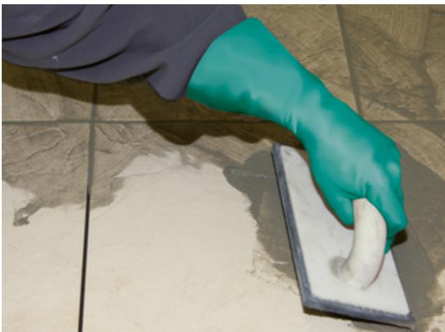
17) ... und nach Erreichen der Begeh- und Verfugbarkeit des Verlegemörtels mit z. B. Sopro DF 10® oder Sopro FlexFuge FL verfugt werden.
