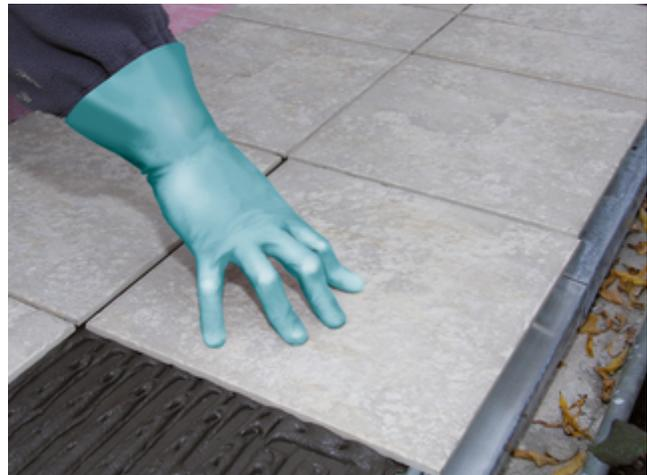
16) Keramische Fliesen können anschließend ohne lange Wartezeiten im Bodenbereich mit Sopro megaFlex S2 direkt auf Sopro AEB® plus verlegt...
