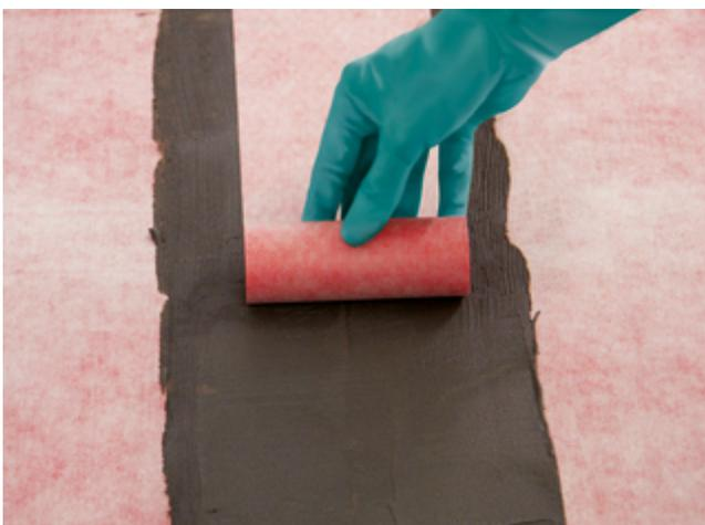
11) Alternativ kann auch DSF RS oder TDS 823 im Stoßbereich aufgetragen werden. Sopro AEB® Dichtband einlegen und den Stoßbereich überkleben.
