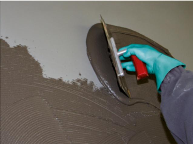
3) Aufkämmen von Sopro megaFlex S2 mit der entsprechenden Zahnkelle. (Alternativ kann zur Bahnenverklebung auch DSF RS aufgerollt werden)
