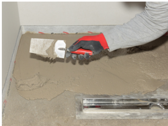
2. Herstellung eines Gefällespachtels durch Ausbreiten mit der Kelle auf der Fläche. Einbauen eines Gefälles bis max. 4 % möglich.
