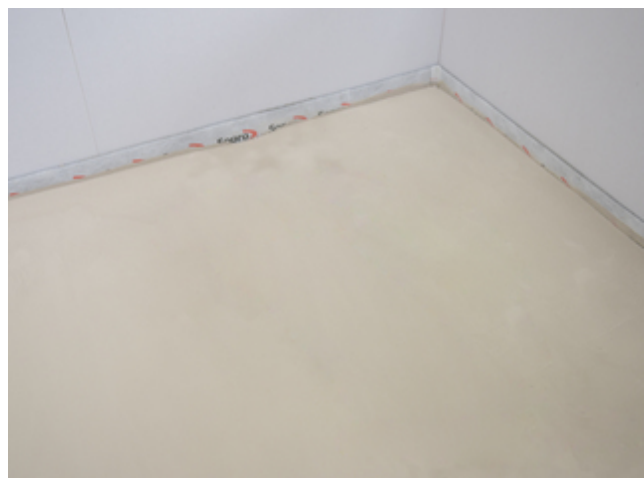
6. Sopro VS 582 im getrockneten Zustand.
