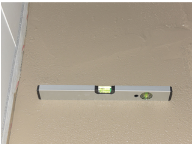
5. Gefälle mit Neigung zum Abfluss.
