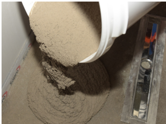
1. Ausgießen des VS 582 in standfester Konsistenz als Gefällespachtel bei mittlerer Wasserzugabe (3,75 l).
