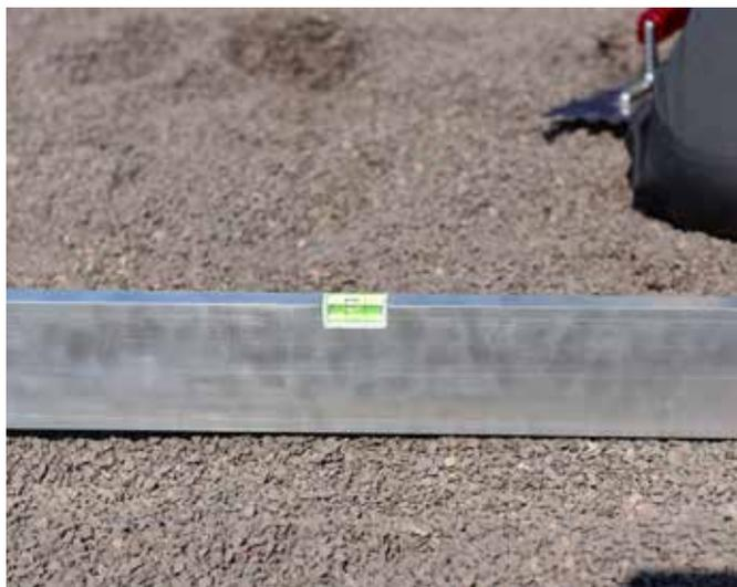
**3** Die Höhe der Tragschicht und die Ausbildung eines Gefälles von mind. 2,0 % sind stets zu kontrollieren.
