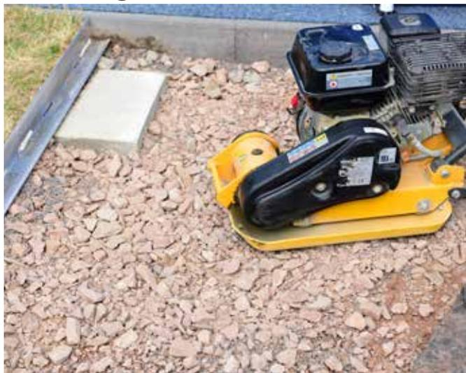
**1** Die Konstruktion ist mit einer umlaufenden, tragfähigen, festen Randeinlassung zu versehen. Die Schotterschicht gewährleistet die Frostsicherheit, ist mind. 30 cm dick auszuführen und lagenweise zu verdichten, um Setzungen innerhalb der Randeinfassung zu vermeiden. Die Schotterschicht sollte dabei bereits ein ausreichendes Gefälle aufweisen
