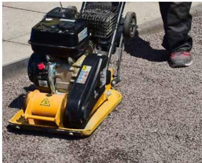
**2** Nach dem Herstellen der Tragschicht wird eine dünne Lage (~10 – 20 mm) aus filterstabilem Splitt (Korngröße  $\approx$  2 – 4 mm) über der gesamten Fläche verteilt und mit einer Rüttelplatte zum gründlichen Verschließen von Hohlräumen in der Tragschicht kompaktiert.
