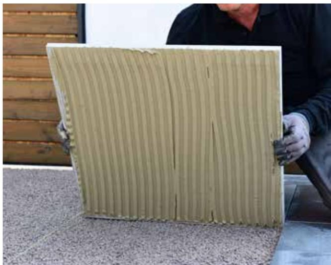
**5** Die Verlegung keramischer Terrassenplatten mit einer Stärke  $\geq$  2 cm erfolgt im Buttering-Verfahren durch das Auftragen von Sopro SFM20 Solitär® FixierMörtel, mit mind. einer 10 mm Zahnkelle auf die Fliesenrückseite.
