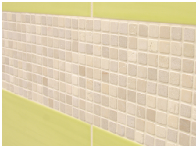
10 Steingut- und Natursteinmosaikflächen verfugt mit Sopro DF 10.
