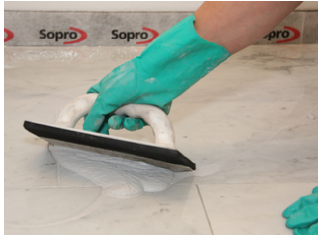
8 Einfugen von Sopro DF 10 in verarbeitungsempfindlichen Naturstein.
