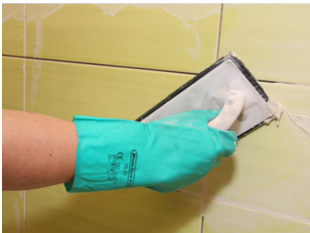
9 Einfugen von Sopro DF 10 in Steingutfliesen.
